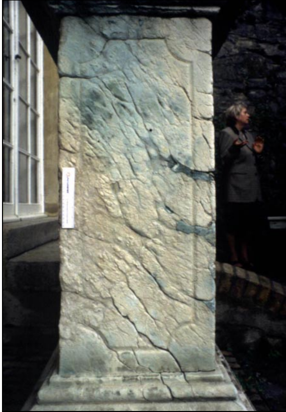
Links: Vorzustand des Postaments, mit fahnenartiger Verfärbung. Rechts: Endzustand des Postaments nach der Behandlung mit der Paste.
