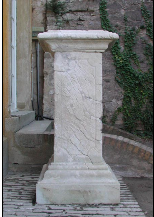
Links: Vorzustand des Postaments, mit fahnenartiger Verfärbung. Rechts: Endzustand des Postaments nach der Behandlung mit der Paste.
