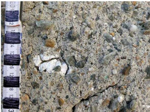
*Ostfassade, Fassadenputz mit Korngrößen bis zu 2 cm und Kalkspatzen bis 3 cm Größe*
