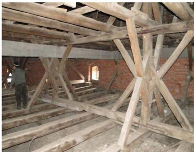
*Chordach, untere Stuhlkonstruktion. Deutlich ist die komplexe Längs- und Queraussteifung zu erkennen. Ebenfalls der Querbalken aus Beton*
