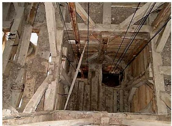
*Das Innengerüst des Dachstuhles bildet einen Schacht für die Uhrenmechanik*
