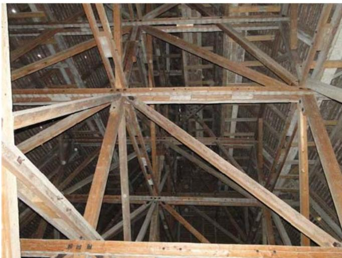
*Dachgefüge Langhaus. Blick in das 17m hohe Raumtragwerk des Daches*
