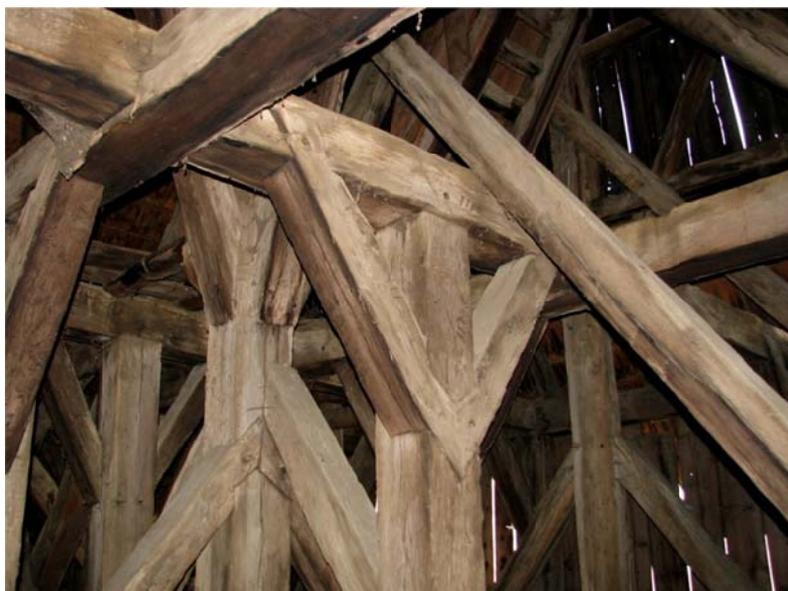
*Die Tragkonstruktion des Glockenturmes besteht aus einem komplexen Gefüge mit hoher Dichte von Baugliedern mit unterschiedlichen Funktionen.*
