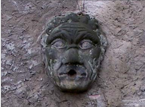
Abb. A120 (links oben) _ Detailaufnahme des nördlichen Maskarons. Auffällig ist die grobe Verputzung im Umfeld des Speiers.
