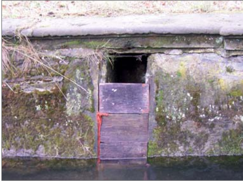
Abb. A62 (oben) _ Mit Holztafeln regelbarer Ablauf vom oberen Becken zum Mündungsbecken der Langen Kaskade.
