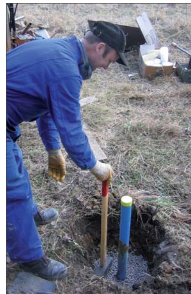
Abb. 4.5 _ Beim Ausbau einer Grundwassermessstelle.
