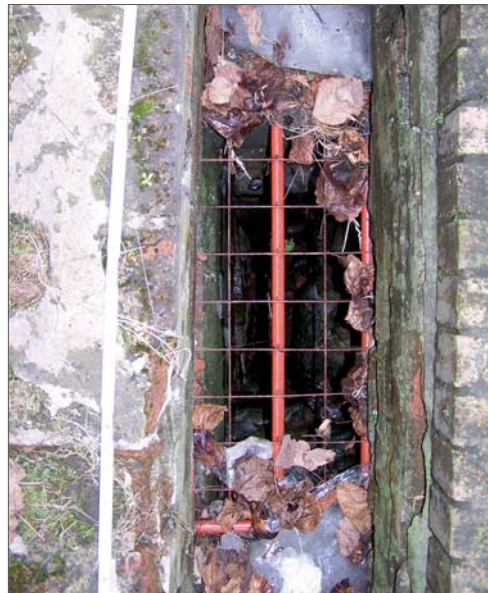
Abb. 5.23 _ Von der vor der Fassade des Refektoriums verlaufenden oberflächlichen Ziegelrinne besteht über einen Schacht eine Verbindung zum unterirdisch darunter verlaufenden Hauptentwässerungskanal.
