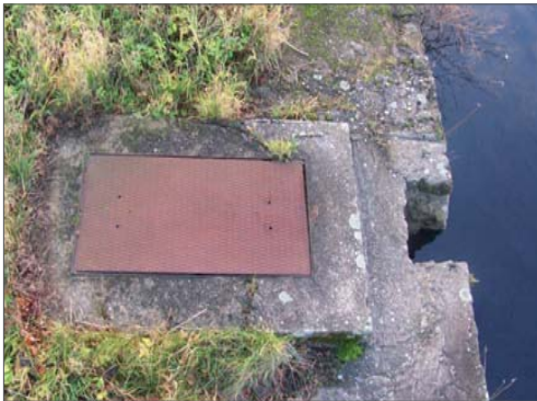
Abb. A11 (links oben) _ Haupteinlass des klösterlichen Wassersystems für Oberflächenwasser im Westen des Mühlbehälters.
