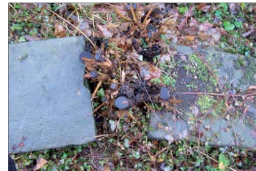
Abb. A160 (rechts) _ Der Rand des Kanals ist schwer von Setzungen beschädigt. Gehölze sprengen mit ihren Wurzeln zusätzlich das Mauergefüge.
