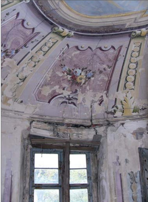
Abb 1.8 _ Die einsturzgefährdeten freskengeschmückten Decken der Pavillons im Oberen Abtgarten.
