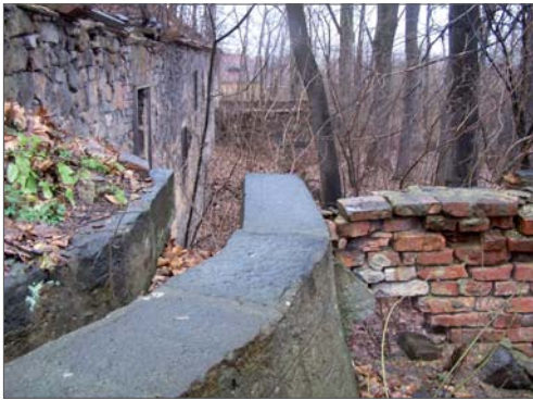
Abb. A175 (links unten) _ Ausgehend vom Kanal überwand das Wasser fallend etwa 2,5 Meter und trieb hier das Mühlrad an.
