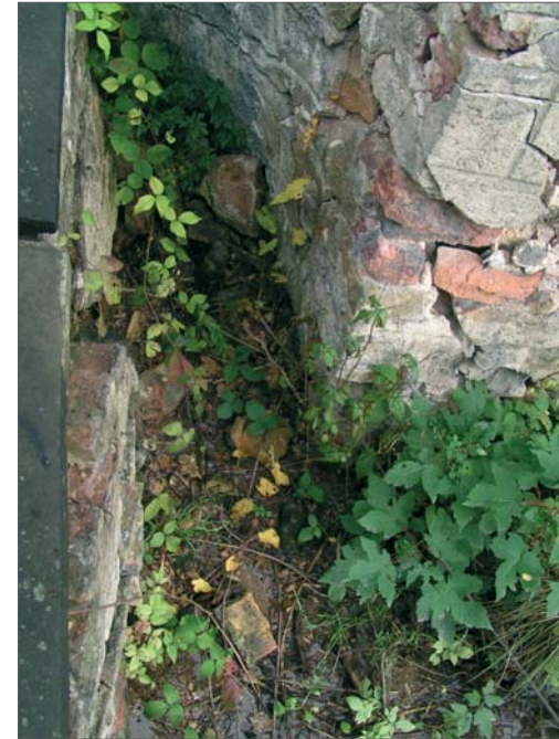
Abb. A29 (rechts oben) _ Wasseraustrittsstelle an der Treppe vor dem westlichen Pavillon im Konventgarten.
