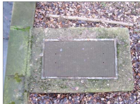
Abb. A75 (unten links) _ Der Ablauf vom unteren Fischbehälter zum Spiegelbecken mit dem nach Planungen von 1968 ergänzten Schacht.
