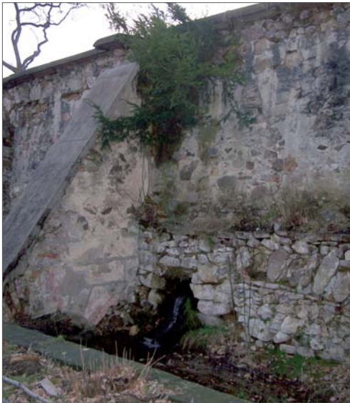
Abb. A136 (oben) _ In der nordöstlichen Ecke des Spiegelbeckens ist eine Wartungstreppe erhalten geblieben. Der Ablaufschacht wurde zwar erneuert, zeigt jedoch noch die historische Form.
