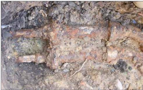
Abb. 8.7 (links oben), Abb. 8.8 (unten) Im Novizengarten wurde die defekte Trinkwasserzuleitung ergraben und erneuert.
