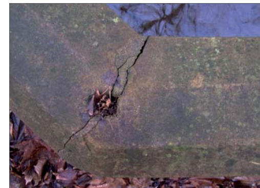
Abb. A103 (rechte Seite Mitte oben) Eine grobe Verarbeitung und Schäden am Mauerwerk charakterisieren das heutige Erscheinungsbild der Langen Kaskade.
