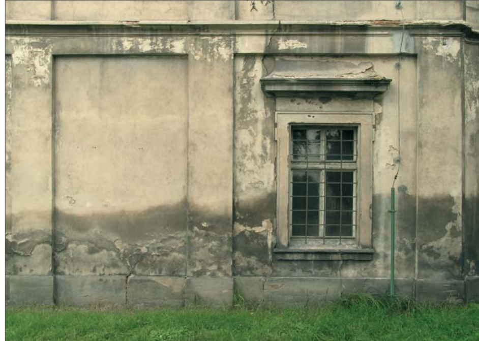
Abb 1.12 _ Besonders deutliche Durchfeuchtungserscheinungen zeigt die Fassade des Sommerflügels im Konventgarten.
