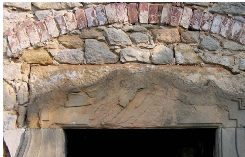
Abb. 6.6 Deutliche Rückverwitterung des Sandsteins am Sturz des Pavillons im Konventgarten
