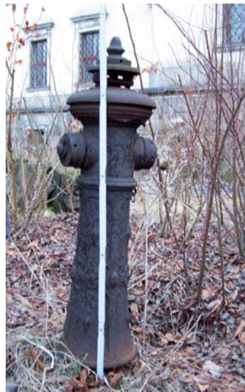
Abb. 5.11 Einer der Hydranten - hier im Abtgarten - , der über die Hochquellenleitung mit Wasser versorgt wurde.
