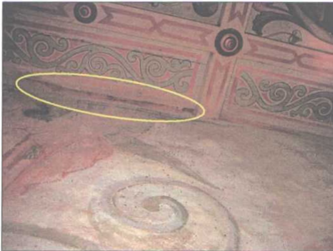
Abb. 3: Stark beflogene Quartierspalte zwischen Mauerwerk und Deckenkonstruktion. Die Kotablagerungen unterhalb der Spalte sind gut erkennbar.
