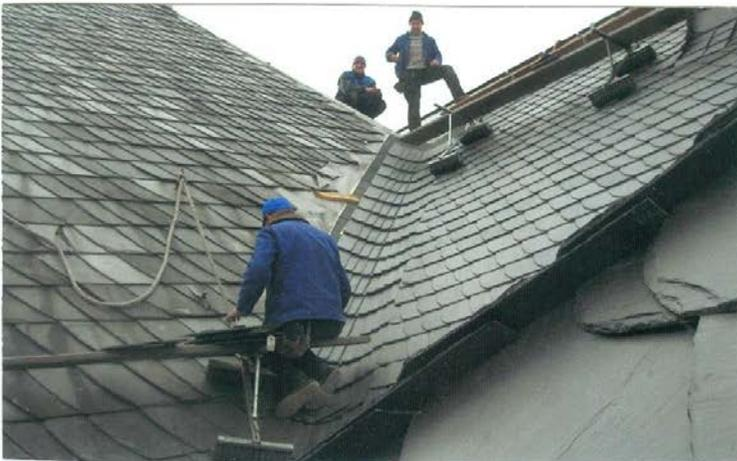
**Bild 4** Die Einbindung des Daches des Brüderhauses in das Dach des Seitengebäudes durch Kehlsteine. Die Schiefer der unteren Reihen des Daches vom Nebengebäude sind entfernt.
