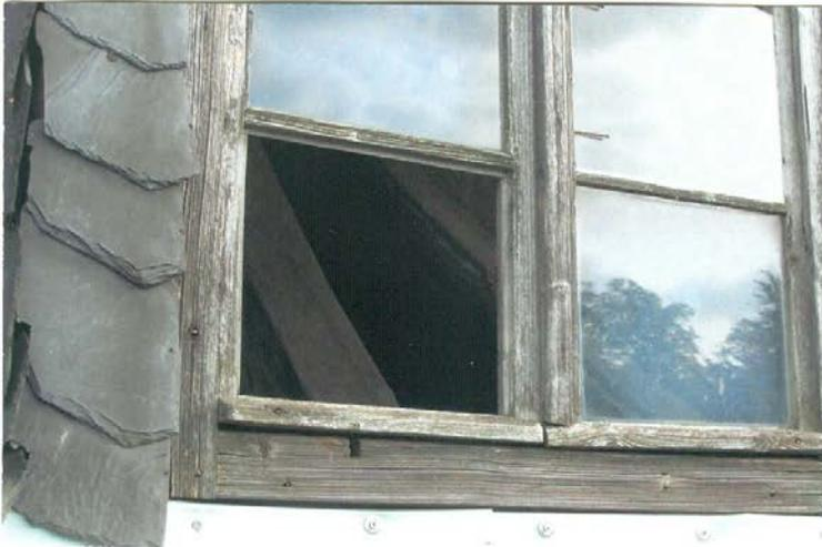
**Bild 3** Detail aus der Frontseite einer Gaube. Mit dem Hammer zugerichteter Schiefer (?) der ersten Deckung.
