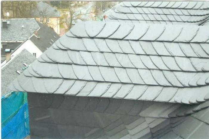
**Bild 12 :** Aus einer Entfernung von wenigen Metern sind nur noch besonders breite Borden sichtbar.
