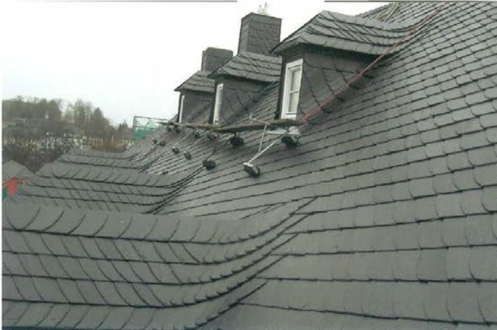
**Bild 8 :** Einbindung eines Gaubendaches in das Dach.
