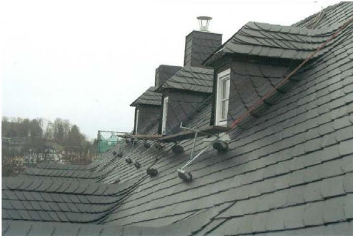
**Bild 6 :** Die Einbindung einer Gaube im Seiten- und Dachbereich durch Kehlsteine in die Decksteine des Daches.
