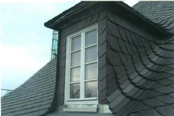
**Bild 7 :** Einbindung der Seitenwand einer Gaube in das Dach.
