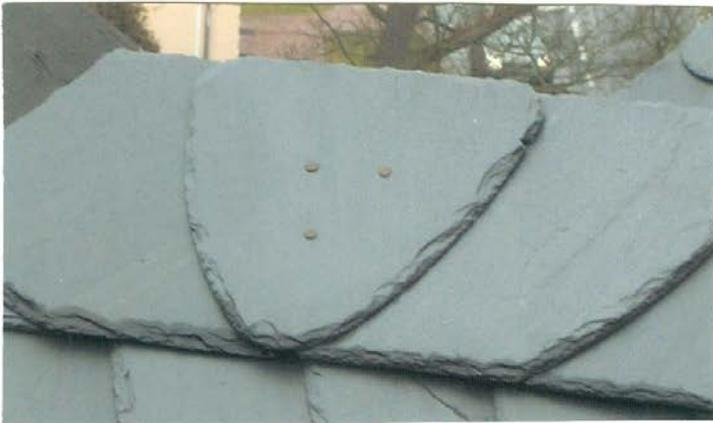
**Bild 9:** Blick auf den First einer Gaube. Der herzförmige Schlussstein wird vom Dachdecker mit dem Hammer zugerichtet und muss mit offen liegenden Kupfernägeln befestigt werden. Auf der Unterseite des Schlusssteines ist meist der Name des Dachdeckers dauerhaft eingeritzt.
