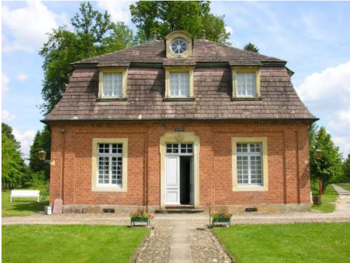
Abb. 1: Pavillon Hildesheim. Dachfläche über dem Eingangsbereich
