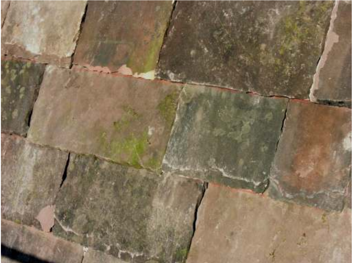
Abb. 7: Fertiggestellte Dachfläche (Ausschnitt)
