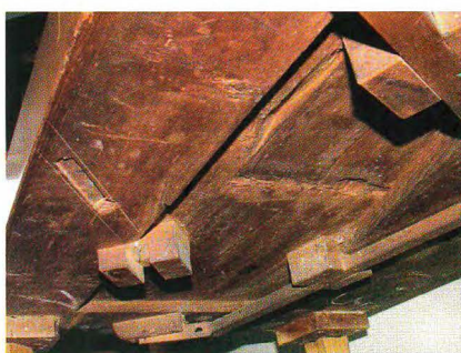
Abb. 15: Fehlender Kniehebel am Unterboden sowie Anobischäden.
