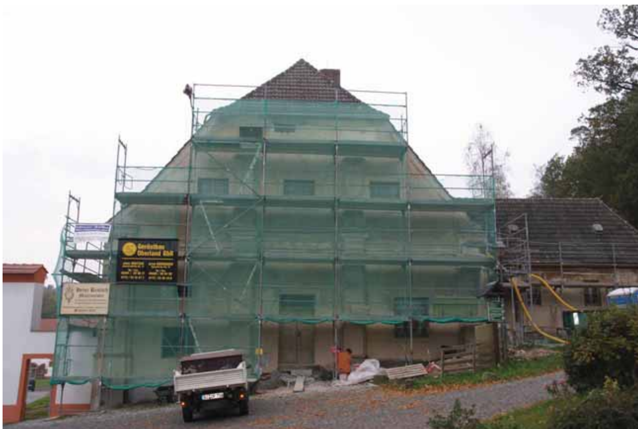
Abb. 69 Beamtenhaus, Giebel, Restaurierung des Giebelbereichs
