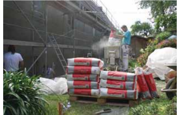
Abb. 62 Beamtenhaus, Nordwestfassade, Putzarbeiten, Aufnahme am 25.08.2010
