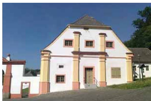
Abb. 71 Beamtenhaus, Schmuckgiebel nach der Restaurierung (18.05.2011)
