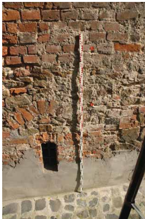
Abb. 20 Beamtenhaus, Nordwestfassade, M_K_TP4
