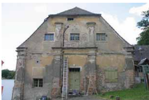
Abb. 70 Beamtenhaus, Schmuckgiebel vor der Restaurierung (07.07.2010)
