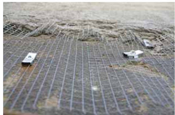
Abb. 64 Beamtenhaus, Nordwestfassade, Sicherung barocker Putzoberflächen, Aufnahme am 25.08.2010
