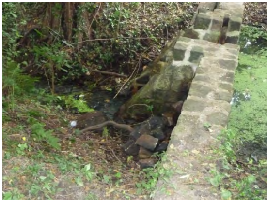
Im Sept.'12 instand gesetztes Wehr am östlichen Auslauf
