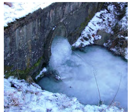
Messstelle Z18 am 27.2.12
