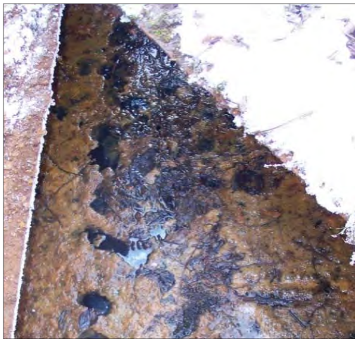
Algen im Arteserschacht, 27.01.12
