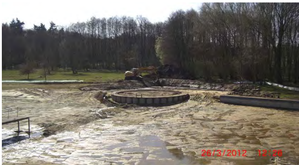
Anlegen der Renaturierungszone
