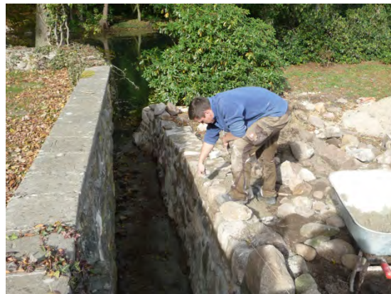
Bau Natursteinmauer am südwestl. Zulauf, Okt.'10
