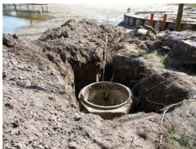
Betonschacht für Saugpumpe
