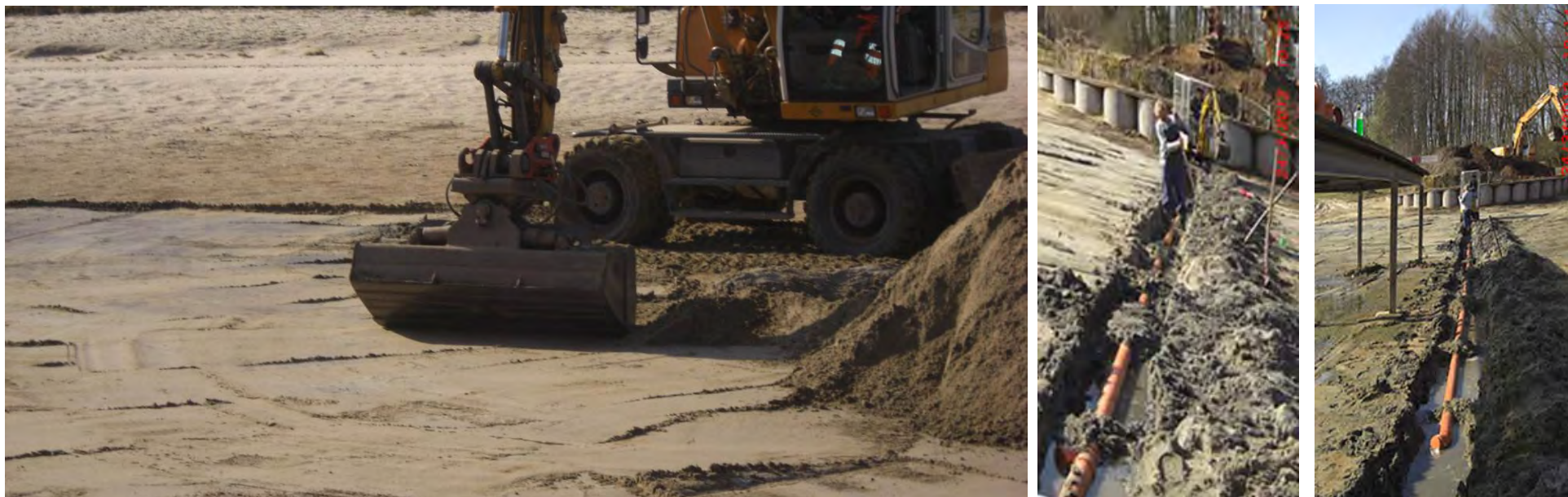
Austausch Sediment Beckenboden (Blaualgenschicht, oberste 5 -10 cm) und Schachtung Rohrgraben für Wasserpumpe
