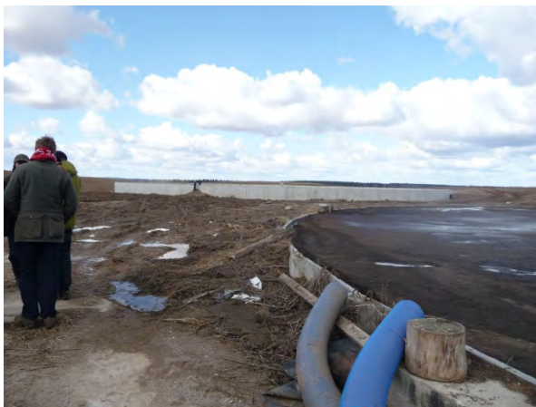
Güllebecken, 500.000 cbm Fassungsvermögen
