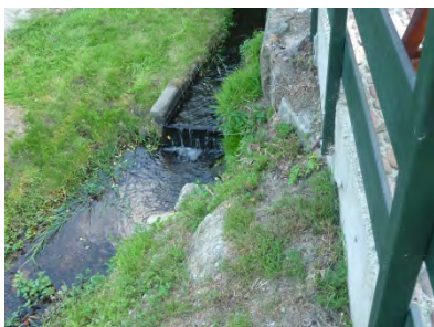
Graben am Kornspeicher
