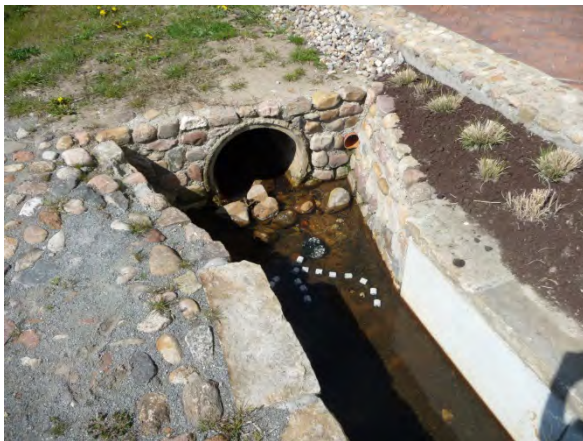
Pferdeschwemme: Einsetzen Keramik-Pipes am 20.4.12
