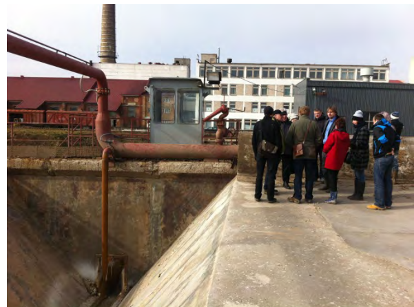
Zuckerrüben-Waschanlage (Foto: M. Vongries)
