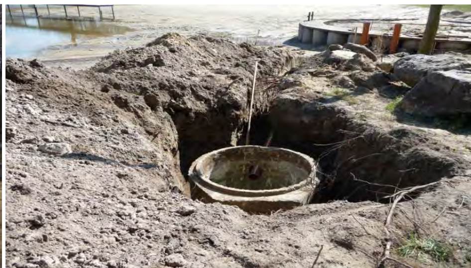
Schacht für Wasserpumpe
