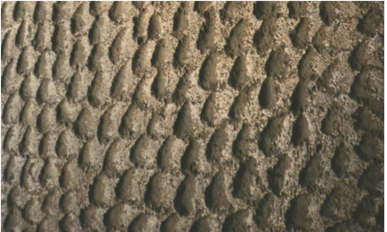
Abb. 26: Der Kellenstechputz mit seiner charakteristisch ausgehobenen Kellenstruktur
