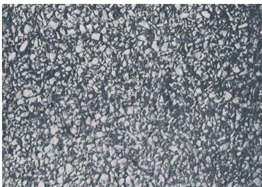
Abb. 78: Grana Waschputz mit hell hervor stehendem Zuschlagskorn
