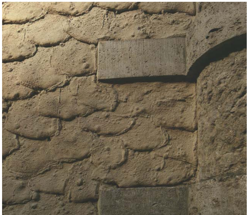
Abb. 12: Variation des Kellenwurfputzes mit klar definiertem, fladenartigem Anwurf
