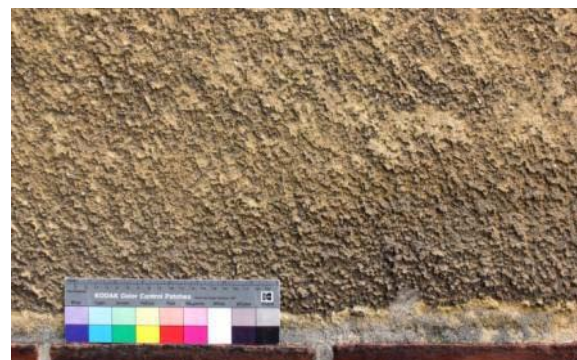
Abb. 90: Gipskrusten und Absanden am Wohnhaus Schöneiche (Objekt-Nr.: 2590).
