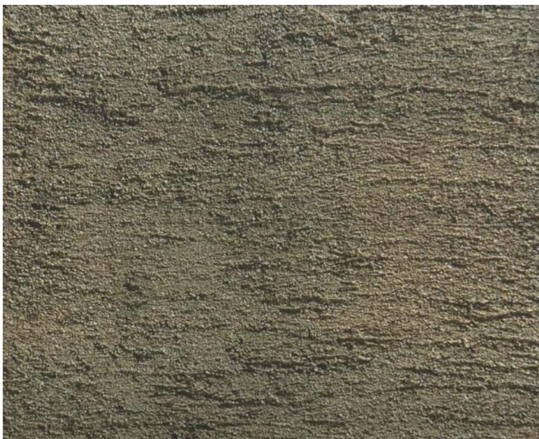
Abb. 54: horizontal verschleppter Putz
