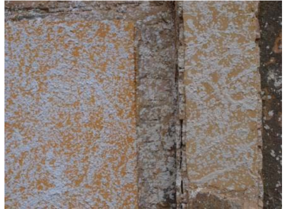
Abb. 467: Probeflächen mit Baustellenmischung
