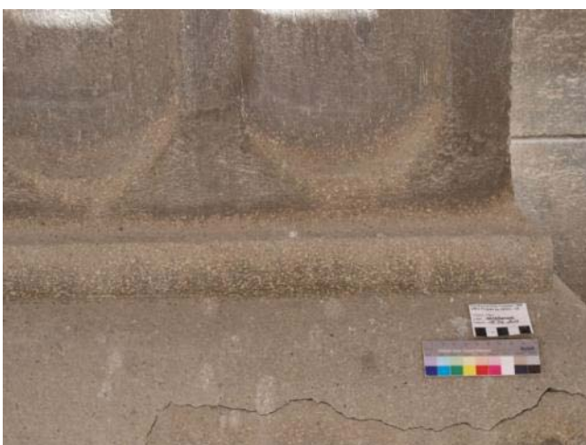
Abb. 497: Steinputz Nordfassade Nordflügel Pilasterreihe, Auswaschungen mit hell hervortretenden Kalksteinzuschlägen, oben Krustenbildung erkennbar. Unten im Bild konstruktionsbedingter Riss mit Hohllage
