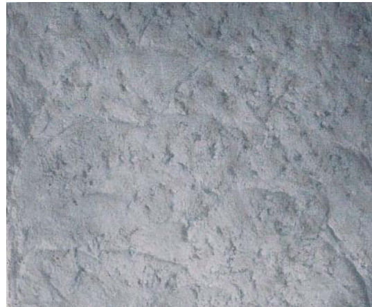
Abb. 23: Terranova- kreisförmiger Draufelstrich, zurückhaltend strukturiert
