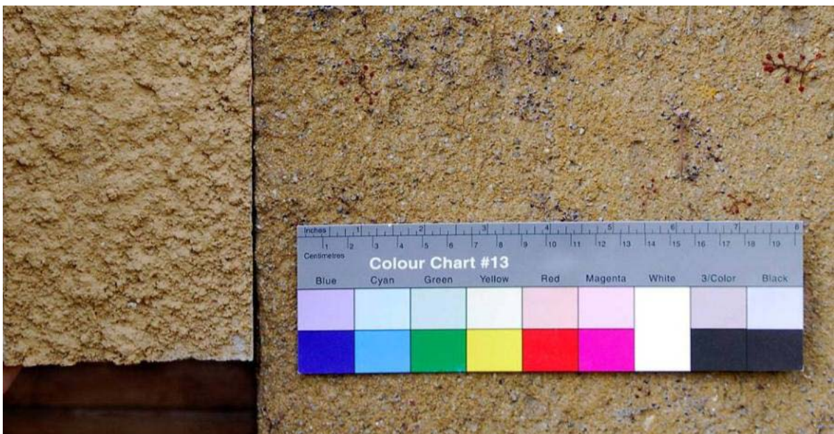
Abb. 477: Wohnhaus Wilhelmshorst, links im Bild nachgestellter Edelputz auf Probeplatte, rechts Originalputz in situ
