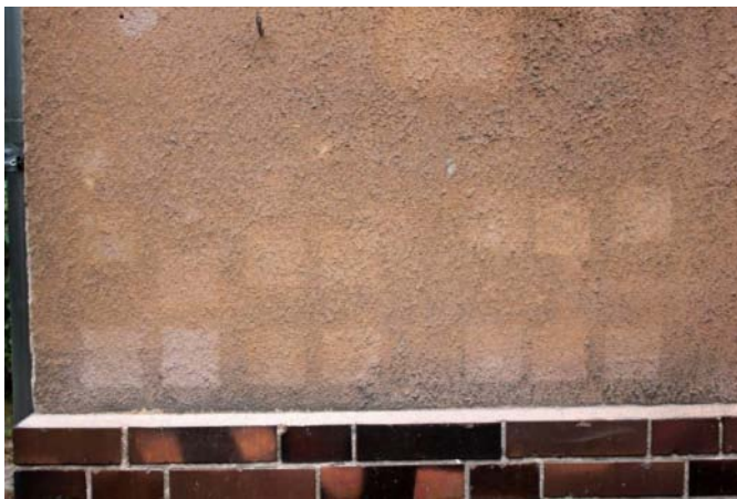
Abb. 407: Reinigungsergebnisse im Vergleich (je Felder-Paar übereinander von links nach rechts)
