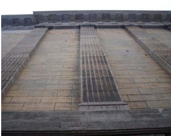
Abb. 486: Steinputz Nordfassade Mittelbau Nord
