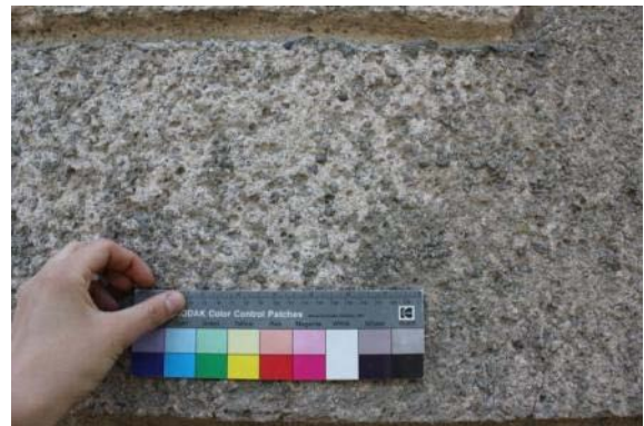
Abb. 110: Oberflächliches Absanden an der Villa Adlon (Objekt-Nr.: 2587).
