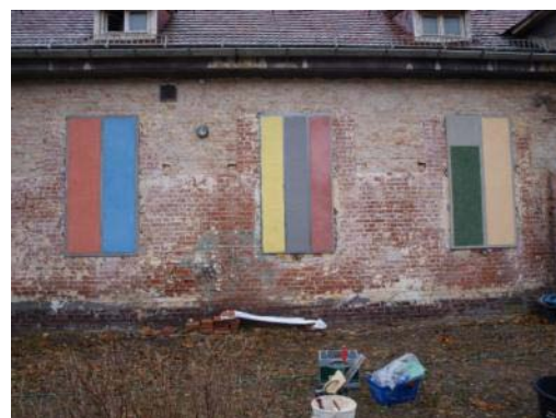
Abb. 156: Edelputzmuster am Casinogebäude der FHP
