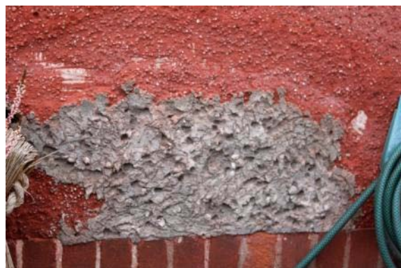
Abb. 146: Optisch in Farbe und Textur herausstechende Ergänzung an einer Fassade in der Liningstraße der Hufeisensiedlung (Objekt-Nr.: 1200). Die Abplatzungen am Original sprechen für eine zu hohe Härte der Ergänzung.
