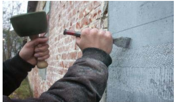
Abb. 163: Zähnen der Probefläche
