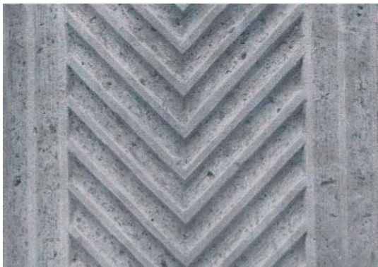
Abb. 76: Rautenförmig bearbeitet
