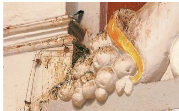
Abb. 93: Besondere Belastung durch Vogelkot an Ruheplätzen von Taubenschwärmen, wie hier auf Gesimsen
