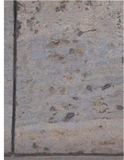
Abb. 480: Detail Südfassade NF
