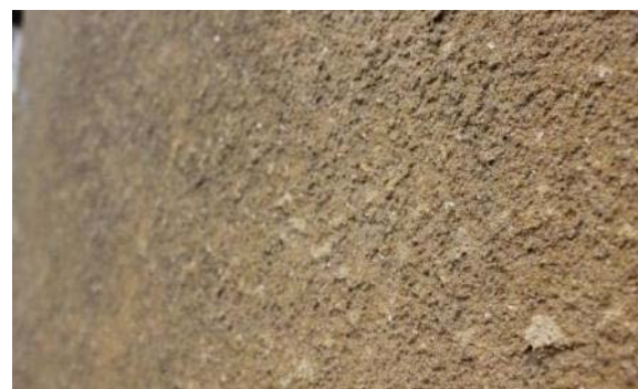
Abb. 89: Oberflächliche Ablagerungen, Fassade des Wohnhauses Schöneiche (Objekt-Nr.: 2590).
