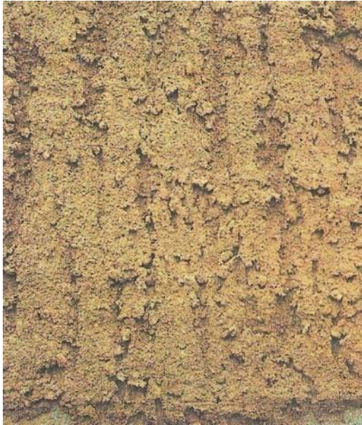
Abb. 52: vertikal verschleppter Putz
