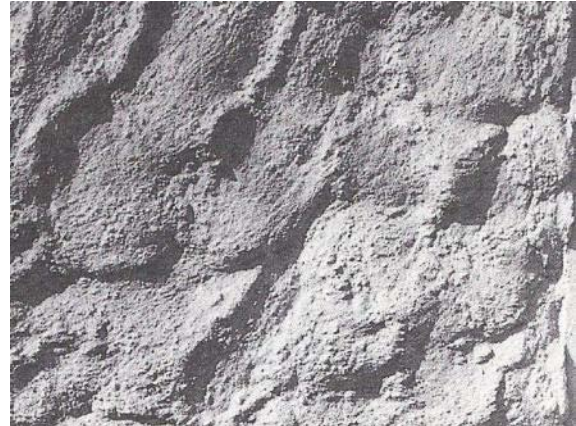
Abb. 10: Variation des Kellenwurfputzes mit eher unregelmäßiger Oberflächen-Struktur
