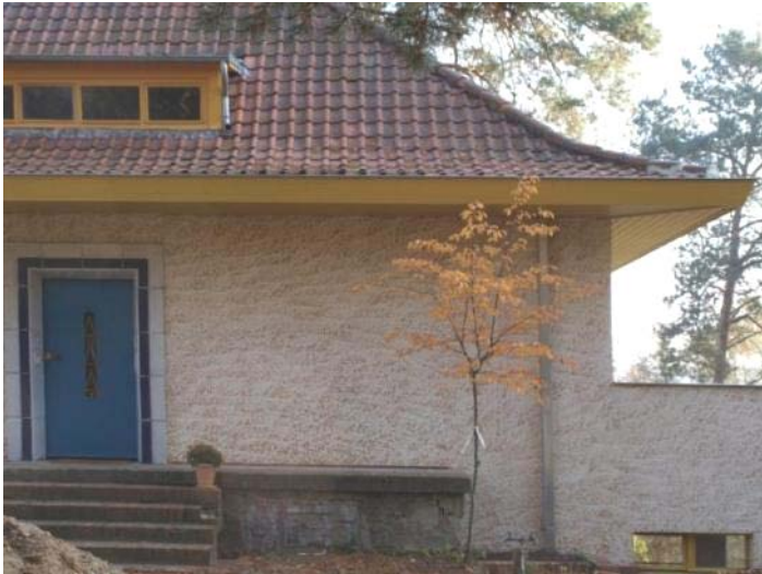
Abb. 468: Handwerkliche Nachstellung mit Werkrockenmörtel, Ausführung Ende 2010
