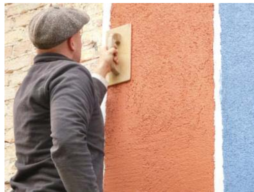
Abb. 154: Musterfelder mit Putz der Fa. Sakret
