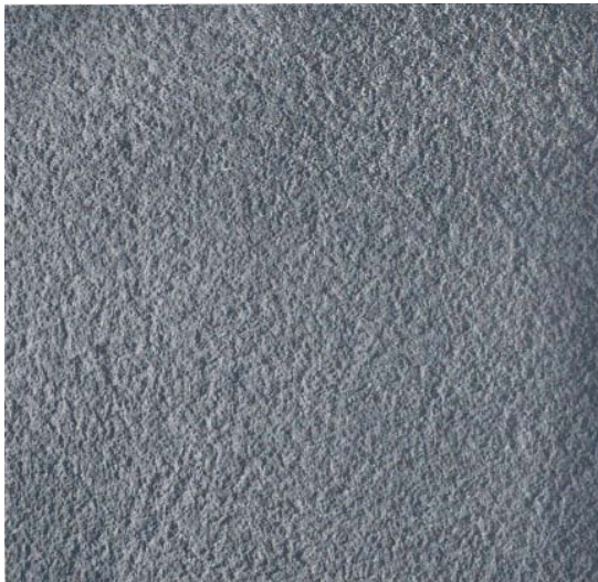
Abb. 66: Terranova - feinkörniger Kratzputz
