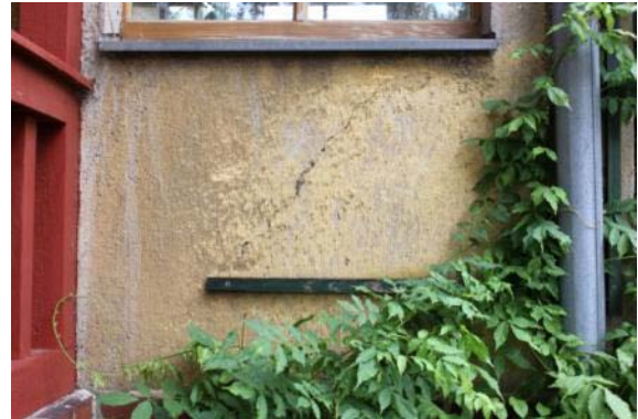
Abb. 109: Partielles Absanden am Haus Schöneiche (Objekt-Nr.: 2590), was teils bis zum Verlust zum Oberputz führte.
