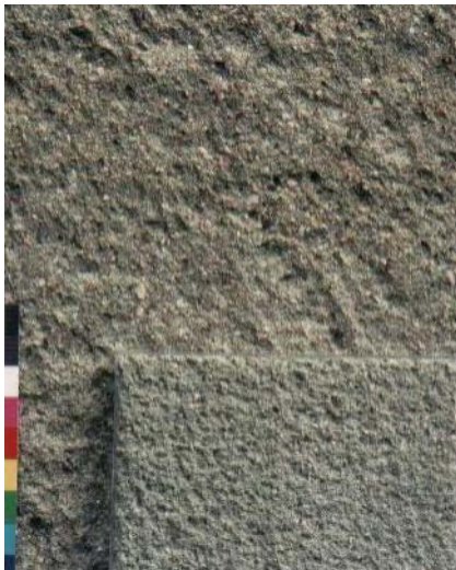
Abb. 364: Kratzputznachstellung Villa Vehse , angepasst an oberflächliche Verschmutzung
