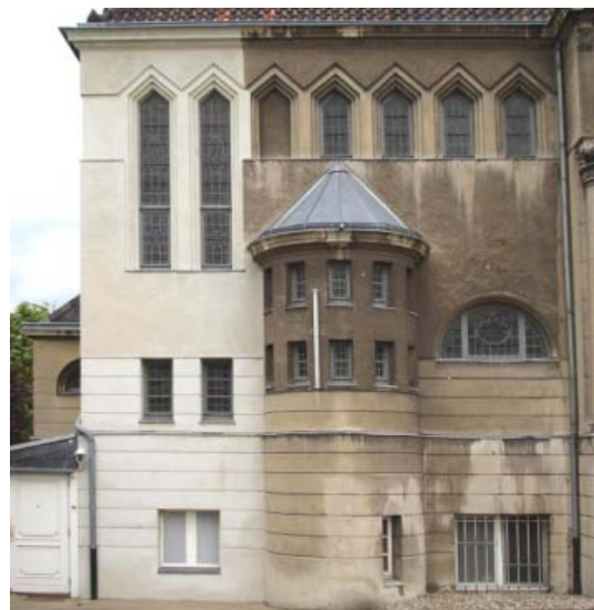
Abb. 372: Lessing-Loge, Ostfassade, mit Pilotfläche, nach 6 Monaten
