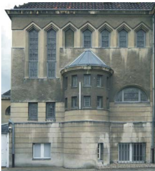
Abb. 371: Lessing-Loge, Ostfassade, vor Bearbeitung
