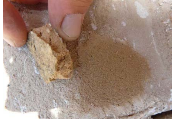
Abb. 465: Anpassen des Putzes an die originale Farbigkeit, 2010
