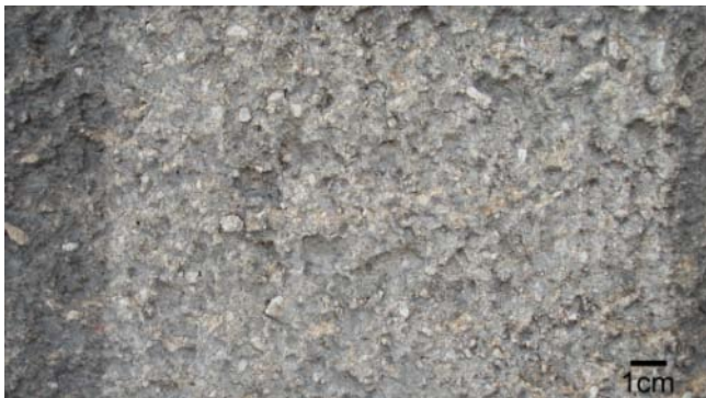
Abb. 367: Lessing-Loge, Kratzputz mit Mikrofeinstrahlgerät gereinigt
