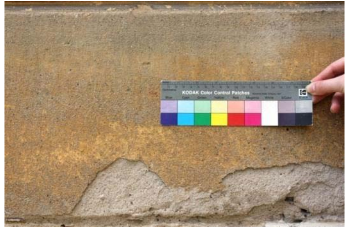
Abb. 57: verriebener Glattputz am Goethe-Gymnasium in Berlin. (Objekt-Nr.: 4320)
