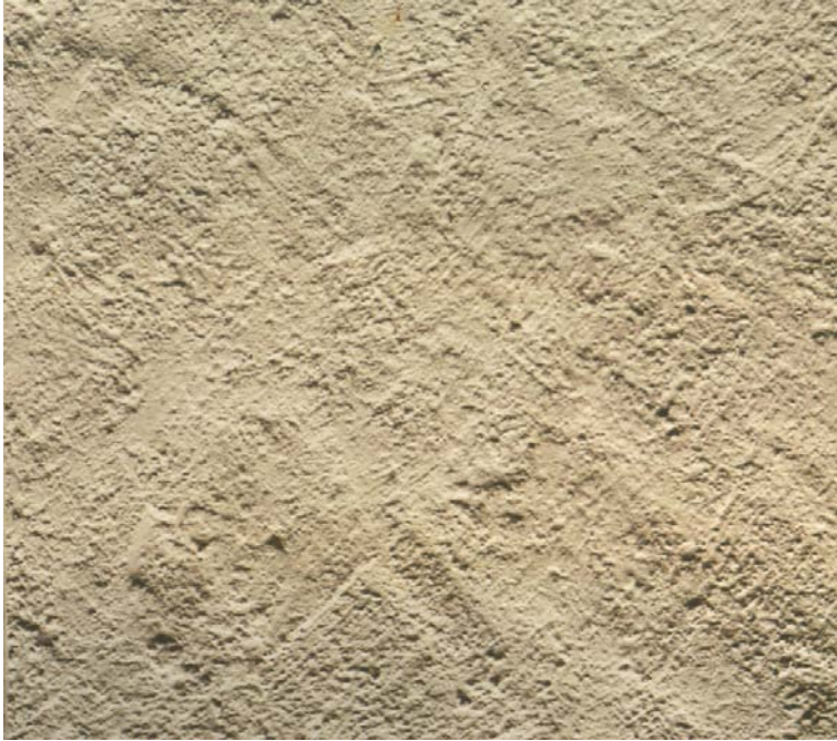
Abb. 50: Rappputz mit erkennbaren Werkzeugspuren
