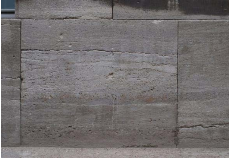
Abb. 479: Natursteinverkleidung an Nordfassade Nordflügel-Kopfbau
