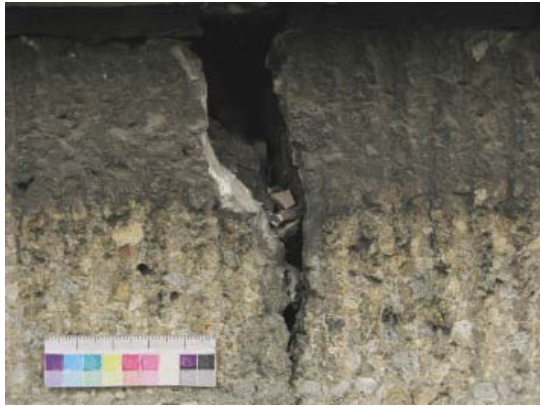
Abb. 268: KuFa 03 Balusterband, oberer Rissbereich des Zwischenfeldes mit glatter Spiegelfläche
