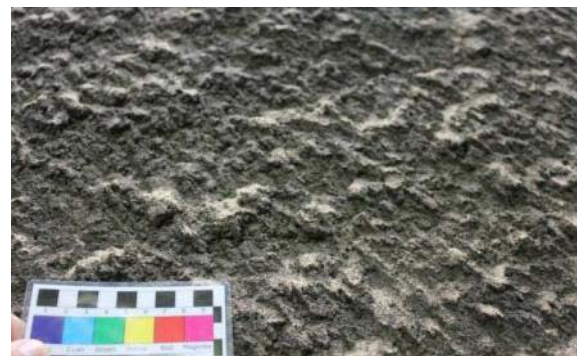
Abb. 88: Die gleichen Schadenphänomene (Gipskrusten) am Säuglingskrankenhaus in der HansasträÙe (Obj.-Nr.: 4006).
