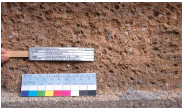
Abb. 404: Endzustand einer bearbeiteten, groben Kratzputz-Wandfläche am Beispiel des Glasbruchs 100
