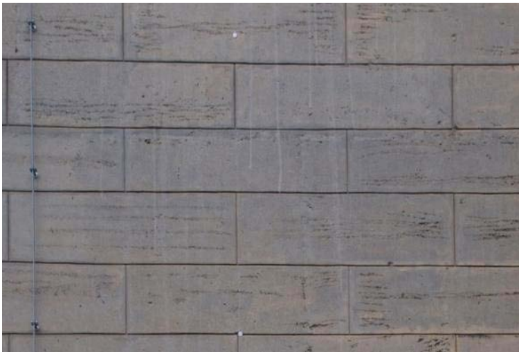
Abb. 481: Steinputzfassade mit Fugenschnitt an Nordfassade Mittelbau Nord
