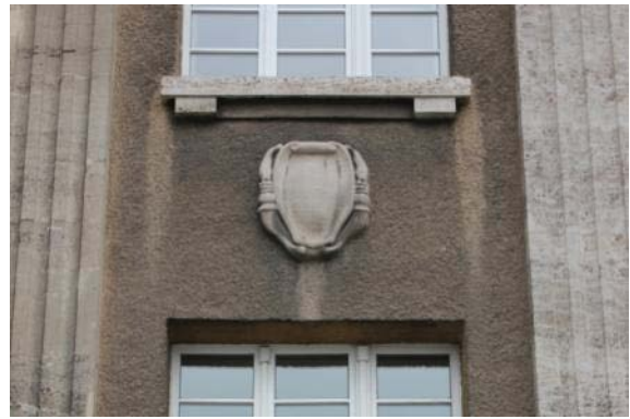
Abb. 119: Auswaschungen an der Fassade des Rathaus Spandau (Objekt-Nr.: 4210).
