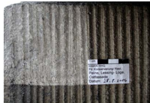
Abb. 368: Lessing-Loge, Steinputz mit Mikrofeinstrahlgerät gereinigt
