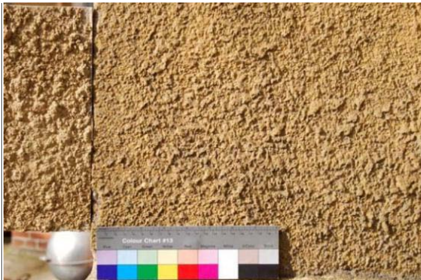
Abb. 476: Wohnhaus Schöneiche, links im Bild nachgestellter Edelputz auf Probeplatte, rechts Originalputz in situ
