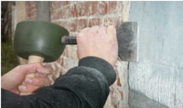
Abb. 162: Scharrieren der Probefläche
