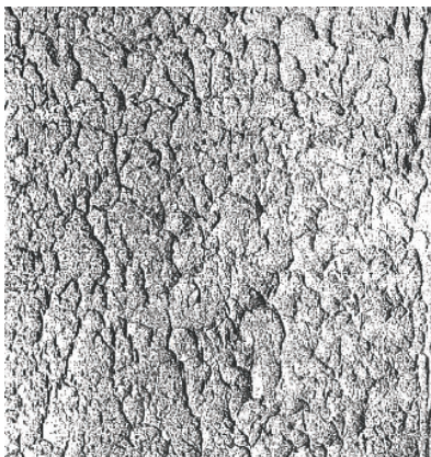
Abb. 31: typische Oberflächenwirkung eines Patschputzes
