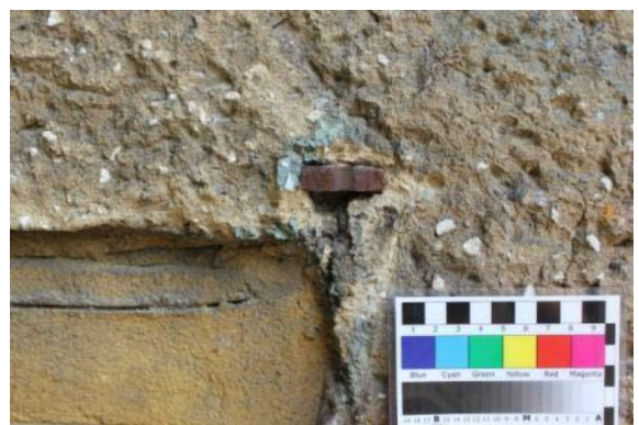
Abb. 124: Rissbildung bis hin zur Absprengung ganzer Putzschollen durch Metallkorrosion an der Kirche in der Baumschulenstraße (Objekt-Nr.: 4311).
