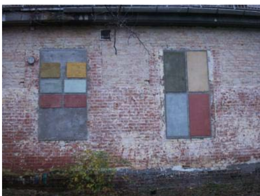
Abb. 155: Steinputzmuster am Casinogebäude der FHP
