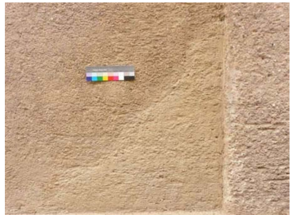
Abb. 474: Liebermann-Villa, Detailansicht mit Ausbesserung (2002) des Fassadenputzes
