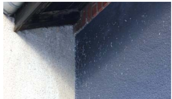
Abb. 94: Besondere Belastung durch Vogelkot im Bereich der Nistplätze von Mauerseglern in der Miningstraße der Hufeisensiedlung (Objekt-Nr.: 1200).
