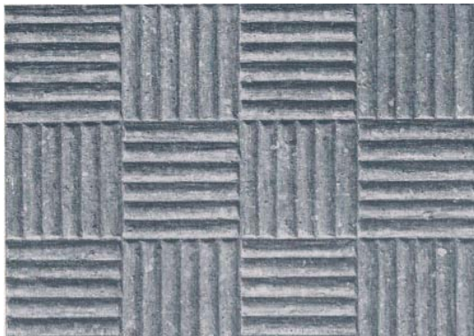
Abb. 74: Hohlkehlen schachbrettartig angelegt
