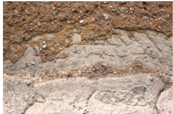
Abb. 111: Starkes Absanden an der Villa Amundsenstraße (Objekt-Nr.: 2588).
