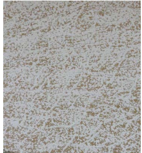
Abb. 468: Handwerkliche Nachstellung mit Werkrockenmörtel, Ausführung Ende 2010
