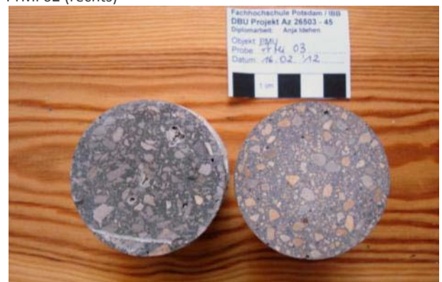
Abb. 558: Bestandsputz (links) und Steinputzmörtelprobe PrMi 03 (rechts)
