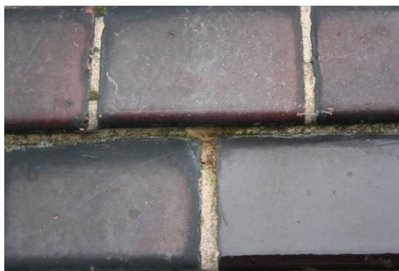
Abb. 33 (10:25), Moosbewuchs entfernt, keine Schäden (Löcher) unterhalb des Moos zu finden
