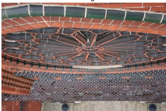
Abb. 42 unterer Teil des Rosettenbogens ausgefüllt um Wasserhaltung zu vermeiden
