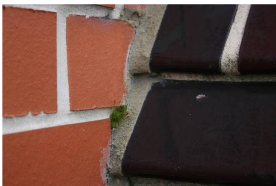
Abb. 10 Pfeilervorlage 4, oben, (10:03), Anschluss mit Epoximörtel, Moosbewuchs
