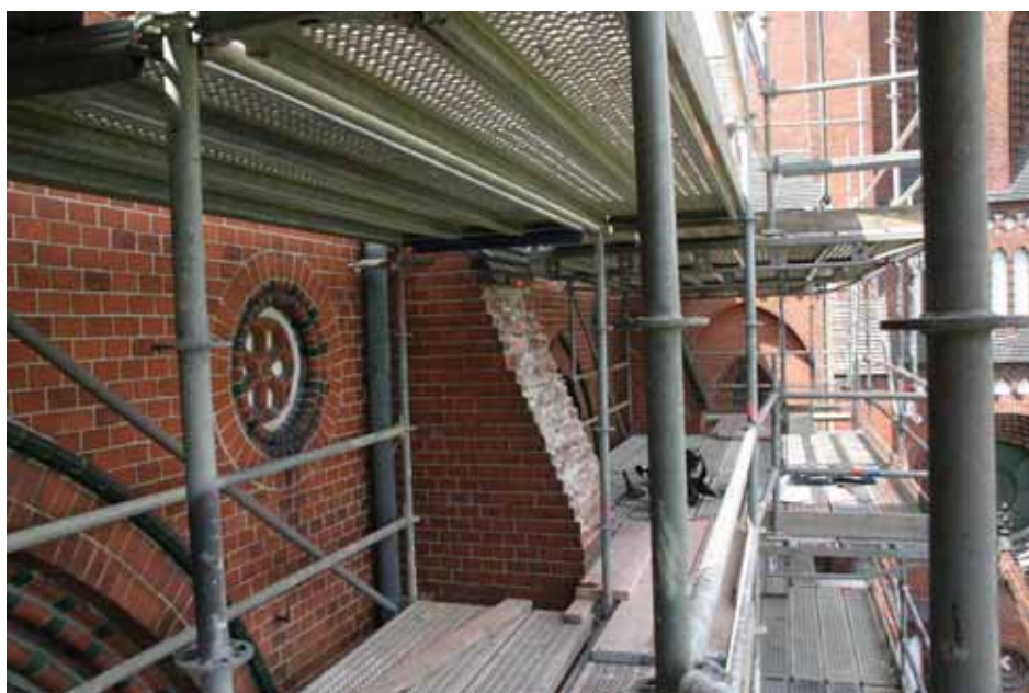
Abb. 1 Görlitz, Kathedrale St. Jakobus, Untersuchung feuchtegeschädigter Pfeilervorlagen
