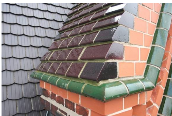
Abb. 52 Pfeilervorlage 3, oberer Abschluss (11:33), Fugenmörtel grün, schadensfrei
