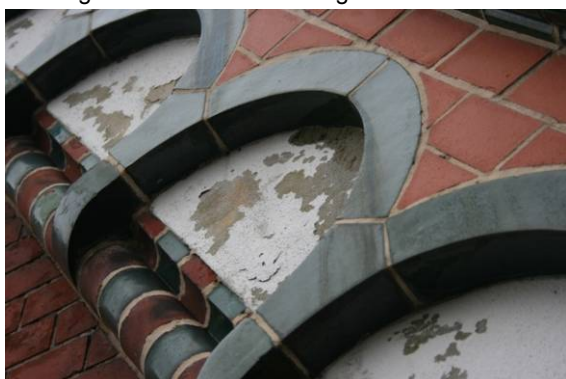
Abb. 26 (10:17) Putzschäden in Rundbögen
