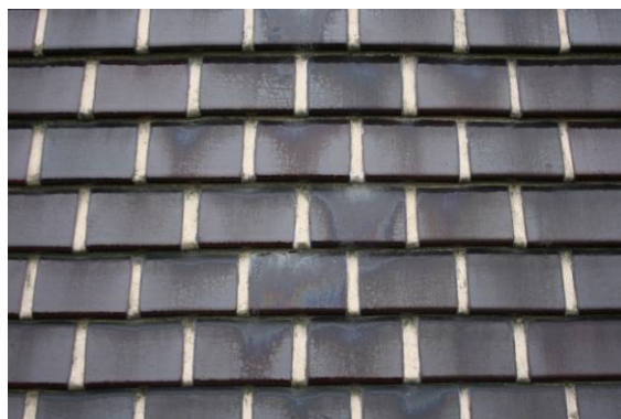
Abb. 23 Glasierte Ziegel, Rajasil Fugenmörtel spritzfähig MGIIa
