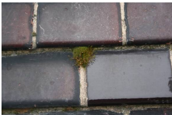
Abb. 32 Gesims Mitte Westgiebel, (10:25), Moosbewuchs
