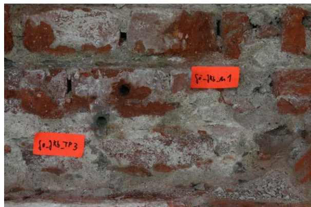
Abb. 2 Görlitz, Jakobuskathedrale, N-Seite, Pfeiler 18, ca. 16-17 m über GOK, Bereich Abdeckung, Probenahmepunkt Setzmörtel Gö-Jbk_M1
