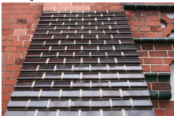
Abb. 22 Glasierte Ziegel, Rajasil Fugenmörtel spritzfähig MGIIa
