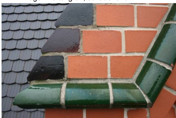
Abb. 54 Pfeiler 3, h=18 m (11:33), Fugenmörtel grün, schadensfrei
