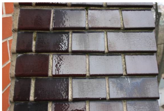
Abb. 9 Pfeilervorlage 4, oben, (10:03), Anschluss der glasierten Ziegel an das Ziegelmauerwerk mit Epoximörtel, könnte sauberer ausgearbeitet sein, Empfehlung: Eindrücken/Ausbilden einer Rinne
