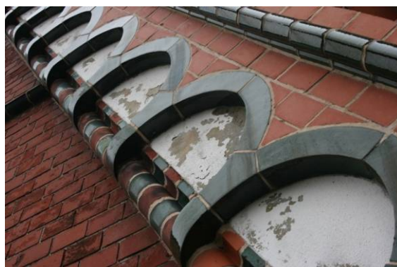
Abb. 27 (10:17) Putzschäden in Rundbögen
