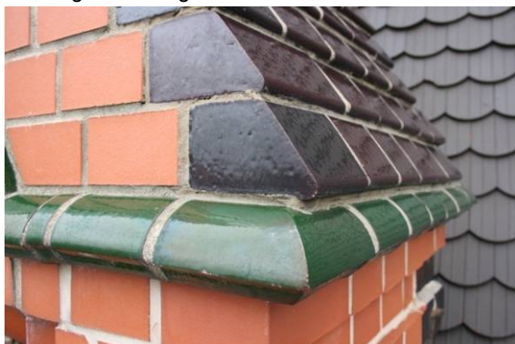
Abb. 60 Pfeiler 4, ganz oben, h=20 m (12:30), Anschluss der glasierten Ziegel an das Ziegelmauerwerk mit Epoximörtel
