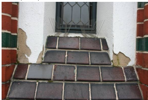
Abb. 39 (10:30) Putzschäden am Gewände, Ablösen einer 5-mm dicken Lage im unteren Bereich
