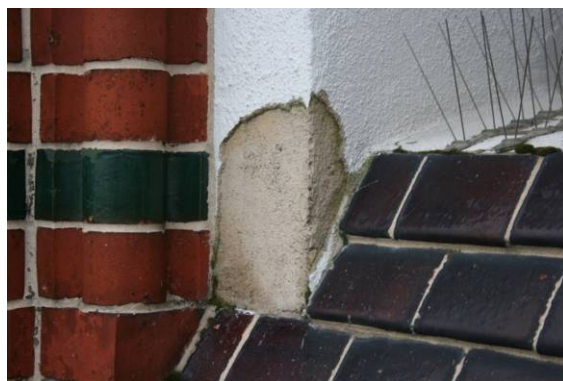
Abb. 41 (10:30) utzschäden am Gewände, Ablösen einer 5-mm dicken Lage im unteren Bereich
