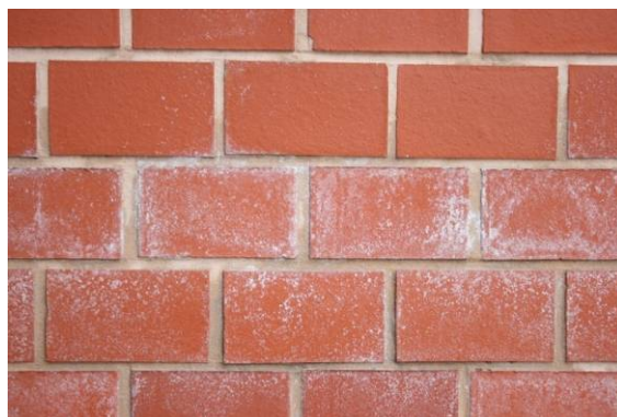
Abb. 49 Pfeilervorlage 3, h=10 m (11:30), Kalkausblühungen mit klarem Horizont
