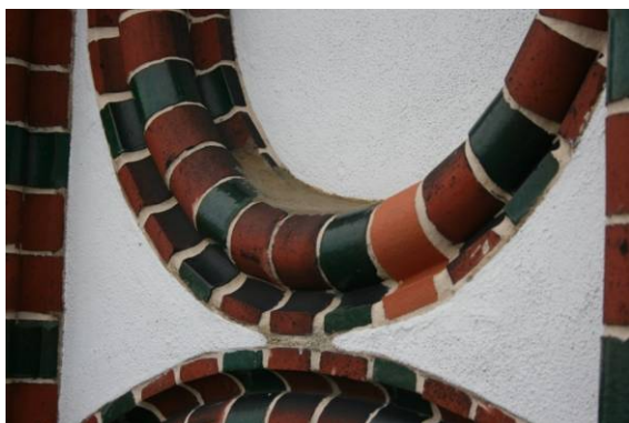
Abb. 24 (10:16), unterer Teil des Rosettenbogens ausgefüllt um Wasserhaltung zu vermeiden
