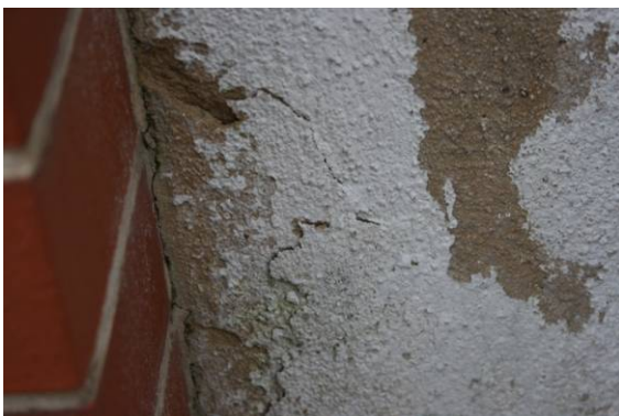
Abb. 6 Pfeilervorlage 4, oben, Farbe blättert ab und Putzschäden, schaliges Ablösen (9:56)
