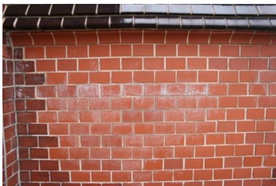
Abb. 48 Pfeilervorlage 3, h=10 m (11:30), Kalkausblühungen mit klarem Horizont
