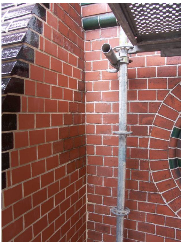
Abb. 10 Pfeiler 19, Rückbau und Einbau neuer Ziegel
