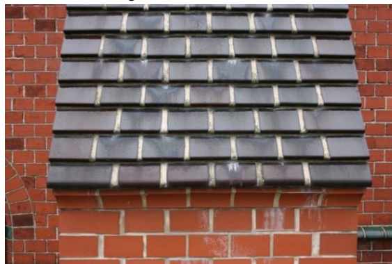
Abb. 19 (10:15) Glasierte Deckung, leichte Ausblühungen unterhalb
