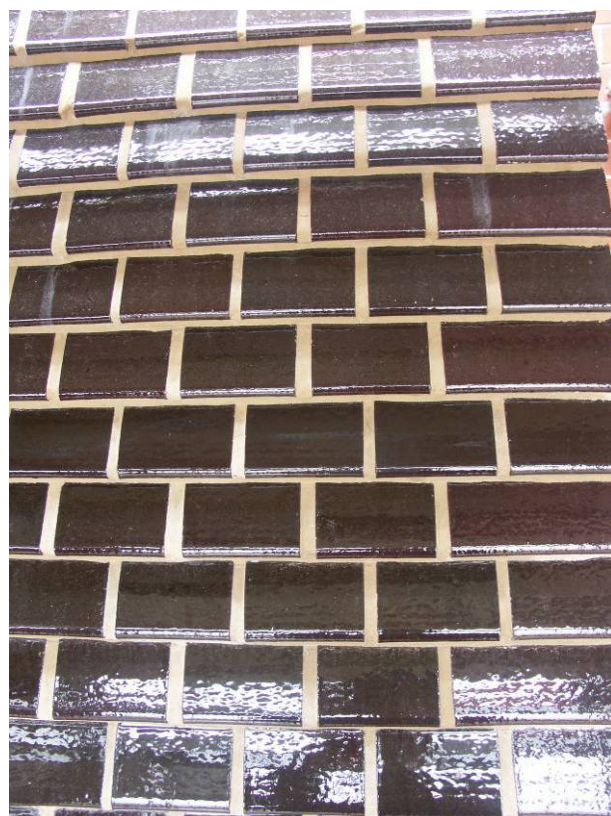
Abb. 11 Pfeiler 19, Rückbau und Einbau neuer Ziegel
