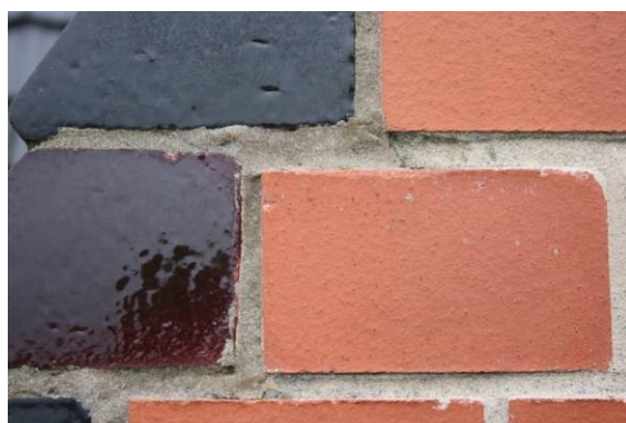
Abb. 55 Pfeiler 3, h=18 m (11:33), Fugenmörtel grün, schadensfrei
