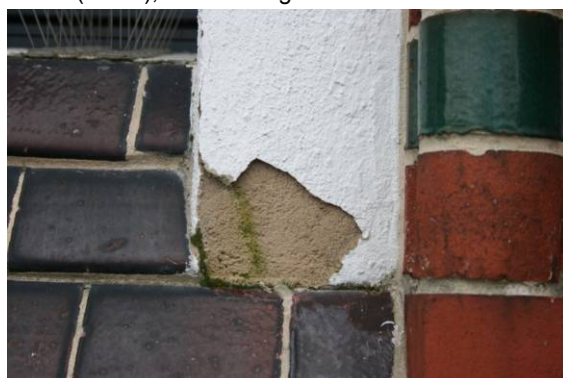
Abb. 31 Fenster Mitte, Gewände (10:25), Lose Putzscholle, abgenommen, Probe: Gö-Jbk_P1
