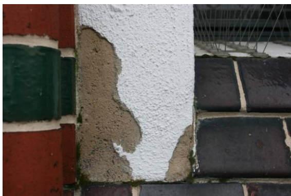
Abb. 40 (10:30) utzschäden am Gewände, Ablösen einer 5-mm dicken Lage im unteren Bereich
