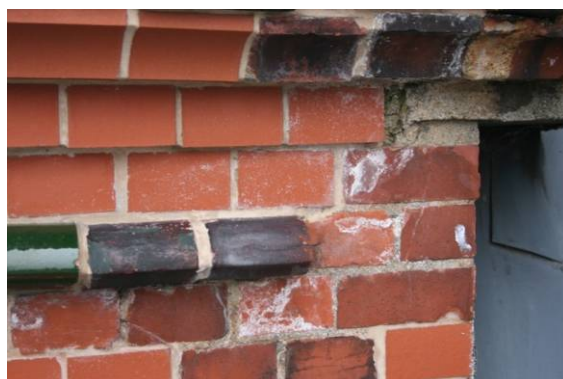
Abb. 59 h=18 m (12:30), Salzausblühungen im Anschlussbereich
