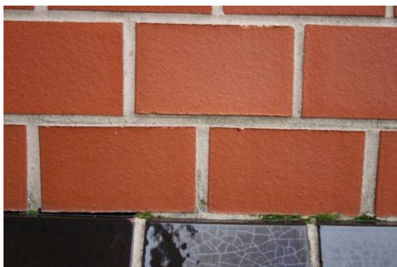
Abb. 16 Offene Fuge im Anschluss
