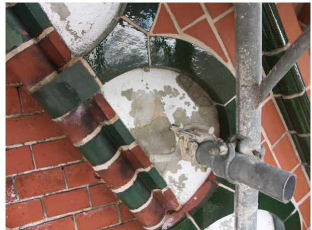
Abb. 3 Rundbögen, Farbe blättert ab und Putzschäden, schaliges Ablösen
