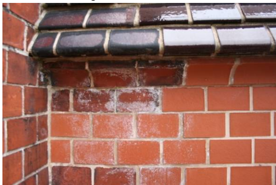
Abb. 18 (10:08) Ausblühungen unterhalb Deckung auf Alt- und Neuziegeln
