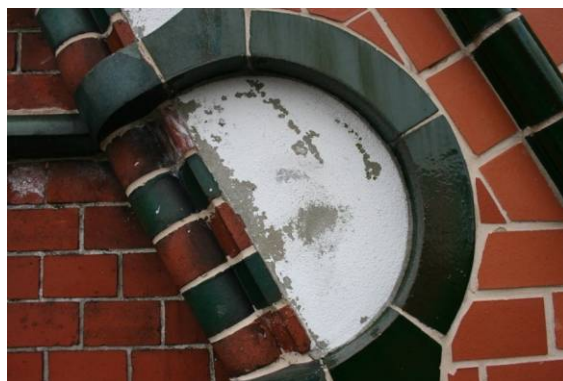
Abb. 25 (10:17) Putzschäden im Rundbogen
