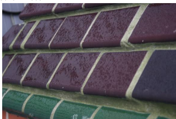
Abb. 53 (11:33), Fugenmörtel grün, schadensfrei
