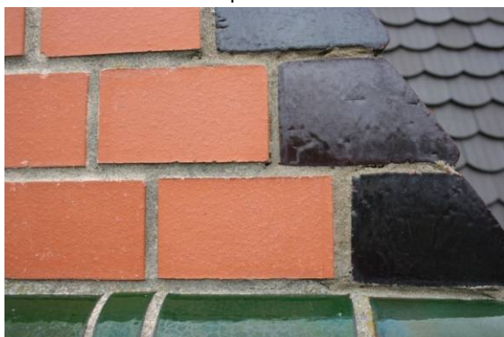
Abb. 62 Pfeiler 4, ganz oben, h=20 m (12:30), Anschluss der glasierten Ziegel an das Ziegelmauerwerk mit Epoximörtel
