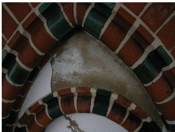
Abb. 6 Görlitz, Jakobuskathedrale, NW-Seite, geschädigte Putzrücklagen im Spitzbogen, Probenahmepunkt GK13_ES1
