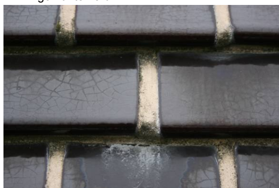
Abb. 21 Glasierte Ziegel, Rajasil Fugenmörtel spritzfähig MGIIa
