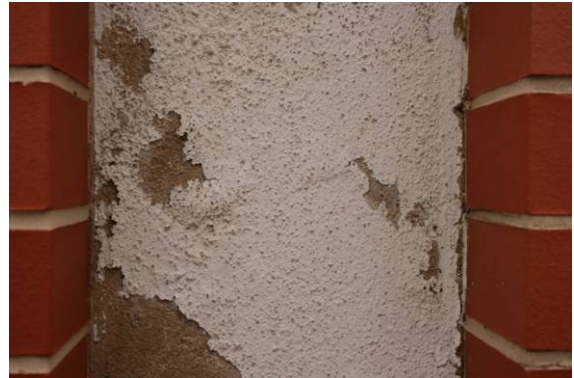
Abb. 3 Pfeilervorlage 4, oben, (9:50), Farbe blättert ab
