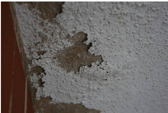
Abb. 4 Pfeilervorlage 4, oben, (9:50), Farbe blättert ab
