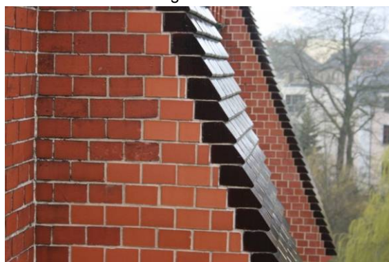
Abb. 43 Pfeilervorlage 4, Anschlüsse alte und neue Ziegel
