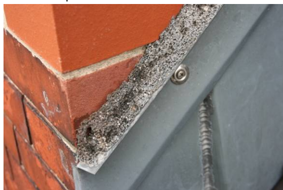
Abb. 63 Pfeiler 4, ganz oben, h=20 m, (12:30), Dachanschluss mit Flexim-Masse
