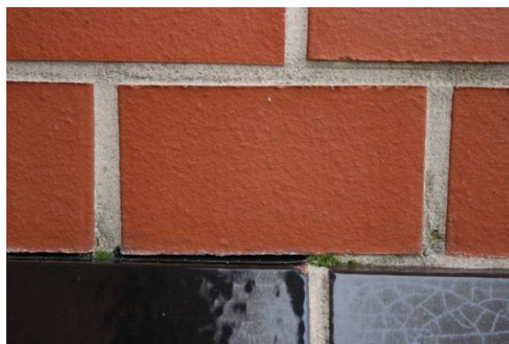
Abb. 17 Offene Fuge im Anschluss
