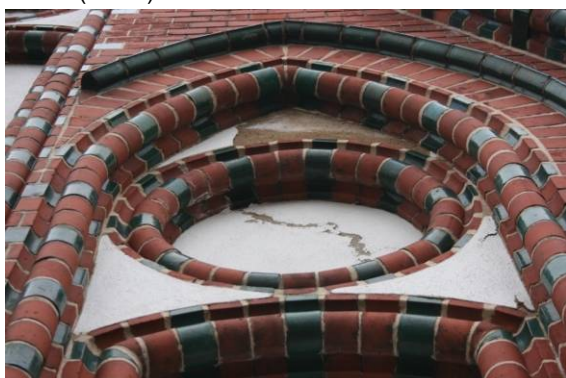
Abb. 30 (10:17) Schäden an Farbfassung und Putz
