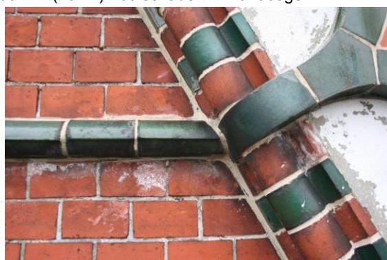
Abb. 29 (10:17), Ausblühungen und Farbschäden
