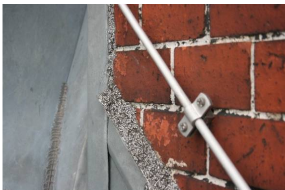
Abb. 56 Pfeiler 3, h=18 m (11:33), Dachanschluss mit Flexim-Masse
