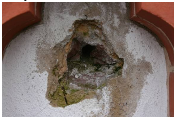
Abb. 45 Schaden durch frühere Probenahme, Ergebnisse liegen vor: hoher Feuchtegehalt 2007
