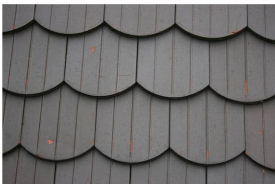
Abb. 58 h=18 m (12:30), Dachziegel. leichte Abplatzungen der Engobe
