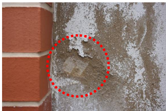
Abb. 47 Putzschäden (11:25), Probe: Gö-Jbk_P3
