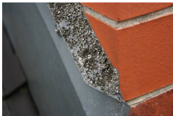
Abb. 57 Pfeiler 3, h=18 m (11:33), Dachanschluss mit Flexim-Masse
