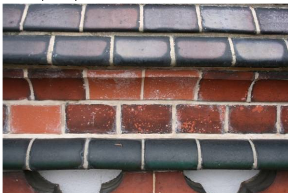
Abb. 38 (10:27) Ausblühungen auf Alt- und Neuziegeln
