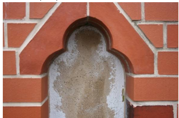
Abb. 7 Pfeilervorlage 4, oben, Farbe blättert ab (9:56)
