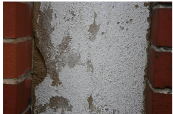
Abb. 5 Pfeilervorlage 4, oben, (9:56), Farbe blättert ab und Putzschäden, schaliges Ablösen, etwa 4 mm (9:56)
