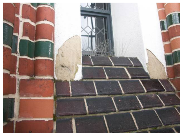
Abb. 5 Farbe blättert ab, Fugenmörtel sind abgängig, Bewuchs durch Moose, Feuchte, Probenahmepunkt Gö_Jkb_F1
