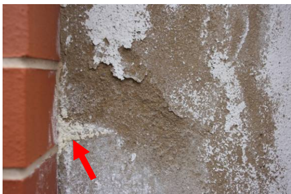
Abb. 46 Putzschäden, knollige Ausblühungen (11:25), Probe: Gö-Jbk_ES2
