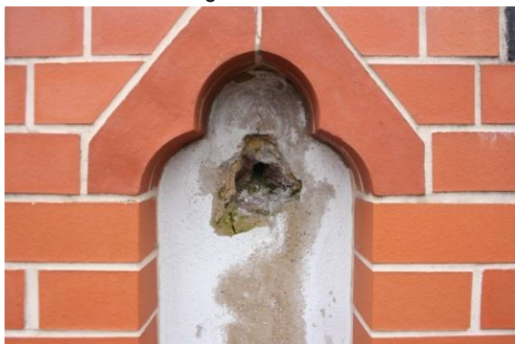
Abb. 44 geputzte Rücklage, h = 17 m (11:15), zurückgesetztes Putzfeld, Schaden durch frühere Probenahme
