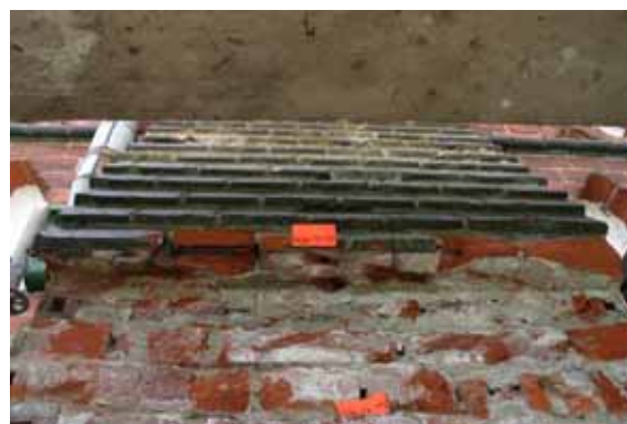
Abb. 3 Pfeiler 18, TP1 und TP2
