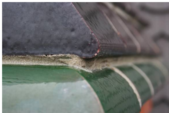
Abb. 61 Pfeiler 4, ganz oben, h=20 m (12:30), Anschluss der glasierten Ziegel an das Ziegelmauerwerk mit Epoximörtel
