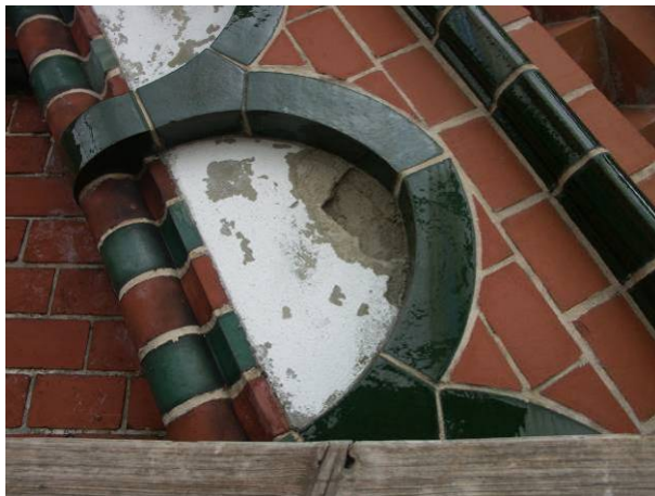
Abb. 2 Rundbögen, Farbe blättert ab und Putzschäden, schaliges Ablösen, Probenahmepunkt Gö_Jkb_P1
