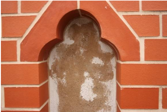
Abb. 2 Pfeilervorlage 4, unten, (9:50), zurückgesetztes Putzfeld, Putz gut, Farbe blättert ab
