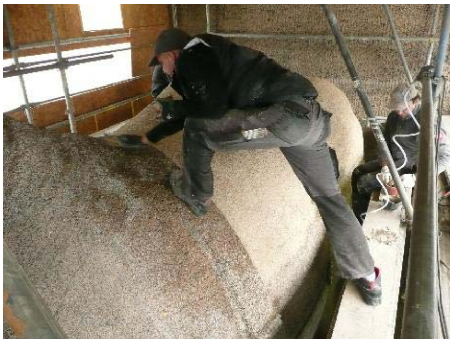
Abb. 134: Aufbringen des Mörtels 101 mit der Wurzelbürste
