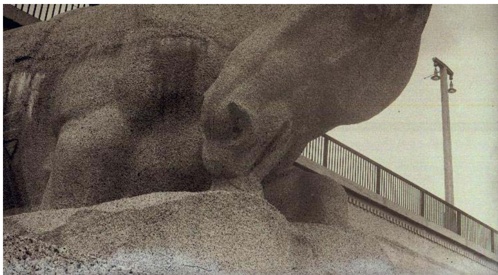
Abb. 12: Es ist ebenfalls eine deutliche Stampffuge zu sehen, aus der Material austritt. Hier gab es vermutlich eine größere Pause im Stampfen, eventuell, weil nun der Kopf gestampft wurde, der keine waagerechten Fugen aufweist, sondern seiner Form entsprechend gesondert verdichtet wurde. Der Kopf der Kuh entstand wohl ebenso; die Qualität beider Köpfe ist ungleich besser als die der Körper, es gibt interessanterweise keine Fehlstellen (Giegold-Schilling, Stadtarchiv)
