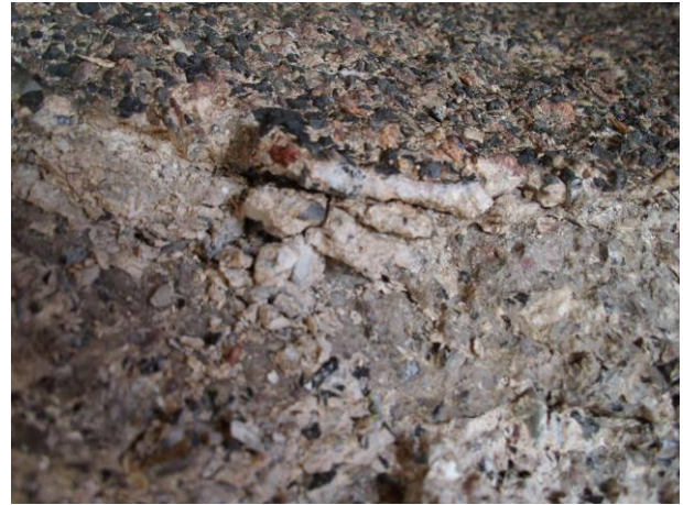
Abb. 69: Halle, Giebichensteinbrücke, Kuh, Rücken, starke Schäden durch Abschalungen
