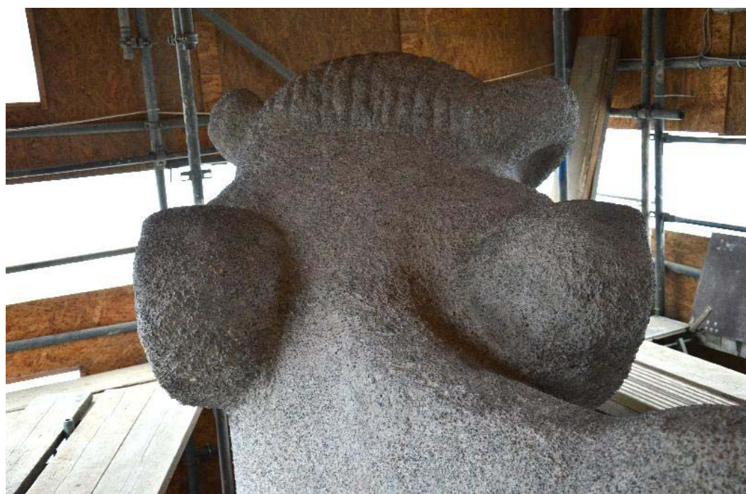
Abb. 146: Ein weiteres Detail der fertig gestellten Skulptur der Kuh mit gefüllten Rissen, mit dem Fehlstellen ausfüllenden und die gesamte Oberfläche überdeckenden Mörtel sowie der abschließenden Schlämmasur
