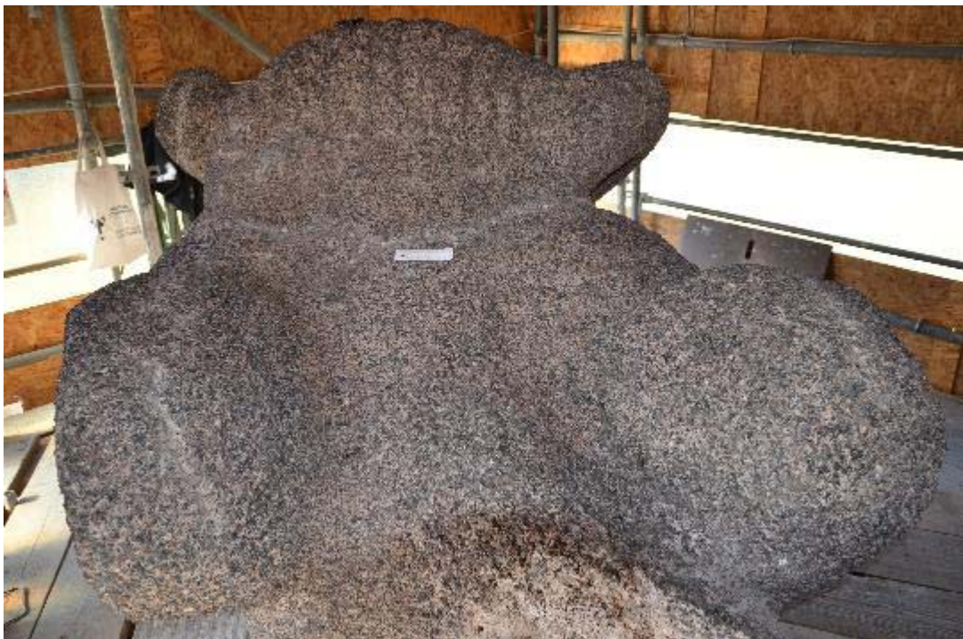
Abb. 128: Entsprechende Stelle - verdämmt und verfüllt; die Bohrlöcher sind inzwischen auch gefüllt
