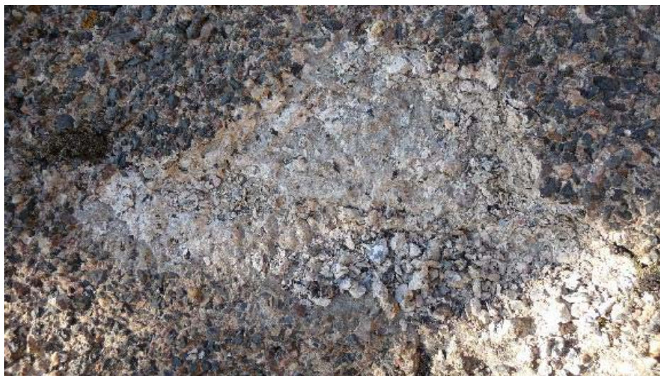
Abb. 130 Entsprechende Stelle wie Abb. 129, ohne die Ergänzung; sehr entfestigt mit Hohlräumen
