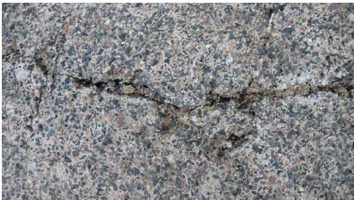
Abb. 116: Auch originales Material ist aus den Rissflanken heraus gebrochen, die Flanken selbst sind porös
