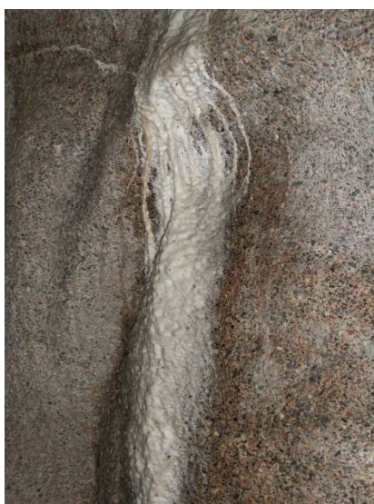
Abb. 82: 1Kuh, Straßenseite, Austritt von Feuchte, ausgewaschenes Bindemittel, nach RFA-Analysen Calcit \text{CaCO}_3 (CaO: 56,03 Ma.-%, \text{CO}_2 : 43,97 Ma.-%)
