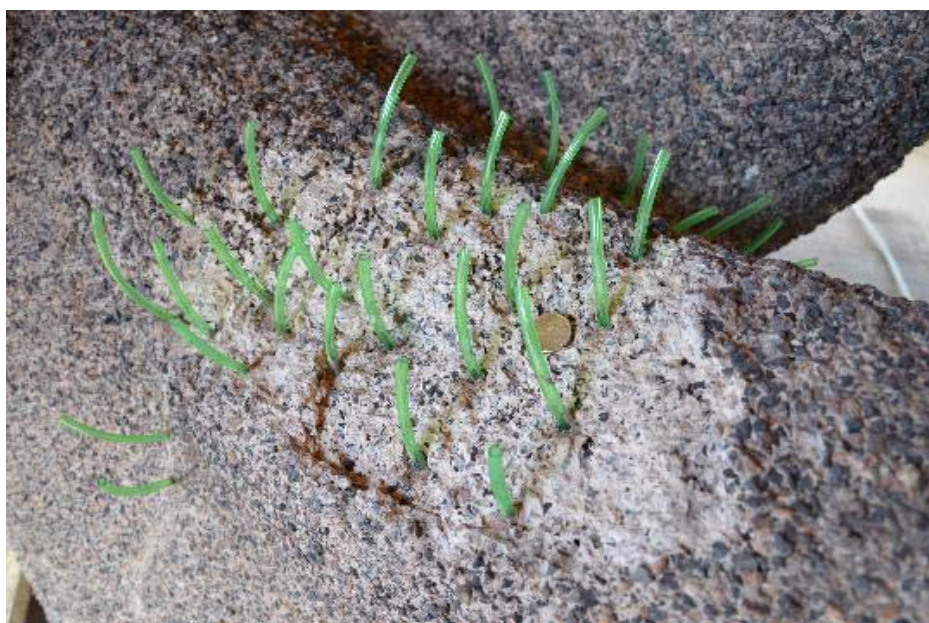
Abb. 131: Entsprechende Stelle wie Abb. 130, nach der Festigung und Vorbereitung zum Verfüllen der Hohlräume
