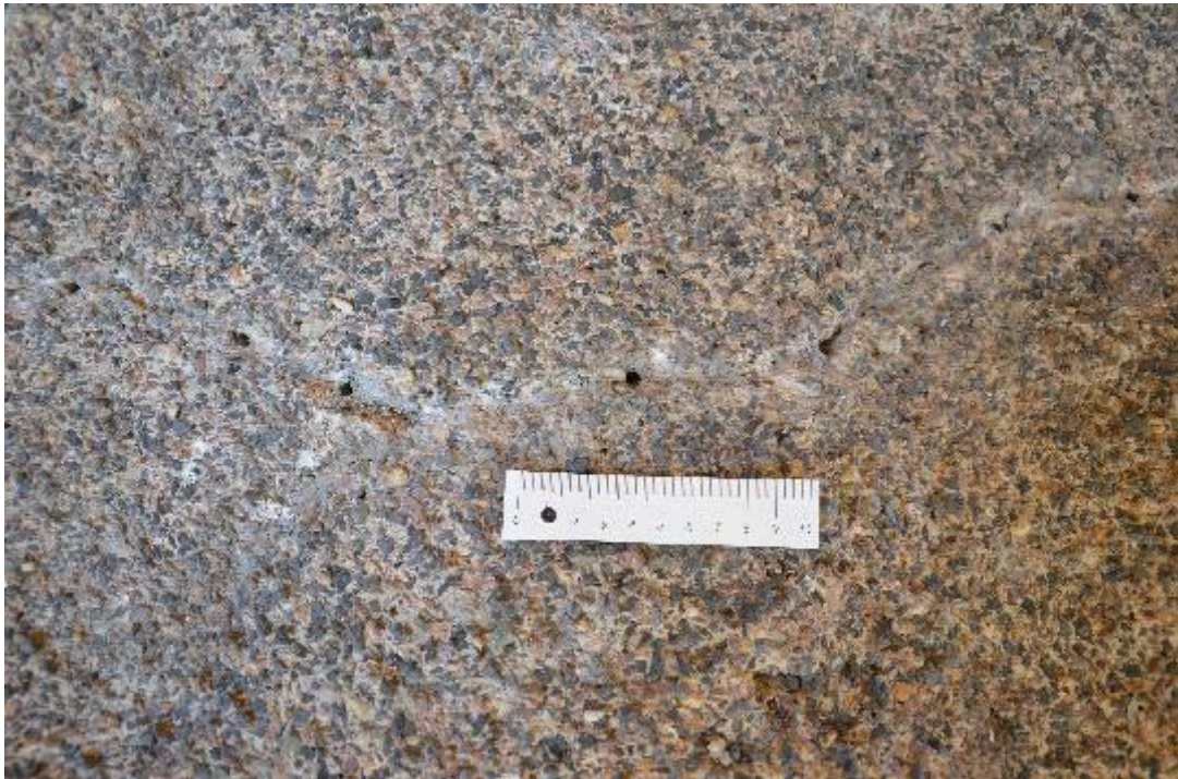
Abb. 127: Entsprechende Stelle - ein verdämmter und verfüllter Riss
