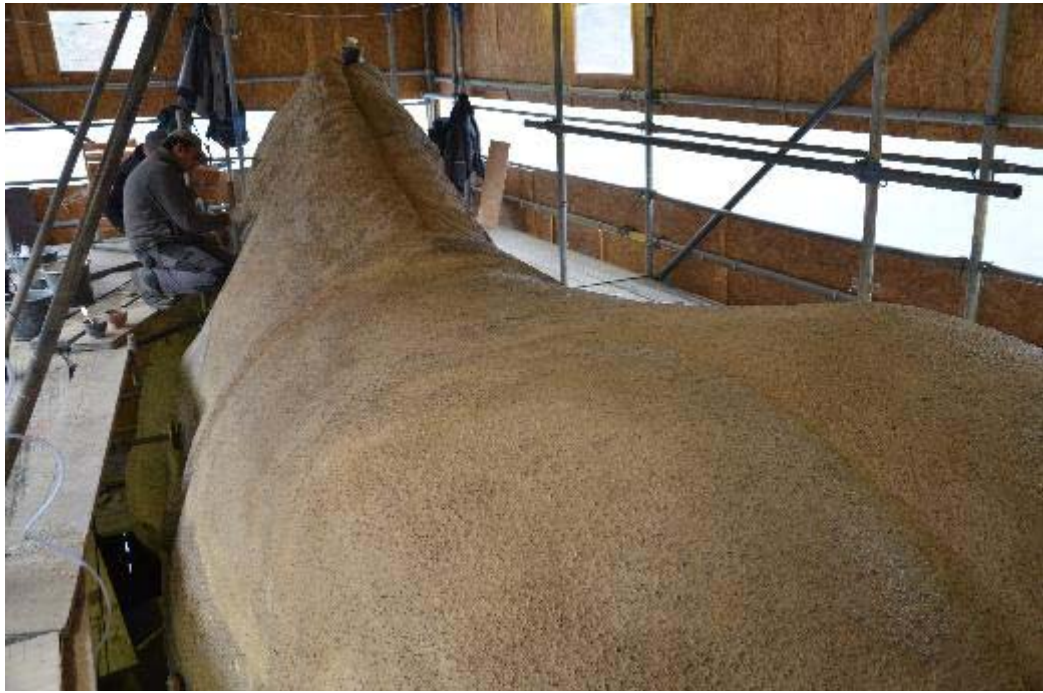
Abb. 135: Aufbringen des Mörtels 101 mit der Wurzelbürste
