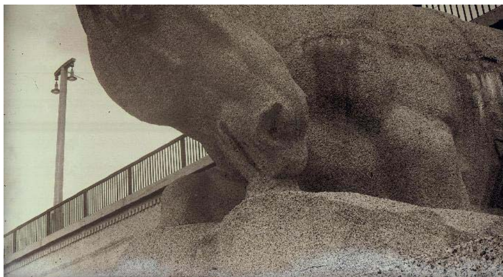
Abb. 11: Austritt einer weißen Sinterfahne und zusätzlich einer braunen Substanz (Stadtarchiv, Annemarie Giegold-Schilling, vermutlich zwischen 1930 und 1932, als sie bei Finsler studierte)
