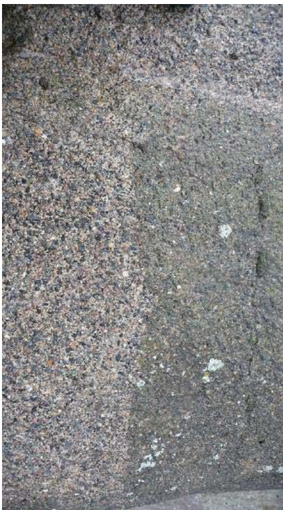
Abb. 114: Reinigung mit Sandstrahl, die linke Hälfte ist gereinigt
