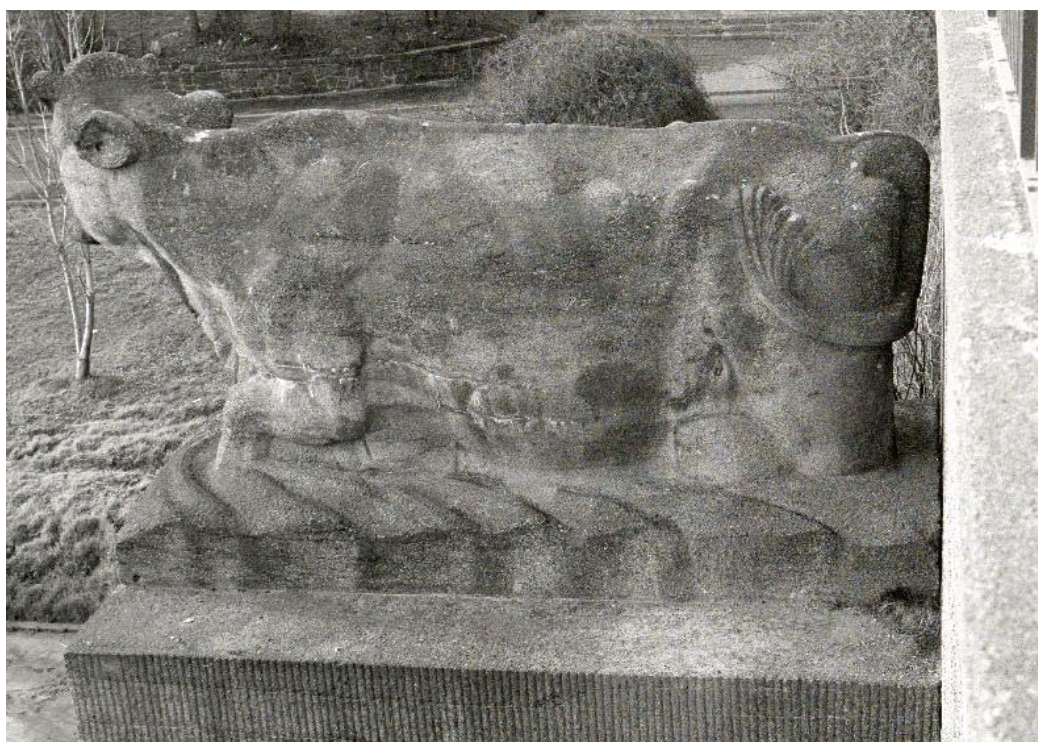
Abb. 27: 1993; Die großflächige Verwitterung der Oberfläche ist hier deutlich zu sehen. Die Kuh ist, das kann man nun deutlich sehen, viel schlechter gestampft als das Pferd; der Rohblock für die Kuh ist wohl vor dem des Pferdes gestampft worden, wie auch die steinmetzmäßige Überarbeitung zuerst geschah. Leider gibt es keine Aufnahmen der Betonskulpturen nach der Sanierungsmaßnahme 1995 (Reichenbach)
