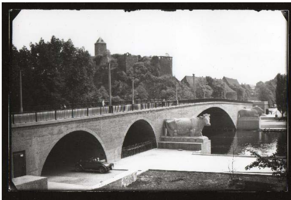
Abb. 10: Die erste Aufnahme der komplett fertig gestellten Brücke mit den beiden Tieren in der Zeit zwischen 1929 und 1932 entstanden; die weißen Sinterfahnen sind an der Kuh bereits zu sehen (Finsler, Stiftung Moritzburg)
