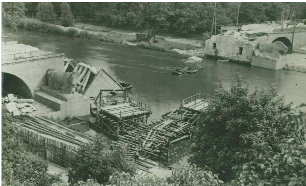
Abb. 18: Brücke nach der Sprengung des Hauptbogens im April 1945 durch deutsche Truppen; auf eine Beschädigung, bzw. eine notwendige Restaurierung der Skulpturen gibt es keinen Hinweis (Stadtarchiv)
