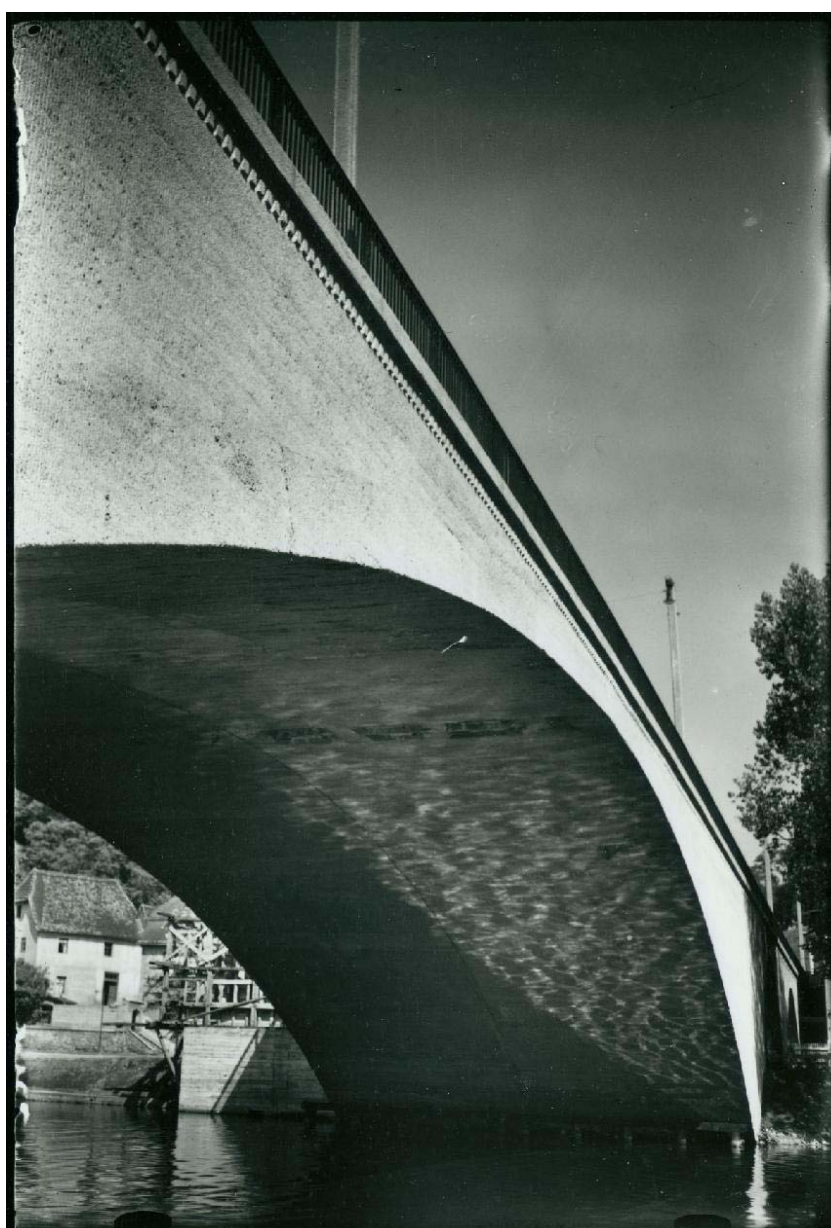
Abb. 2: Blick durch die neue Brücke auf die Kröllwitzer Seite mit dem Gerüst, bzw. der Schalung für die Kuh (Finsler, Stiftung Moritzburg)
