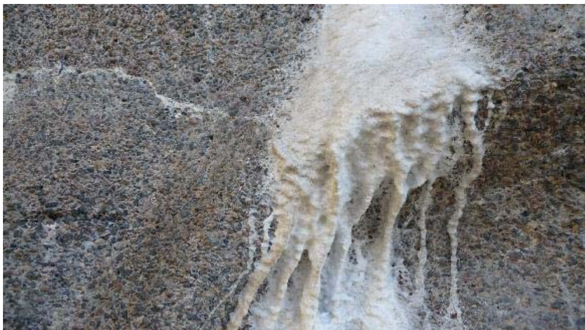
Abb. 113: Massive Sinterschicht
