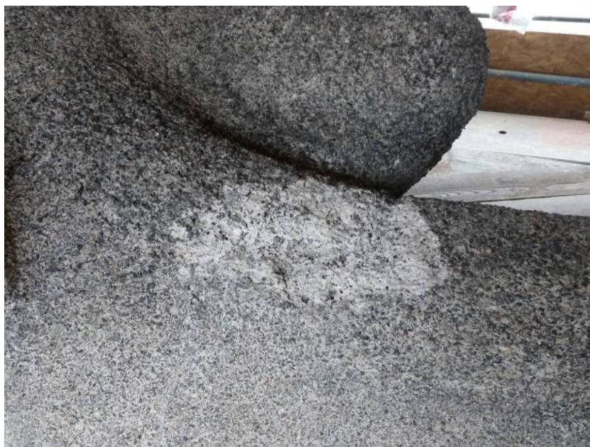
Abb. 48: Schalenbildung und körniger Substanzverlust
