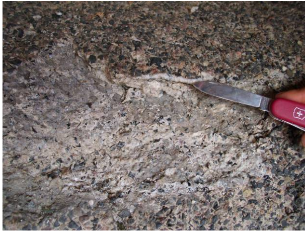
Abb. 68: Halle, Giebichensteinbrücke, Kuh, Rücken, starke Schäden durch Abschalungen
