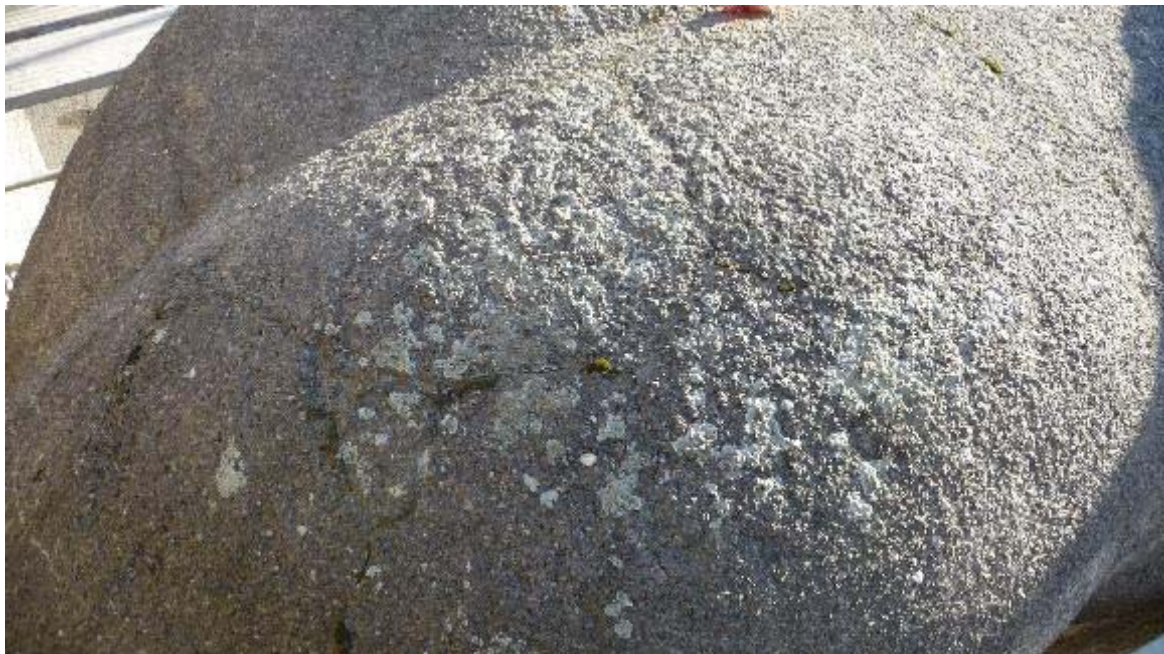
Abb. 112: Pferderücken mit Moos und Flechten, d. h. Betonoberfläche, die schon so weit entfestigt war, dass sich Kleinorganismen darauf entwickeln konnten
