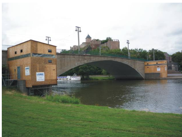
Abb. 42: Einhausung für die Trocknung der geschädigten Skulpturen
