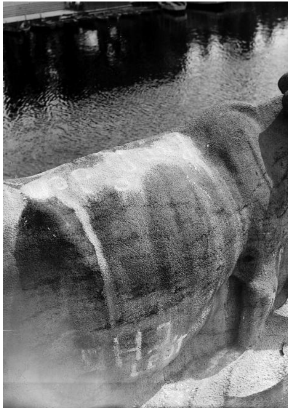
Abb. 14: Hier sind neben den Schmierereien die sehr ungleichmäßig gestampften Schichten sehr genau zu sehen (Strauch, Stadtarchiv)
