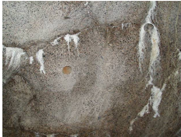
Abb. 83: 2Pferd, Nordseite, Bauchbereich, Bohrkernentnahme
