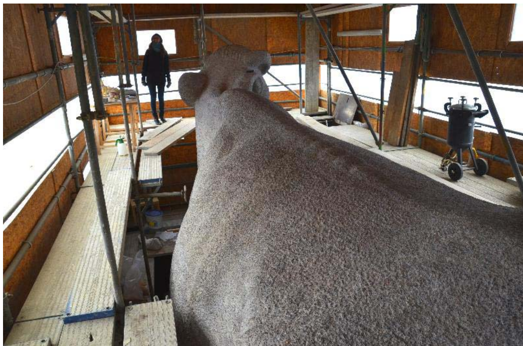
Abb. 147: Südliche Seite der Kuh mit gefüllten Rissen, mit dem Fehlstellen ausfüllenden und die gesamte Oberfläche überdeckenden Mörtel sowie der abschließenden Schlämmlasur
