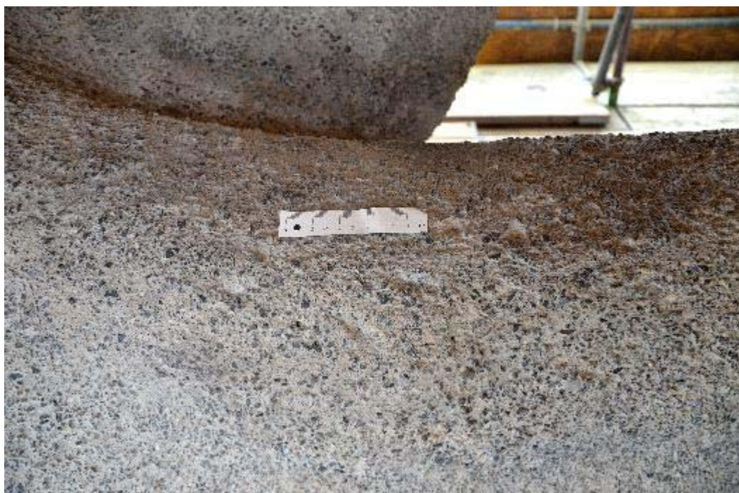
Abb. 140: Die fertig abgestrahlte Ergänzung am Hals der Kuh, siehe Abb. 132
