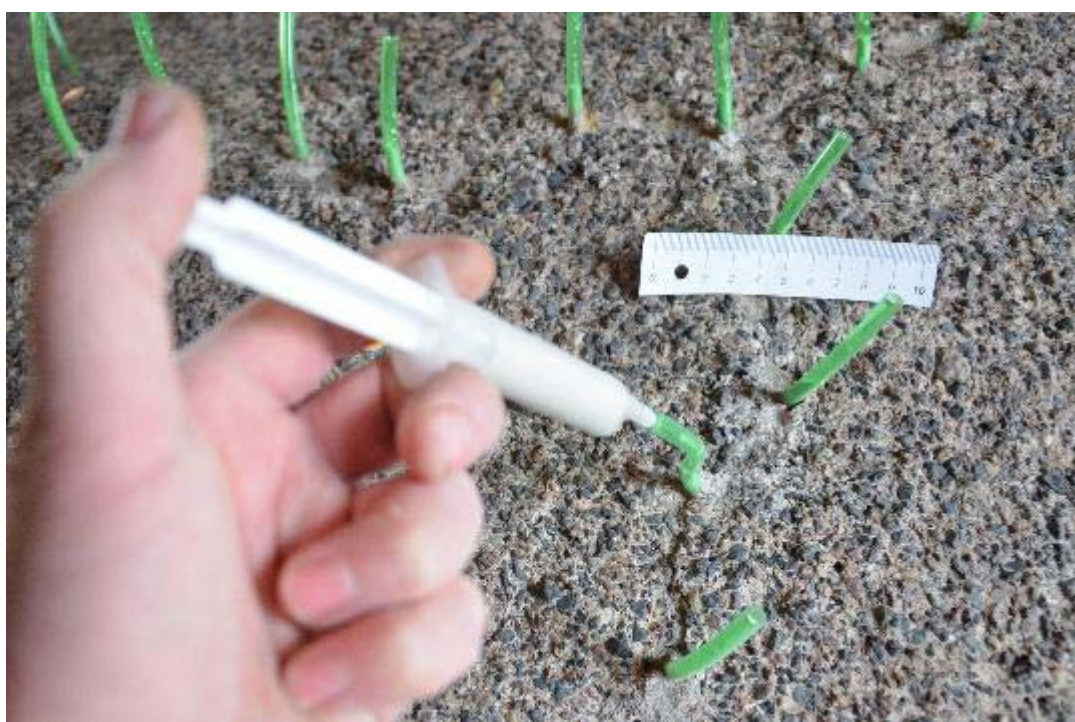
Abb. 122: Entsprechende Stelle beim Einfüllen des Verpressmörtels; Der Riss wurde inzwischen mit Zentrifix verdämmt.
