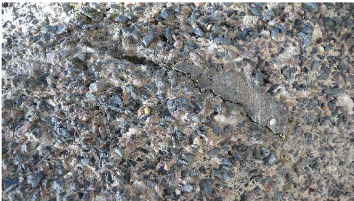
Abb. 115: Reste einer Antragung im Zusammenhang mit der Rissverpressung von 1995, links davon ist sie schon ausgebrochen; der Riss ist eigentlich nur geringfügig wieder aufgegangen
