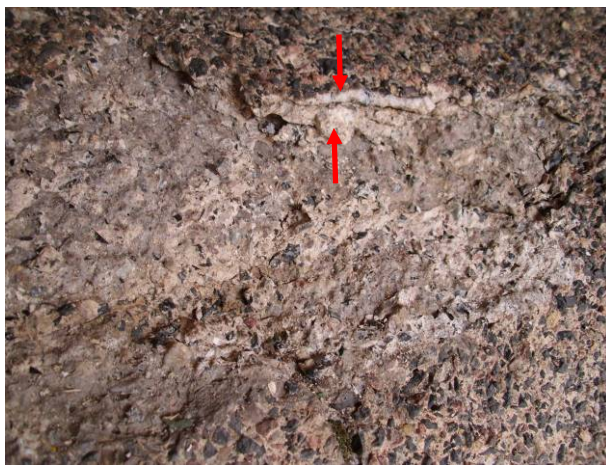
Abb. 70: Halle, Giebichensteinbrücke, Kuh, Rücken, Abschalungen, Markierung des beprobten Bereichs
