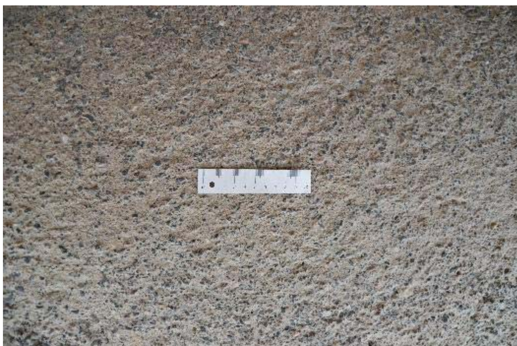
Abb. 138: Oberfläche nach dem Sandstrahlen
