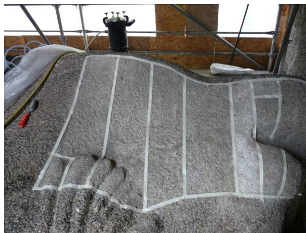
Abb. 98: Anlage von Musterflächen mit unterschiedlich pigmentierten Silikonharzschlämmen
