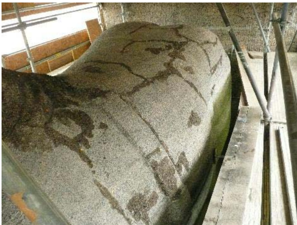
Abb. 117: Auf die gereinigte Oberfläche wurde der Festiger mehrmals aufgetragen
