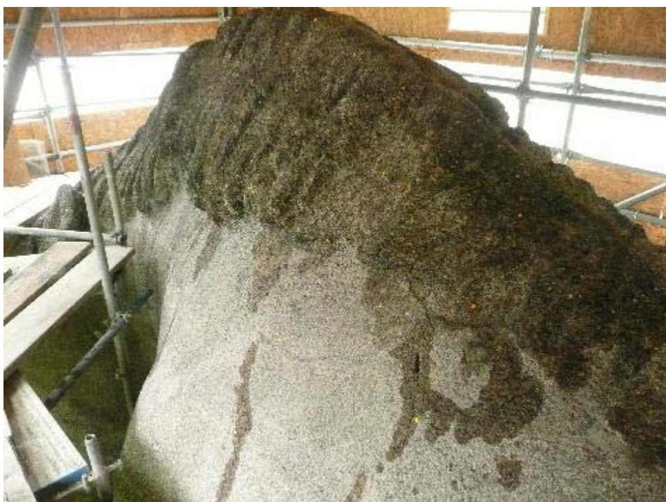
Abb. 118: Auf die gereinigte Oberfläche wurde der Festiger mehrmals aufgetragen, hier auf der Mähne des Pferdes
