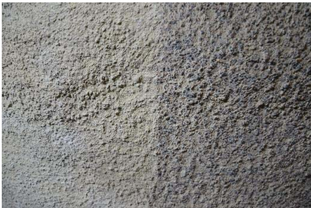
Abb. 137: Die linke Hälfte des Bildes zeigt den aufgetragenen Mörtel 101, die rechte Hälfte den Zustand nach dem Sandstrahlen
