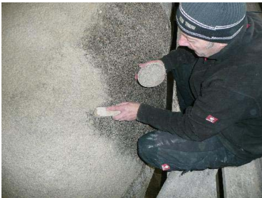
Abb. 133: Aufbringen des Mörtels 101 mit der Wurzelbürste (Detail)
