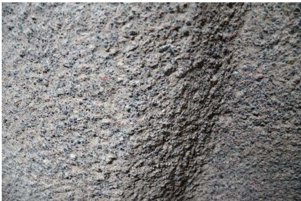
Abb. 139: Oberfläche nach dem Sandstrahlen (Detail)
