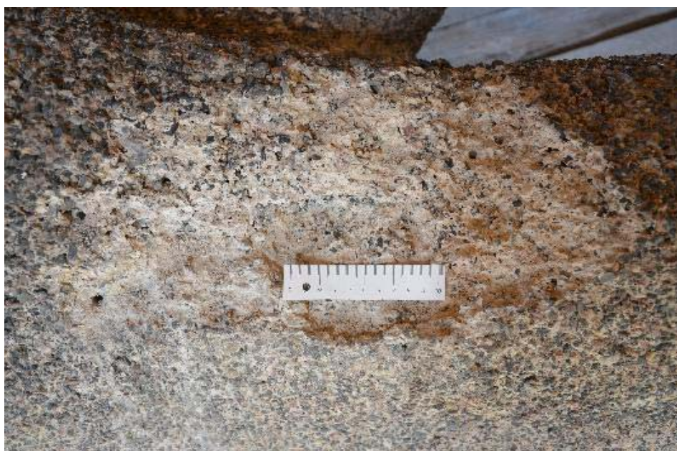
Abb. 132: Entsprechende Stelle wie Abb. 131, nach dem Verfüllen; Endergebnis Abb. 140
