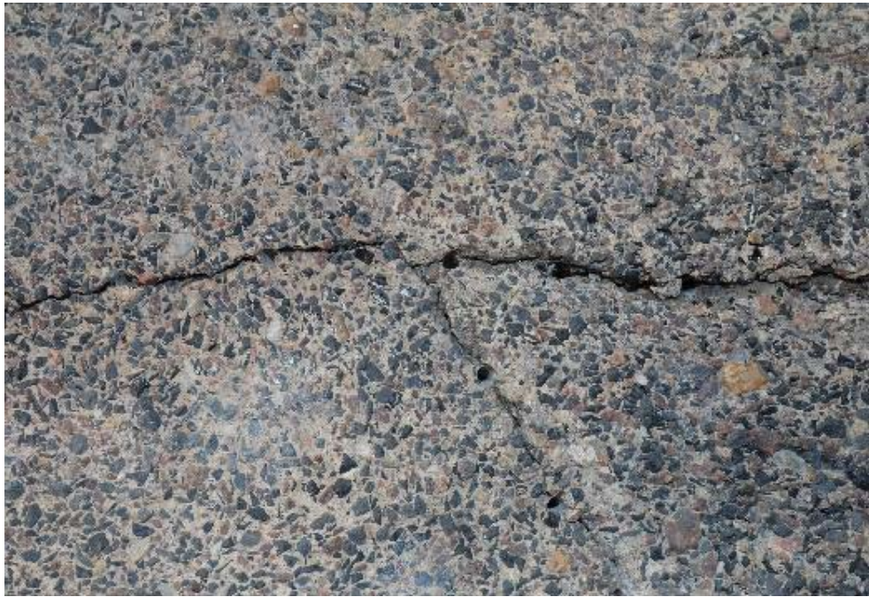
Abb. 119: Risse mit 6 mm großen Bohrlöchern für die Einfüllschläuche
