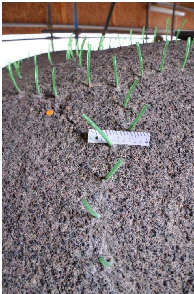
Abb. 123: Entsprechende Stelle mit verdämmten und gefüllten Rissen
