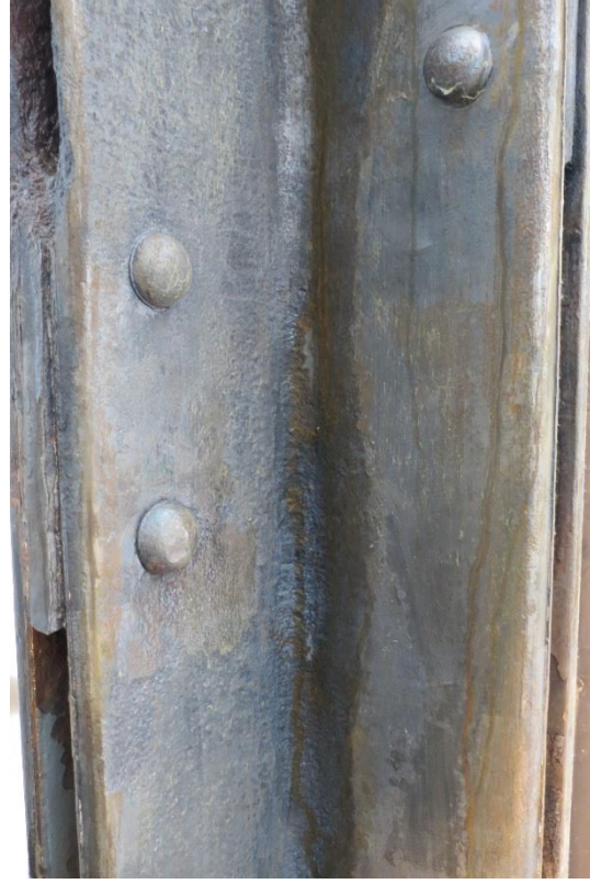
Oberfläche nach zweimaligem Lasern Foto: HIG – Hempel Ingenieure GmbH
