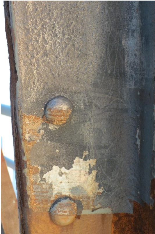
Oberfläche nach einmaligem Lasern Foto: HIG – Hempel Ingenieure GmbH
