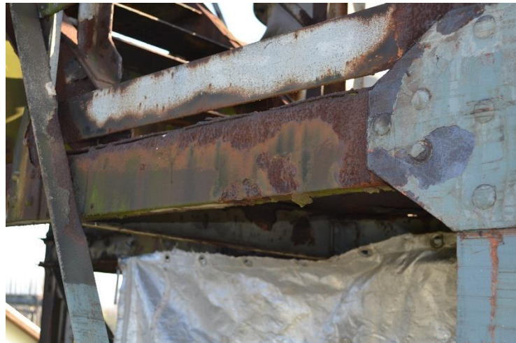
Oberfläche nach der mechanischen Vorreinigung Foto: HIG – Hempel Ingenieure GmbH
