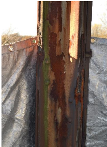
Unbehandelte Oberfläche Foto: HIG – Hempel Ingenieure GmbH
