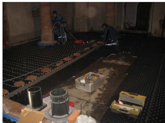
Zur Verminderung der Energiezufuhr, Absenkung der Wärmeleistung und Erhöhung der Behaglichkeit im Altargeschoss wurde eine Fußbodentemperierung eingebaut. Diese musste um eine Gruft herum gebaut werden.
