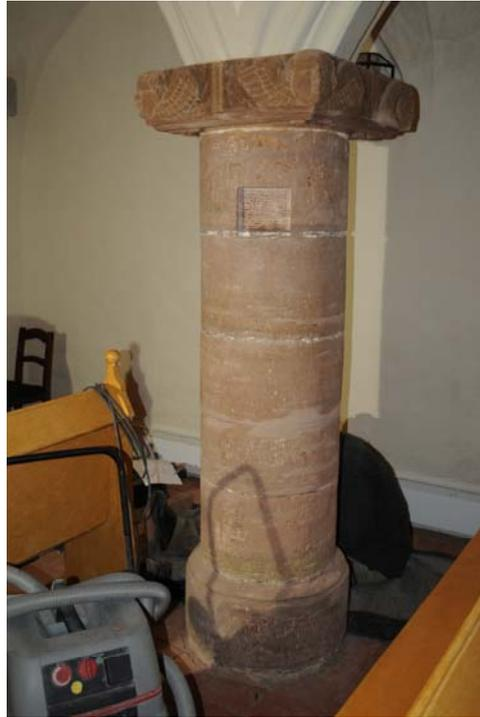
*Abbildung 7: Mustersäule mit mineralischen Ergänzungen und Vierungsaussparung an der oberen Säulentrommel*
