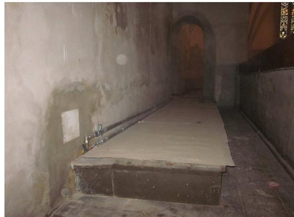
Mittels Rohrheizkörpern werden die Wandbereiche der Emporen temperiert. Außerdem wird auch hier dem Kaltluftabfall an Wänden und Fenstern entgegen gewirkt.
