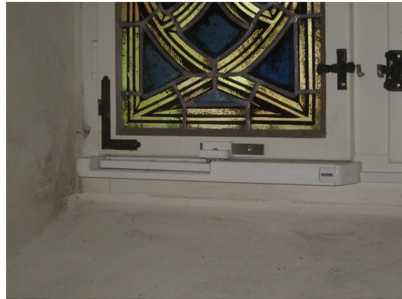
Zur Ansteuerung der Fensterlüftung werden zwei Fensterflügel sowie ein Abluftventilator genutzt. Beides ist parallel geschaltet. Es gibt drei verschiedene Zustände:
