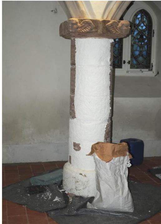
*Abbildung 4: Entsalzungsmaßnahmen, Abnahme einer Zellulosekompressse*
