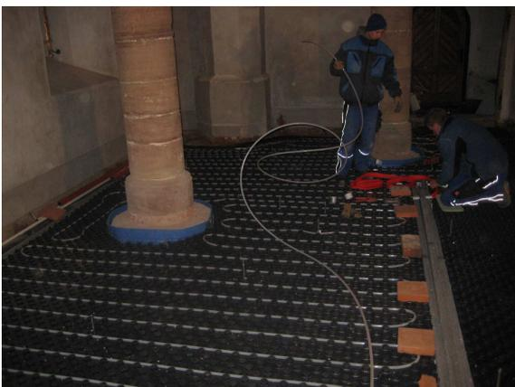
Bild 8: Aussparung der Fußbodentemperierung bei der Gruft
