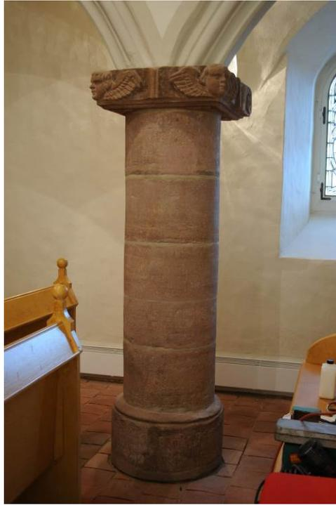
*Abbildung 8: Endzustand der Mustersäule nach ausgeführter Retusche*
