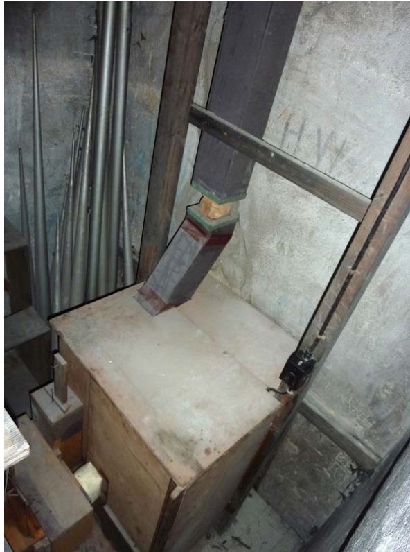
Abb. 39 Vorgefundener Gebläsemotor Schutzkasten am ursprünglichen Standort des dritten Kastenbalges
