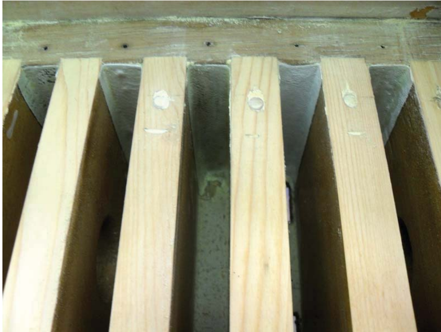
Abb. 17 Fixierung lockerer Schied- Schenkelverbindungen durch eingebohrte Dübel sowie Ausliederung der Kanzellenfugen
