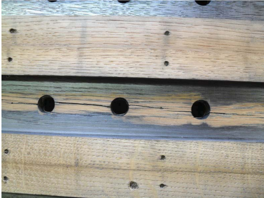
Abb. 15 Vorgefundene Rissbildung im Schleifenbereich
