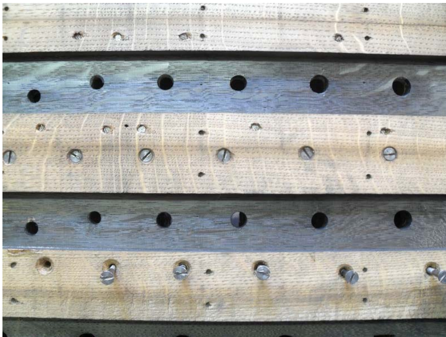
Abb. 16 Notreparatur durch Aufschrauben des Fundamentbodens, vermutl. 1955 erfolgt
