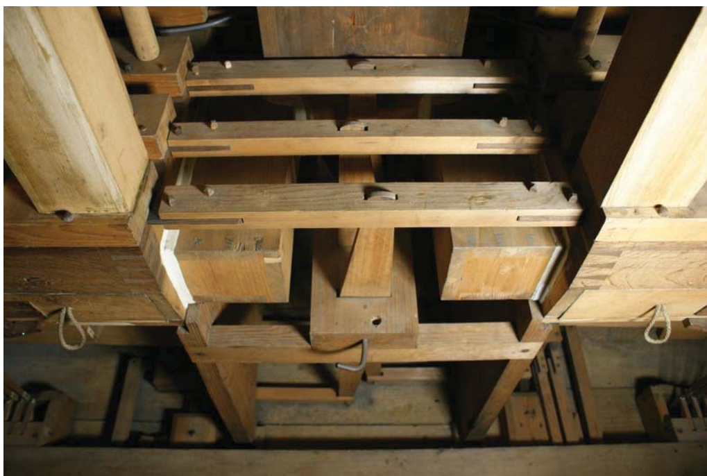
Abb. 38 Registerschwerter mit Schleifenverbindern Pedal nach der Restaurierung
