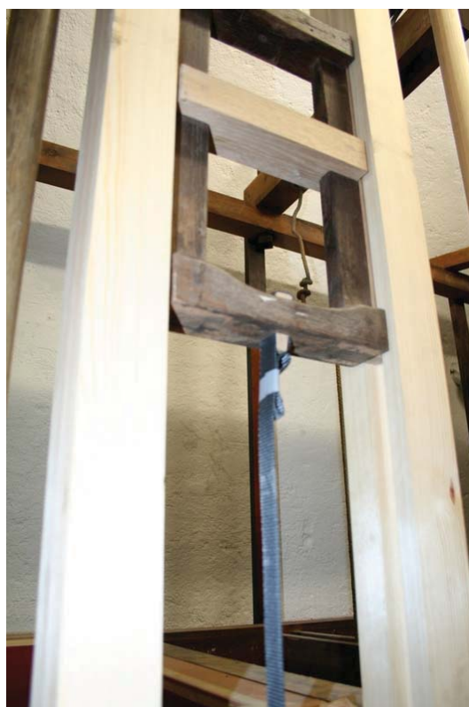
Abb. 47 Steigbügel mit Gurtband der Aufzugsanlage und rekonstruierten seitlichen Führungsleisten
