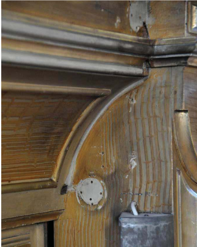
Alte Elektroinstallationen erfolgten vor der Neufassung des Objektes .
