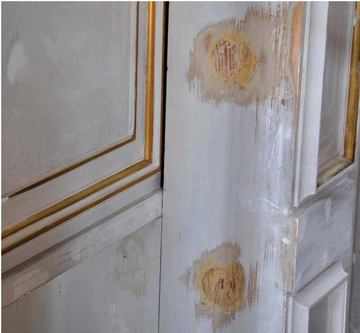
Fehlstellen durch entfernte Elektroinstallation am Orgelprospekt wurden geschlossen
