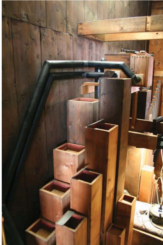
Abb. 26 Einschaltapparate für die pneumatisch angesteuerten Zusatzwindladen sowie rekonstruierte Windzuführungen C-Seite
