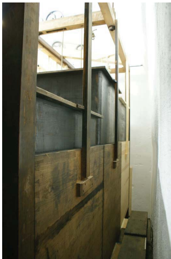
Abb. 42 Balganlage Hinterseite mit rekonstruiertem Kastenbalg
