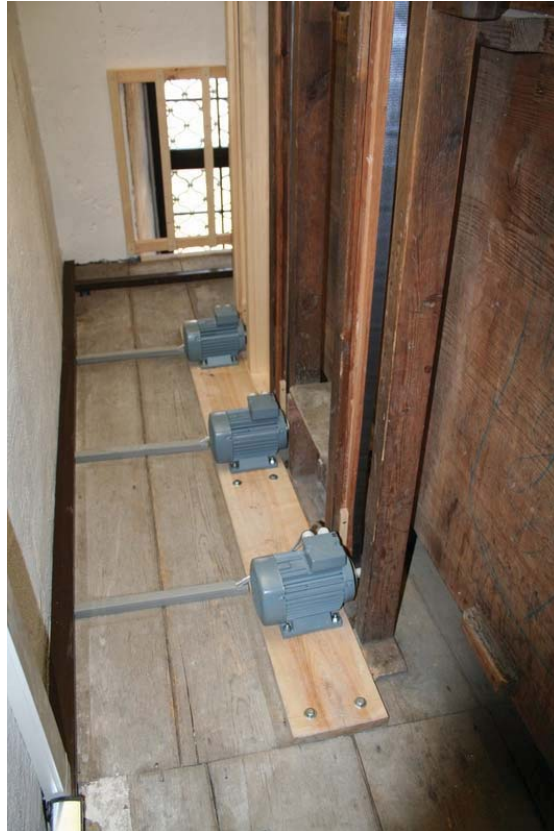
Abb. 48 Getriebeeinheiten der motorischen Aufzugsanlage
