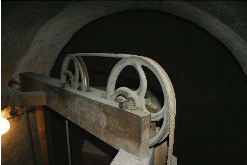
Abb. 43 Seilzugrollen in vorgefundenem Zustand
