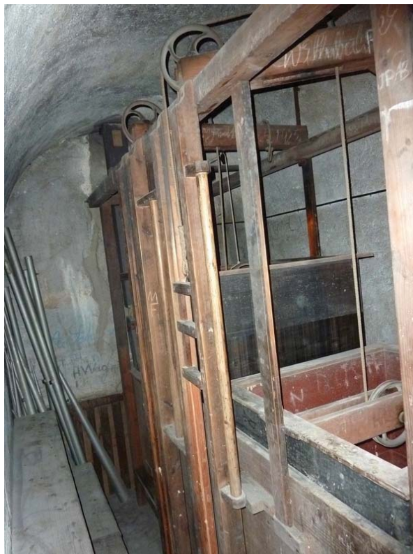
Abb. 40 Balganlage in vorgefundinem Zustand
