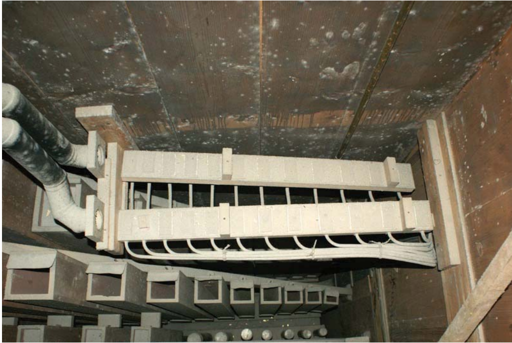
Abb. 24 Vorgefundene Reste (Membranenleisten) der pneumatisch angesteuerten Zusatzlade D- Seite aus dem Jahre 1955 mit Schimmelflecken auf Orgelrückwand
