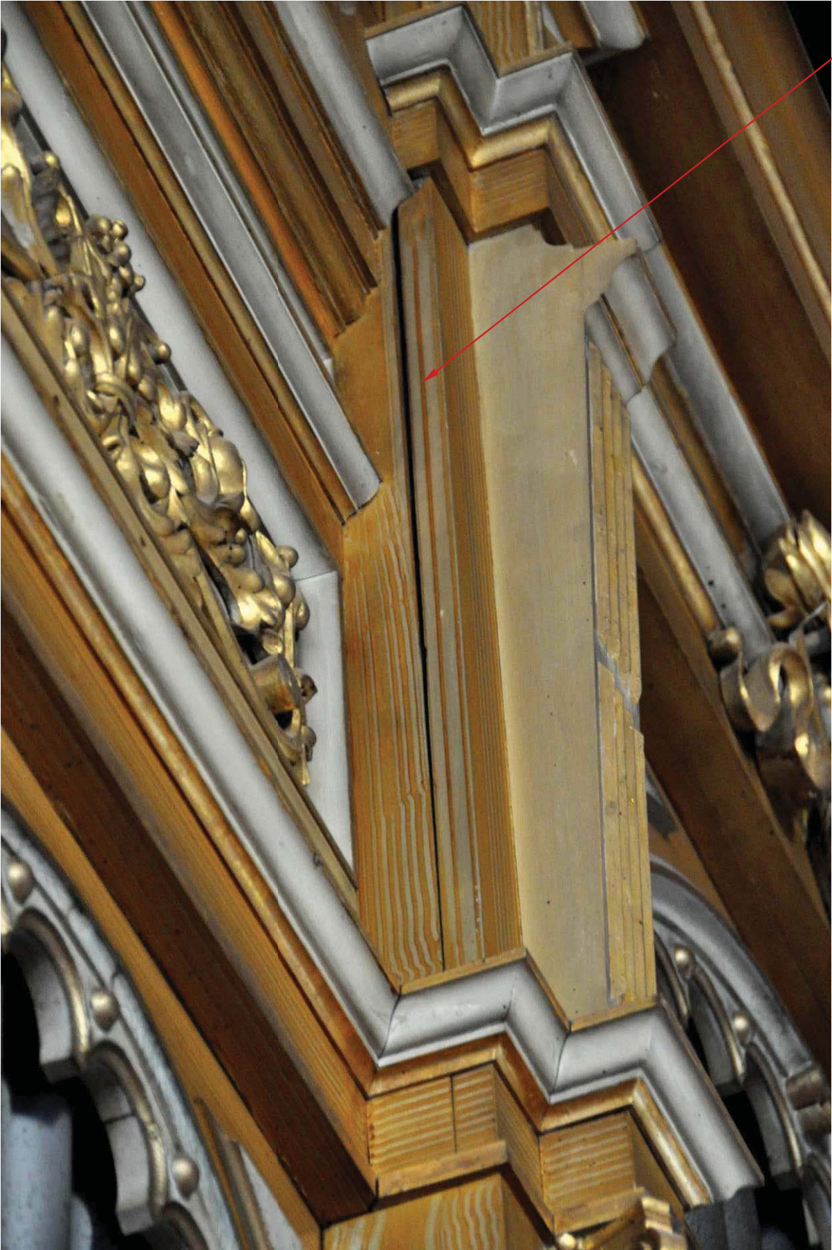
Durch Spannung gelöste Holzverbindung an der Konstruktion des Orgelprospektes
