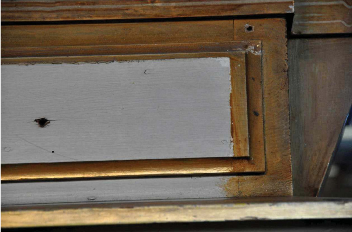
Bei der Neufassung des Orgelprospektes wurden abgedeckte Bereiche belassen.
