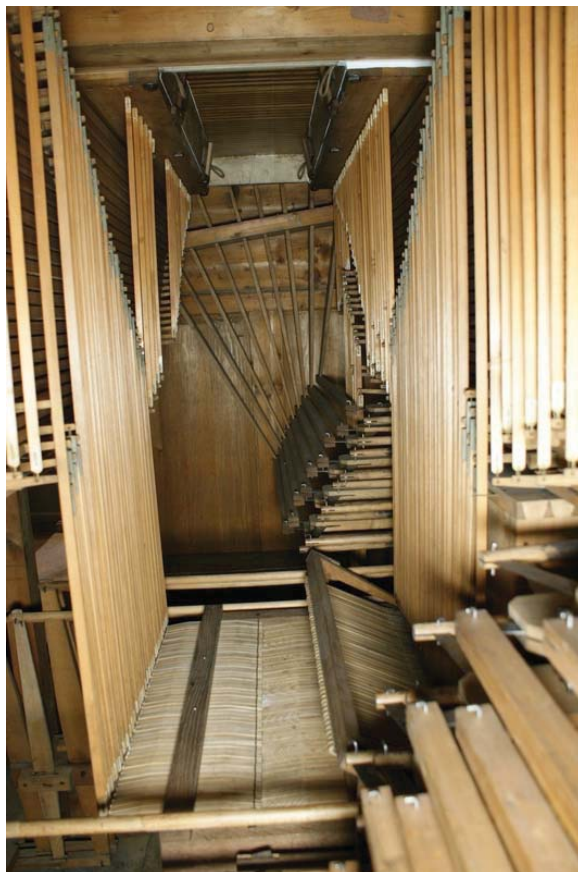
Abb. 29 Blick in die Tontraktur nach der Restaurierung
