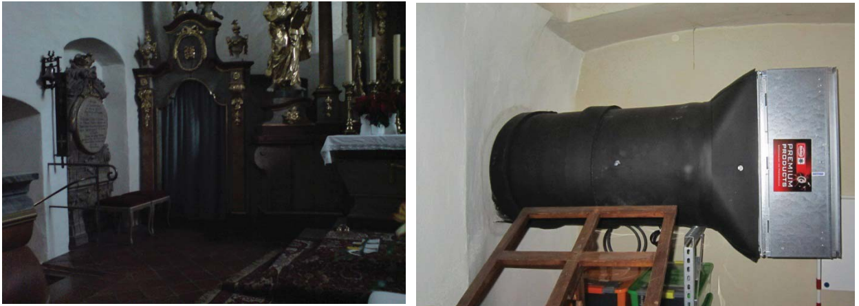
Abbildung 11: Zulufteinrichtung ohne Ventilator hinter dem Altar
