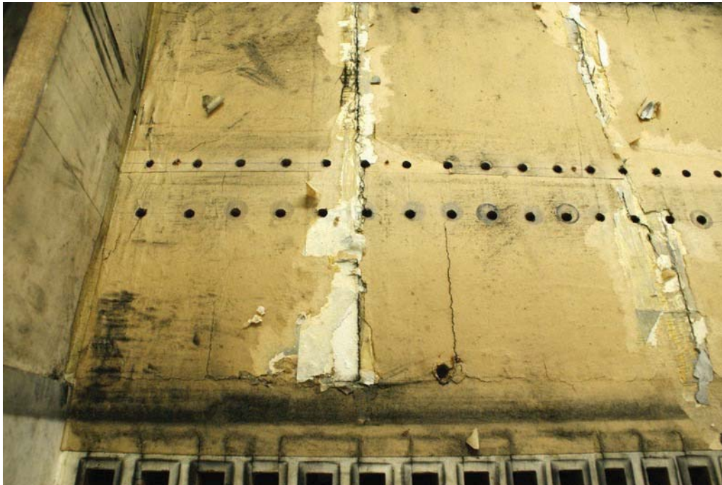
Abb. 12 Risse auf der Unterseite der Windlade
