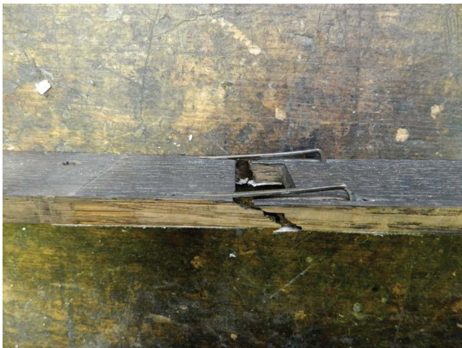
Abb. 18 Gebrochene Schleife notdürftig repariert in vorgefundenem Zustand
