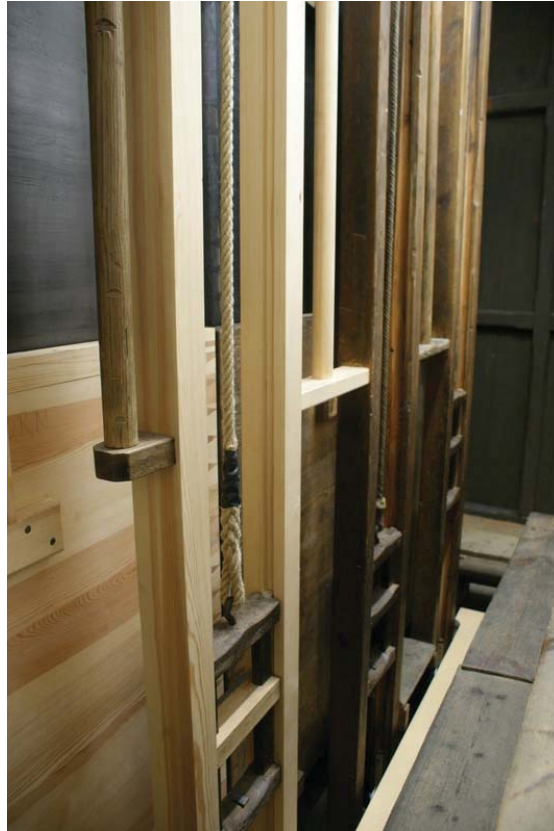
Abb. 50 Steigbügelanlage mit rekonstruierten und originalen Anteilen
