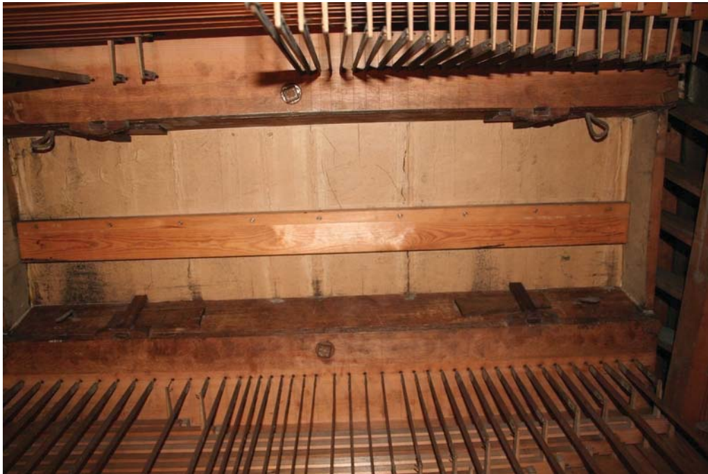
Abb. 10 Untersicht Manualwindlade mit Überpapiertung und Abdeckleiste der Auslässe von 1955
