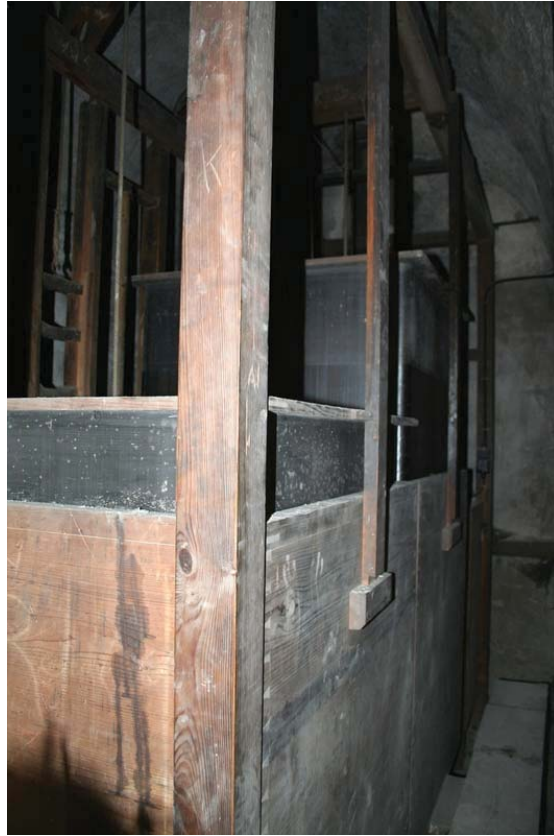
Abb. 41 Balganlage Hinterseite in vorgefundinem Zustand und Schimmelflecken
