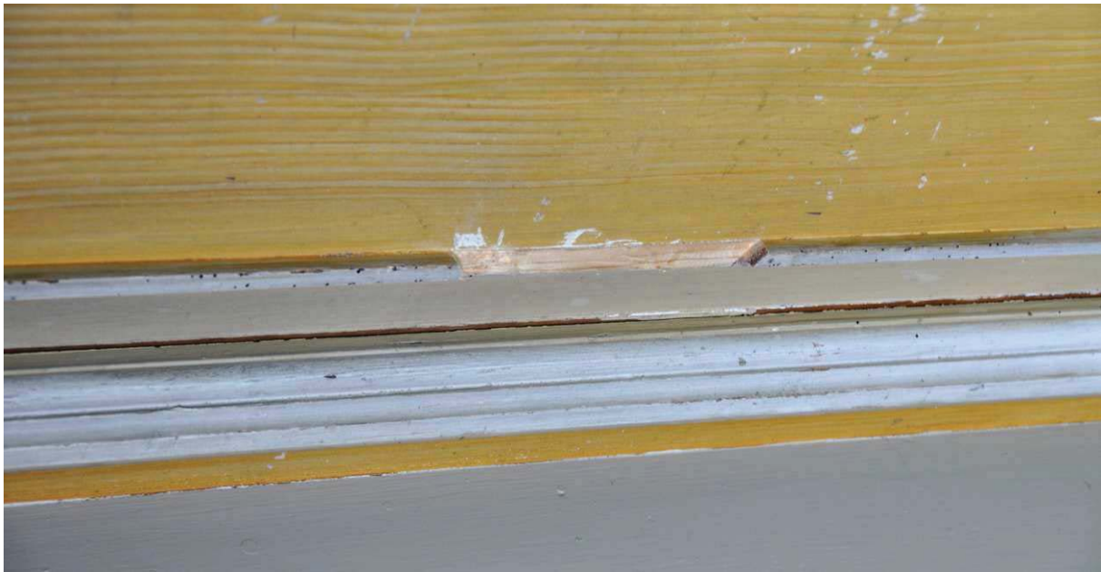
Durch Anobien stark geschädigte Profilleistenbereiche mussten erneuert werden
