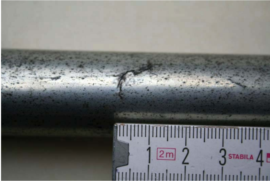
Abb. 67 Gambe 8' cis° mit vorgefundem Riss in Pfeifenwandung
