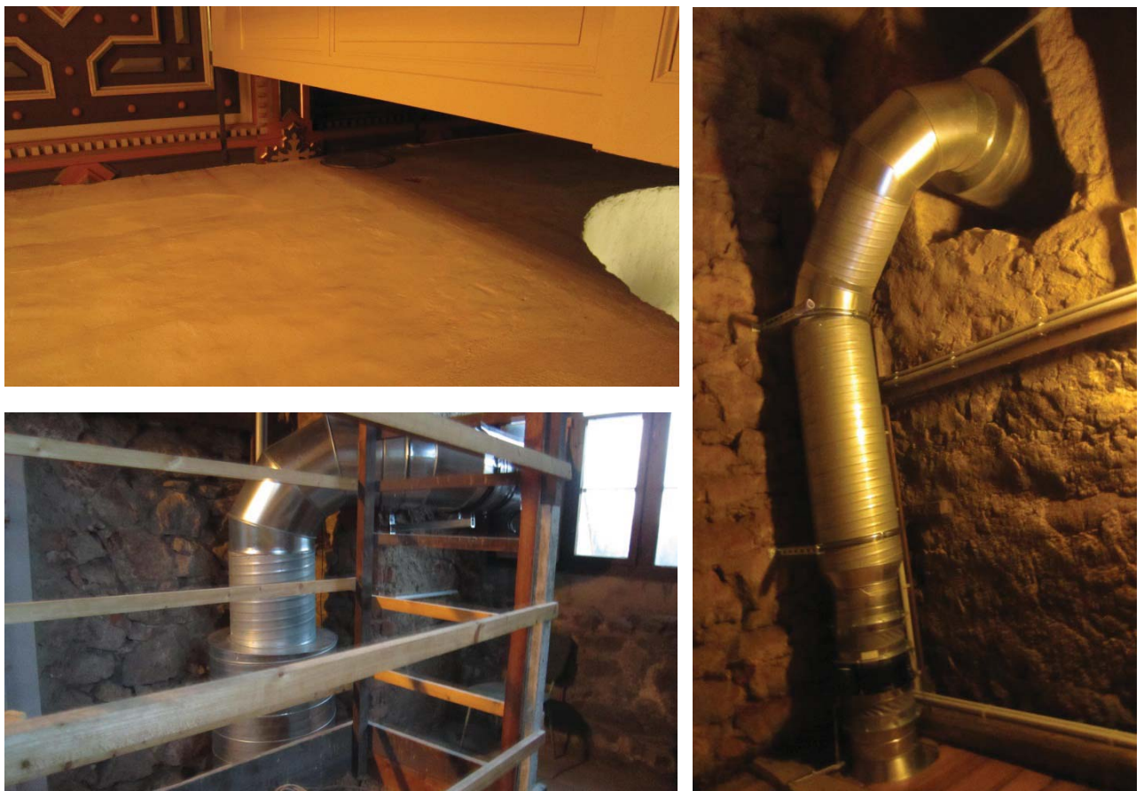
Abbildung 10: Ablufteinrichtung durch die Wand hinter der Orgel nach außen
