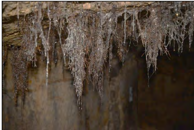
Abbildung 2: Durchwurzelte und durchnässte „Pflanzentone“ führen im Firstbereich zu Gesteinsablösungen
