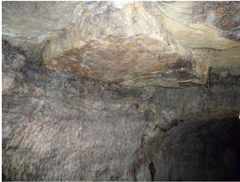
Weiß-Tauben-Keller Südgang. Absturzstelle
