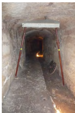
Stützelement im Rappenkeller
