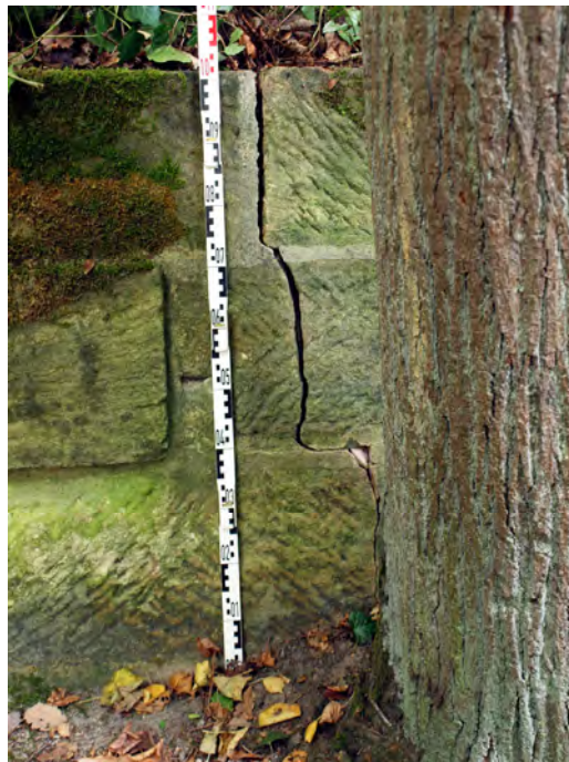
Abbildung 15: Nahaufnahme des Risses im Mauerkronenbereich. Im Riss findet bereits eine initiale Bodenbildung statt, welche das direkte Eindringen benachbarter Baumwurzeln fördern wird
