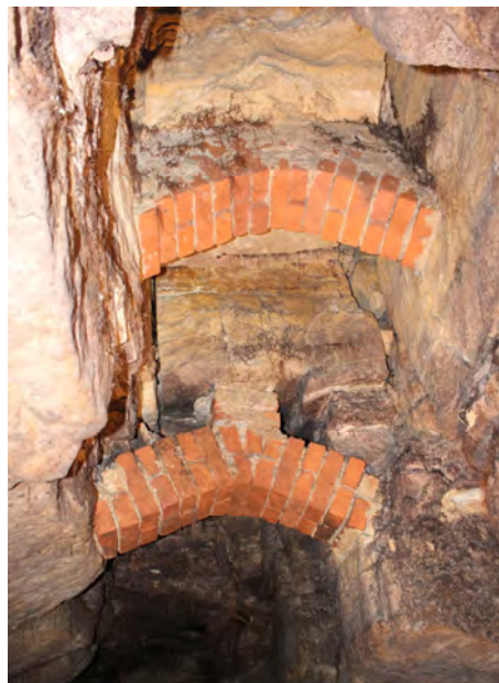
Abbildung 13: Ziegelbogenkonstruktion im Deckenbereich des Nordgangs
