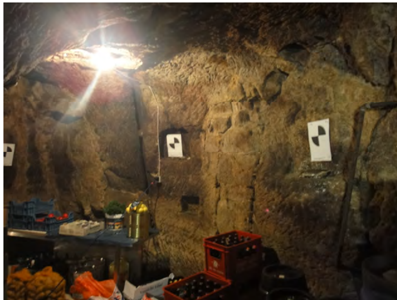
Abbildung 2: Black/White Messmarken im Bereich der S-Kurve des Rappenkellers bevor umgeräumt wurde.
