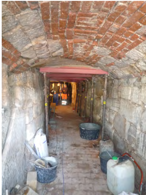
Abbildung 10: 6 Schrägstützenpaare sichern den Eingangsbereich des Bauernkellers.
