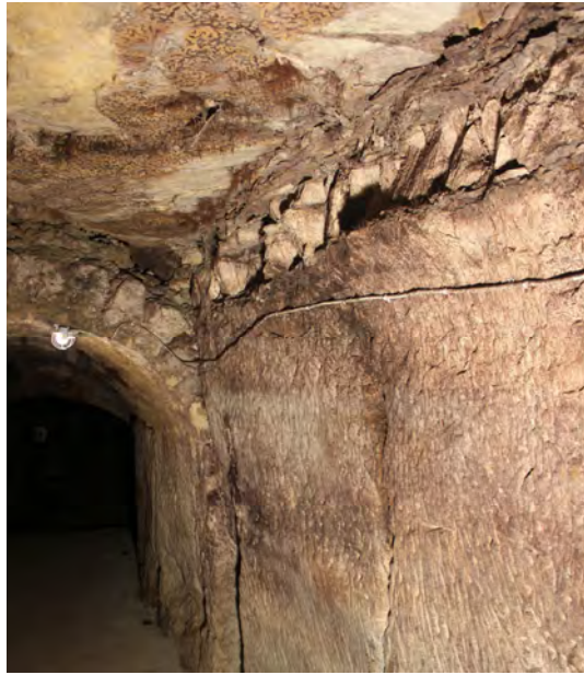
Abbildung 12: Weiß-Tauben-Keller, Deckenausbruch im Südgang
