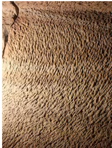
Abbildung 6: Bearbeitungsspuren an der Ostwand von Bauphase 2
