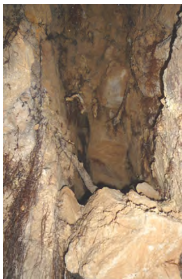
Abbildung 10: Weitständige Kluft mit lockerem Schuttmaterial.
