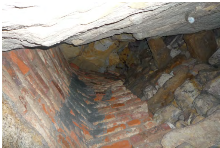
Einsturzstelle im Bauernkeller
