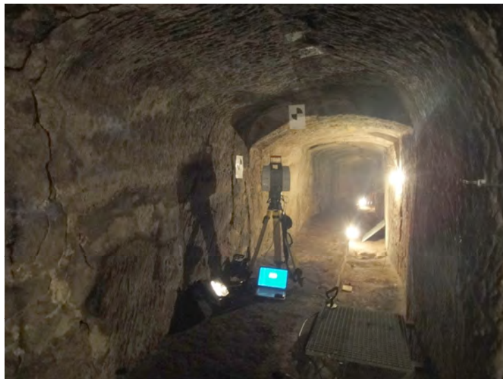
Abbildung 3: :Scanstation in Betrieb, Laptop, Kabeltrommel und Verbindungskabel im Messschatten des Scanners, Black/ White und Leica HDS Messmarken, Standort 16 hinter S-Kurve, Blickrichtung Süden.
