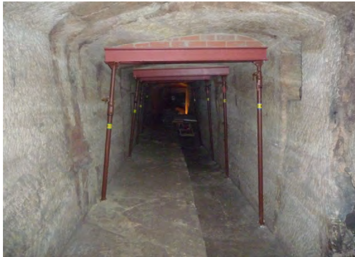
Abbildung 7: Vollständiges Schrägstützenpaar im Rappenkeller.
