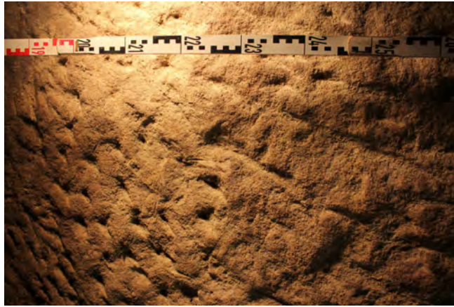
Abbildung 4: Bearbeitungsspuren an der Ostwand von Bauphase 1
