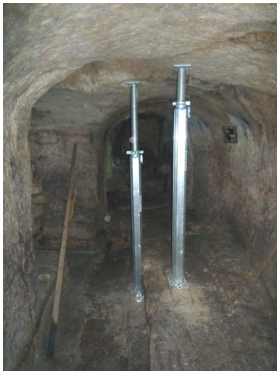
Abbildung 11: Schwerlaststützen aus Aluminium sichern große Felssegmente.
