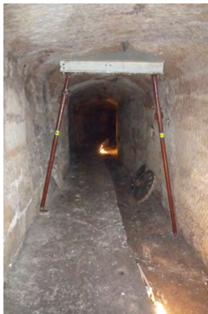
Abbildung 11: Schrägstützen mit Querträger im Rappenkeller.
