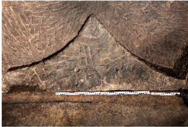
Abbildung 18: Abarbeitung im Deckenbereich (Blick von unten)
