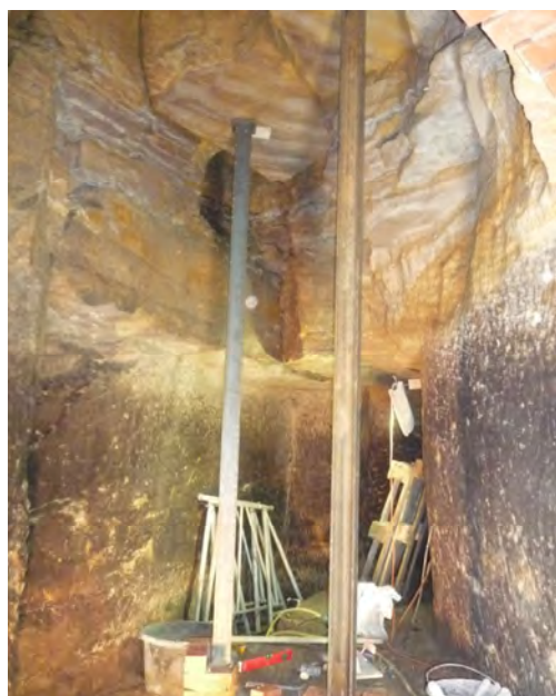
Abbildung 13: Stahlstützen als Kern der Druckkästen am Ende des Mittelgangs im Weiß-Tauben-Keller.
