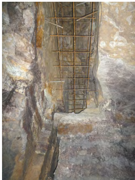
Abbildung 15: Stahlmatte zur Armierung von Spritzbeton in der Felsspalte von Plan Nr. 5.
