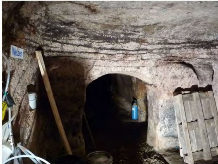
Abbildung 16: Östliche Fazies der Übergangsschichten im nördlichen Begleitgang. Der Durchgang bleibt im Bereich des Werksandsteins. Der Raum selbst ist über die markanten, schwarz ausbeißenden Tonlagen hinweg bis an eine grobkörnige, stabile Sandsteinlage gearbeitet.
