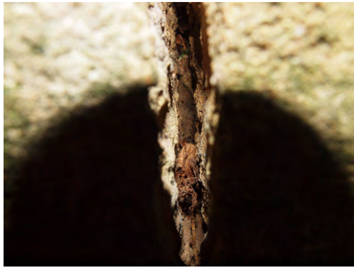
Abbildung 14: Über drei Quaderlagen reichender Riss in einer Sandsteinmauer, verursacht durch eine im Mauerfußbereich wurzelnde Linde.
