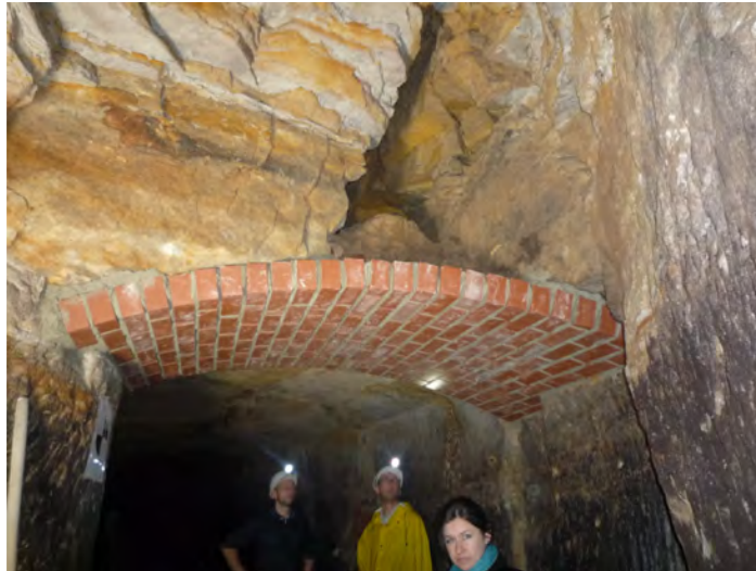
Abbildung 14: Neues Stützgewölbe im Weiß-Tauben-Keller an Plan Nr. 9.
