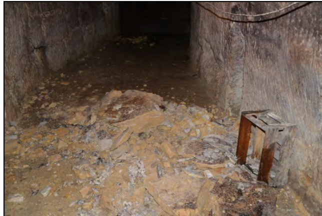
Abbildung 1: Großflächiger Firstfall im Südgang
