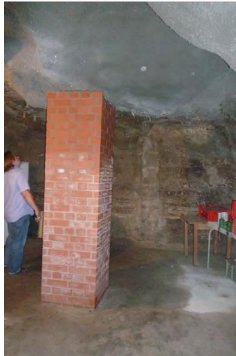
Abbildung 4: Stütze aus Ziegelmauerwerk und mit Spritzbeton verkleidete Decke im Schwanenkeller.
