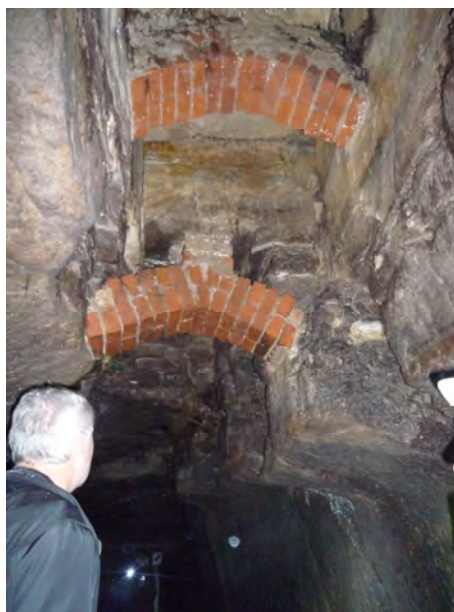
Abbildung 3: Historische Bogenkonstruktion im Weiß-Tauben-Keller.
