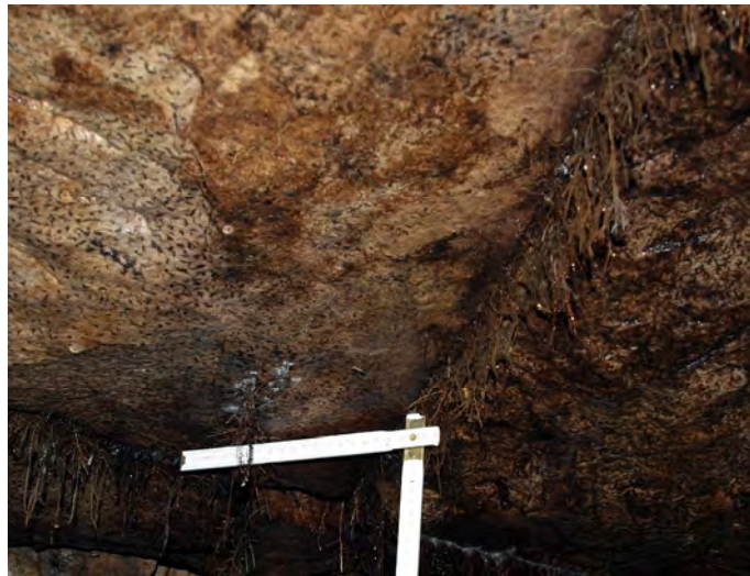
Abbildung 12: Baumwurzeln dringen besonders in den mit Ton gefüllten Klüften bis in die Keller vor.
