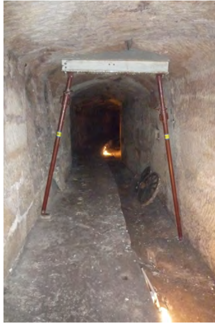
Abbildung 15: Schrägstützenpaar im Rappenkeller. Photo Rolf Snethlage.
