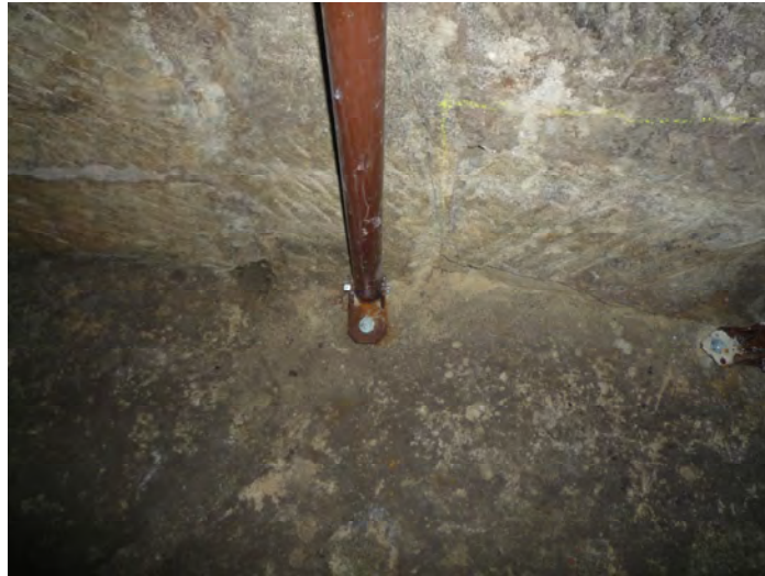
Abbildung 2: Verdübelung eines Schrägstützenfußes im Sandstein.
