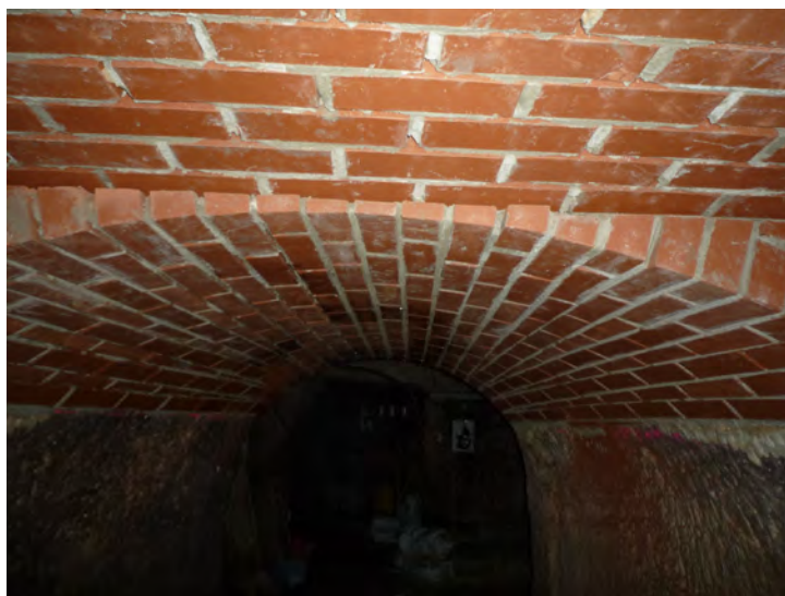
Abbildung 5: Neues Ziegelgewölbe im Weiß-Tauben-Keller.
