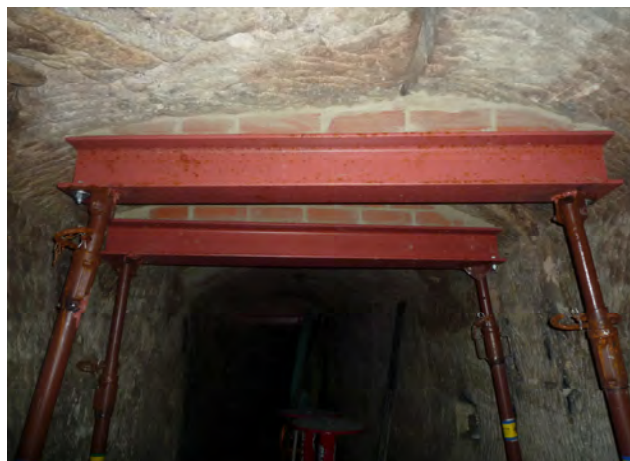
Abbildung 1: Schrägstützenpaar mit Querträger aus Stahl
