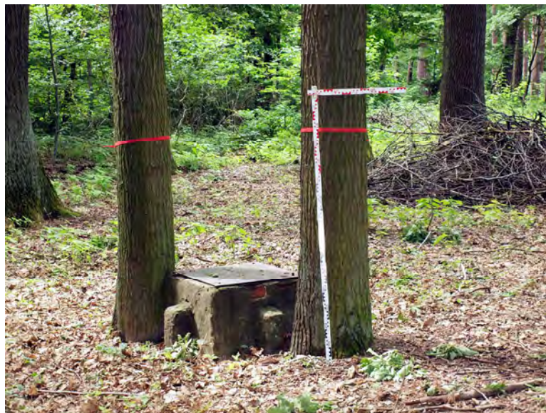
Abbildung 17: Zu dicht und zu nahe an den Lüftungsschächten stehende Eichen auf dem Weiß-Tauben-Keller.
