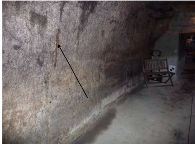
Abbildung 18: Hauptstollen; In einigen Kellerbereichen finden sich über mehrere Meter Strecke keine offenen Klüfte. Geschlossene Klüfte sind vielfach an Feuchteustritt und feinen Durchwurzelungen zu erkennen (Pfeil).
