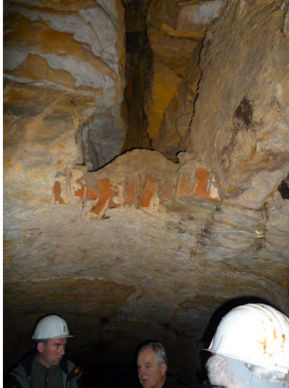
Abbildung 12: Ziegelgewölbe mit darüber liegendem, nicht verfülltem Hohlraum.
