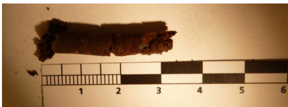
Abb. 40: Poröser, brüchiger und mit Carbolineum durchtränkter Bohrkern.
