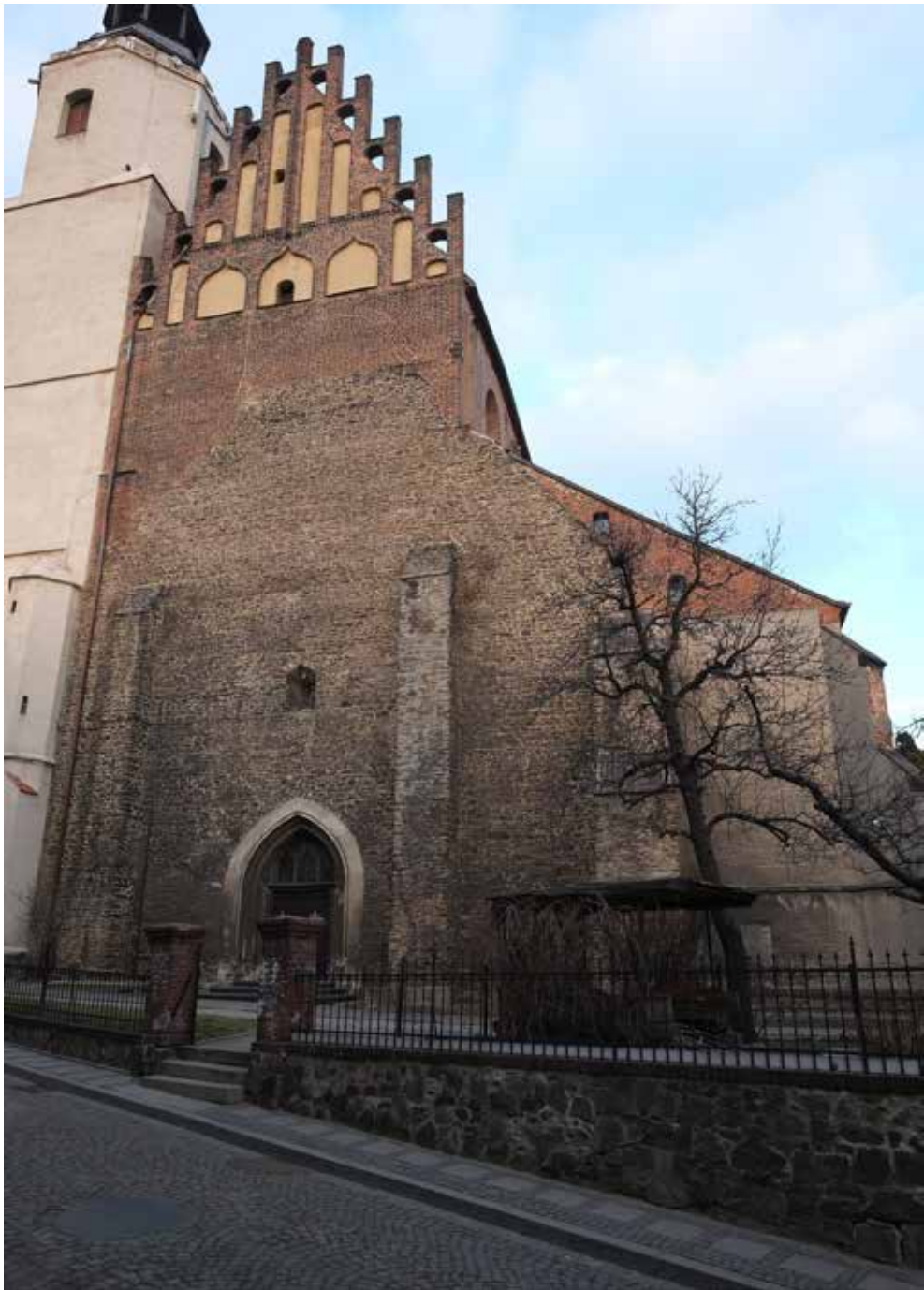
DZIERŻONIÓW (REICHENBACH), KOŚCIÓŁ ŚW. JERZEGO, ELEWACJA ZACHODNIA KOŚCIOŁA, PRZED PRZYSTĄPIENIEM DO PRAC KONSERWATORSKICH (FOT. T. LIGIĘZA)
