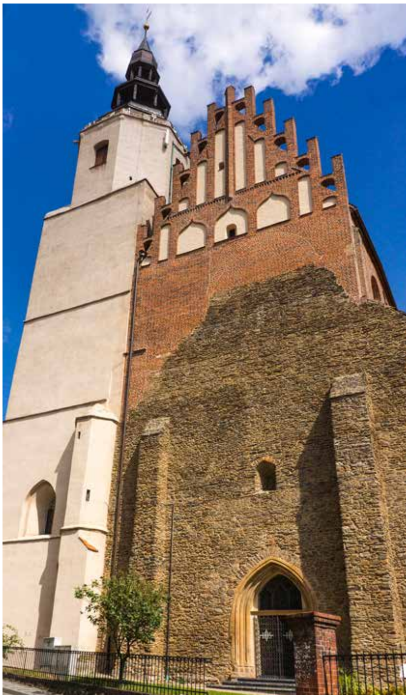
DZIERŻONIÓW (REICHENBACH), KOŚCIÓŁ ŚW. JERZEGO, ELEWACJA ZACHODNIA KOŚCIOŁA, PO PRZEPROWADZONYCH PRACACH KONSERWATORSKICH (FOT. T. LIGIĘZA)
