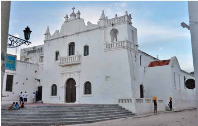
Abb. 4: Die Kirche Misericórdia auf Mozambique Island.
