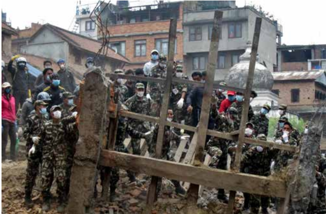
Abb. 4: Die Armee half überall; am vollständig beschädigten Radha Krishna Tempel in Patan retteten Armeesoldaten einige der Fragmente der Tempelanlage.
