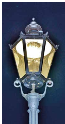
Abb. 1: Modelleuchte, auch „Schinkel-Laterne“ genannt, in Gebrauch von 1892 bis in die 1950er Jahre. Foto: Bertold Kujath
