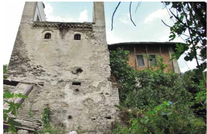
Abb. 7: Darstellung des Galanxhi-Hauses in der Nominierungsakte (links) und sein gegenwärtiger Zustand (rechts).
