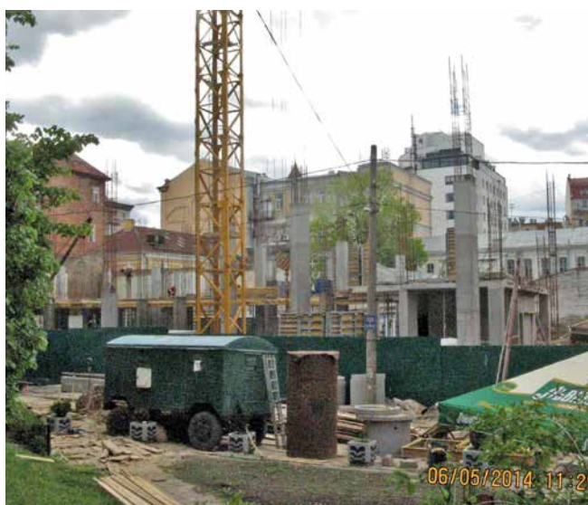
Abb. 3: Bau eines neuen Gebäudes, das an der 3-5 Desyatynny Lane begonnen wurde.
