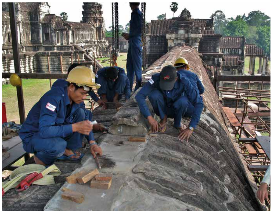
Fig. 2: Konservierung des Daches der „Quirlen des Milchozeans“-Galerie, 2009.
