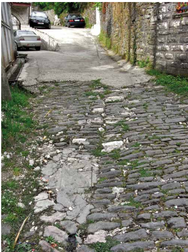
Abb. 8: Während es im ICOMOS Missionsbericht heißt: „Eine wesentliche Finanzierung von 85.000.000 Lekë wurde auch für die Wiederherstellung von Straßen in der Altstadt bereitgestellt“, sind diese Mittel tatsächlich verwendet worden, um historisches Kopfsteinpflaster mit Beton zu überdecken.
