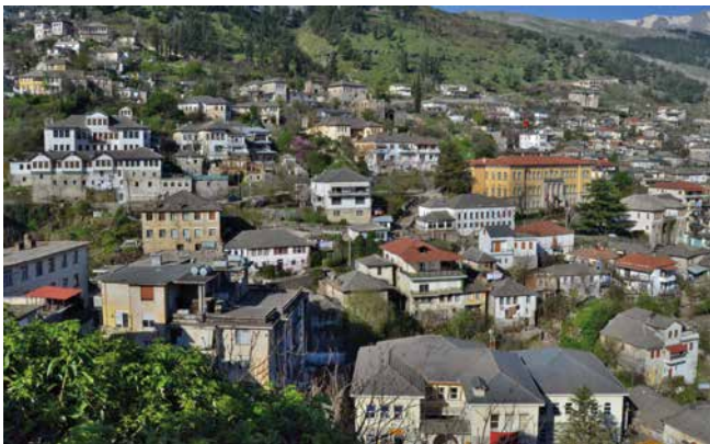
Abb. 6: Blick auf das Viertel Palorto, Gjirokastra. Der osmanische Charakter dieser Wohngegend ist durch Neubauten, rote Ziegeldächer und moderne Ergänzungen fast verlorengegangen.
