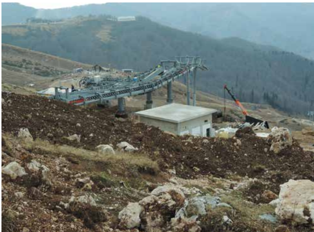
Abb. 2: Bau der Seilbahn zum Ski-Resort.
