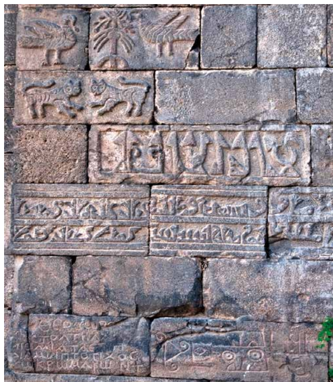
Abb. 2: Teile der Stadtmauer wurde mit Inschriften in verschiedenen Schriftarten und Sprachen ausgeschmückt, oft nebeneinander, und bezeugen die kulturelle Vielfalt, die die Stadt durch die Geschichte hinweg charakterisiert
