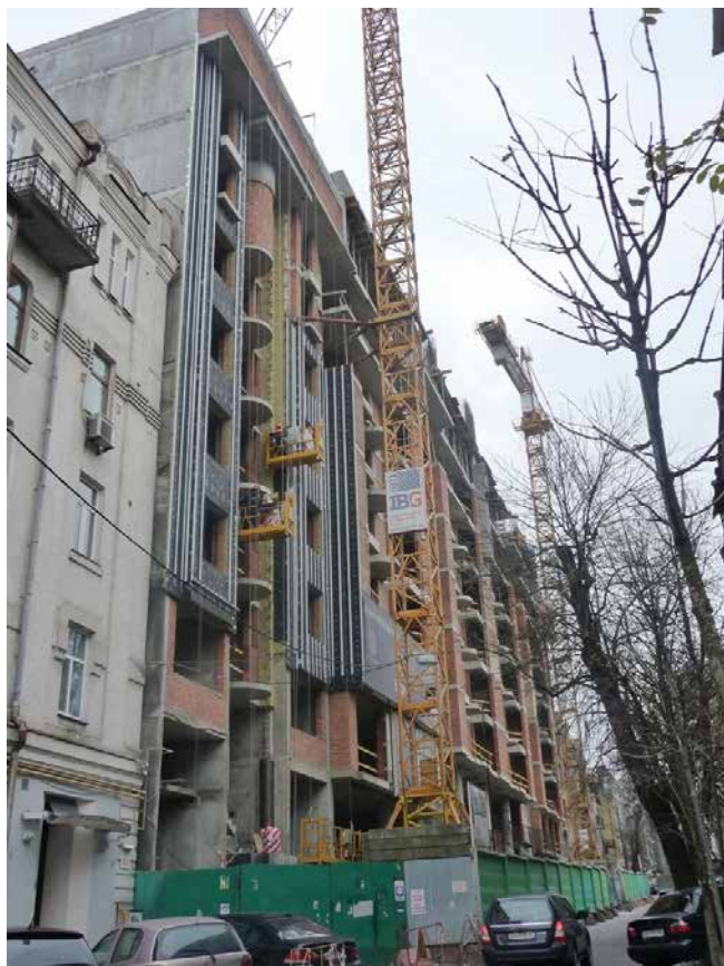
Abb. 2: Konstruktion eines unpassenden Gebäudes (17-23 O. Gontschara St.)
