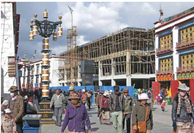
Abb. 5: Das Tsona-Tsongkhang-Haus, im Bau im Jahr 2013. Trotz seiner Nähe zum Jokhang-Tempel, einer UNESCO-Welterbestätte, und den Bemühungen zur Erhaltung der historischen Gebäude, ist die gängige Vorgehensweise zum Bewahren historischer Häuser weiterhin, historische Gebäude durch Neubauten zu ersetzen
