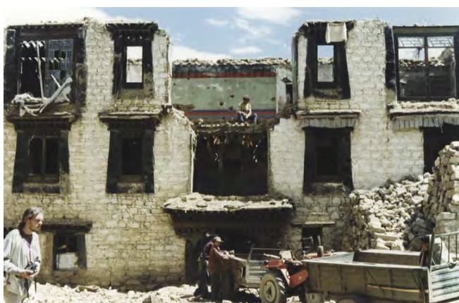
Рис. 3: В 1990-е годы сносилось около 35 традиционных зданий в год. На их месте построены новые четырёхэтажные дома. Фото: André Alexander / Tibet Heritage Fund
