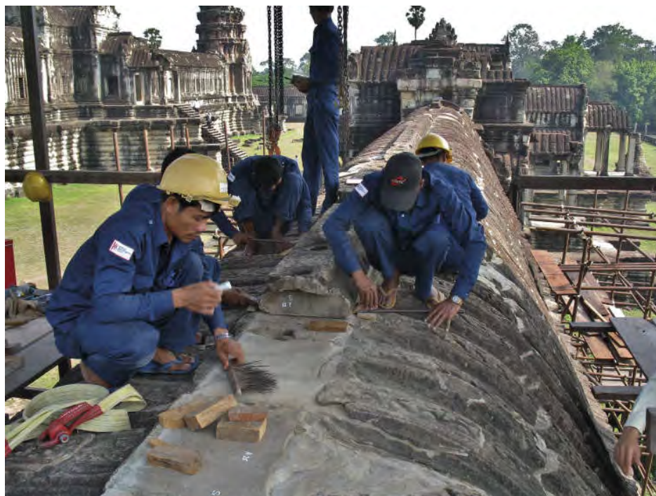
Рис. 2: Работы по консервации крыши (Churning of the Sea of Milk Gallery, 2009).
