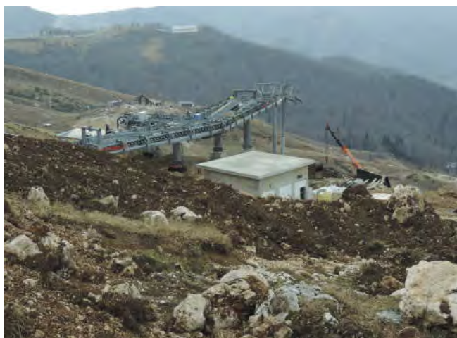
Рис. 2: Строительство подъёмника к горнолыжному курорту. Фото: Yulia Naberezhnaya
