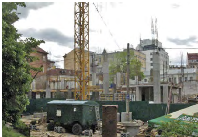
Рис. 3: Строительство нового здания в Десятинном переулке 3-5.
