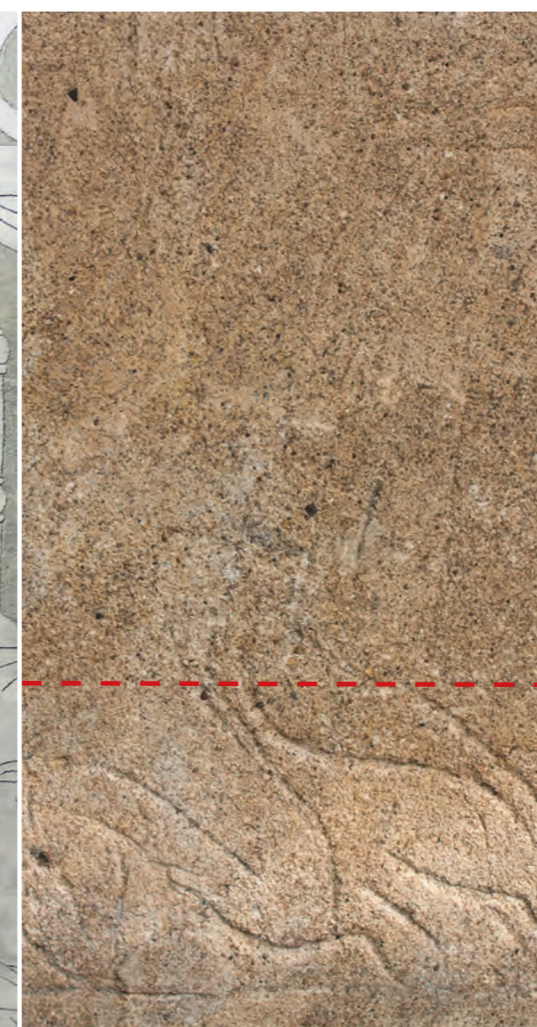
Abb. 5 Putzoberfläche im Streifenlicht (unteres Drittel)
