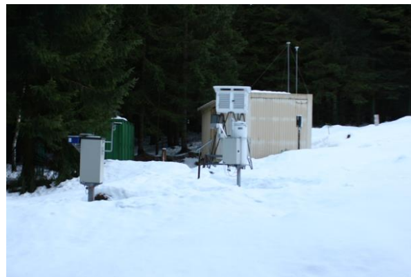
Abb. 7 Postamente im Zwischenlager
