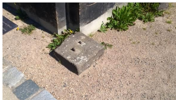
Abb. 63 Fundamentsockel an den Kentauren, die Funktion ist nicht eindeutig geklärt
