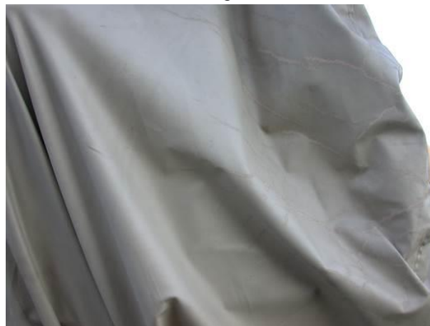
Abb. 76 Schloss Moritzburg, Materialermüdungserscheinungen
