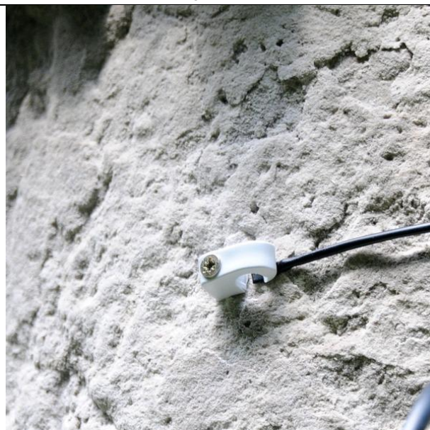
Abb. 115 NTC-Fühler zur Oberflächentemperaturmessung
