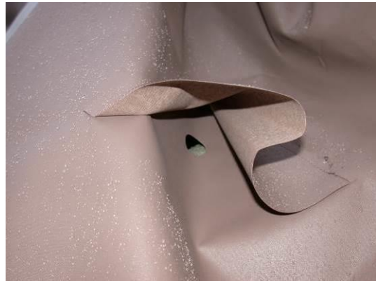
Abb. 80 Barockgarten Großsedlitz, Lüftungsloch
