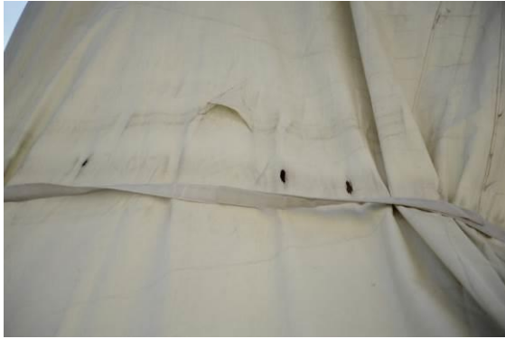
Abb. 111 Lochbildung unter Verschlussbank, Foto: ©Haselberger
