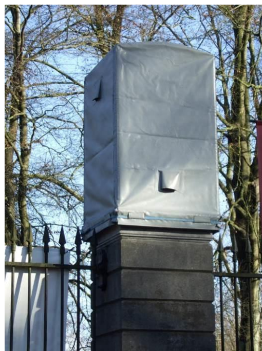
Abb. 53 Gerüstkonstruktion mit Bespannung am So- ckel befestigt, Brüssel, Stadtpark
