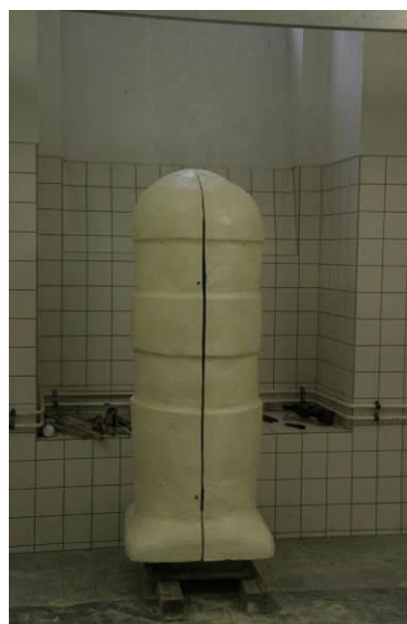
Abb. 39 Anlegen der Nahtstellen
