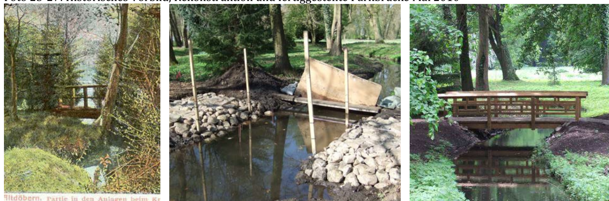
Foto 25-27: Historisches Vorbild, Rekonstruktion und fertiggestellte Parkbrücke Mai 2010
