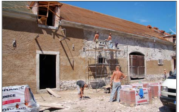
Der neue Außenputz
