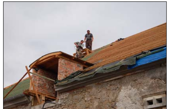
Das Dach wird eingedeckt
