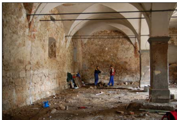
Der Fußboden wird abgetragen
