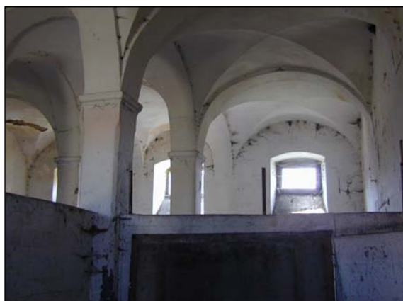
Trennwände aus den 70er Jahren
