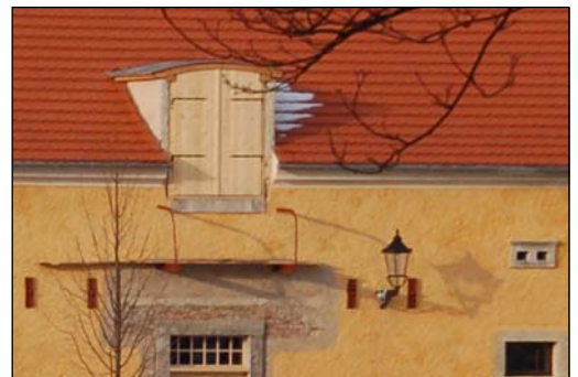
Dach nach der Sanierung
