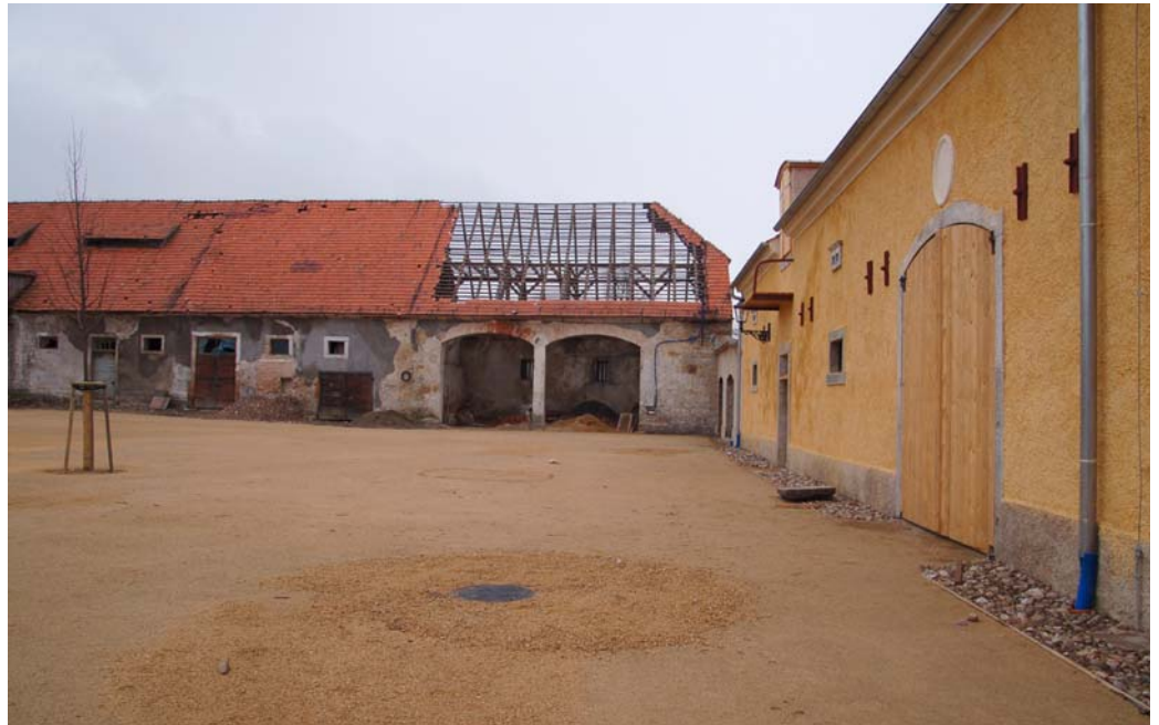
Blick auf den noch unsanierte Bereich des Gutshof
