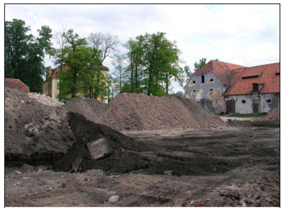
Beseitigung von Altlasten
