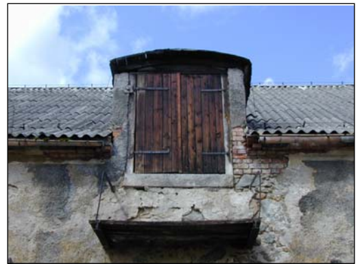
Dach vor der Sanierung
