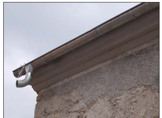
Der neue Sims mit der Dachrinne
