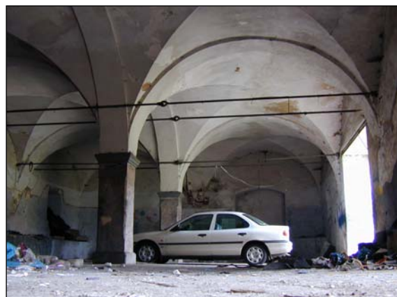
Autowerkstatt im Pferdestall
