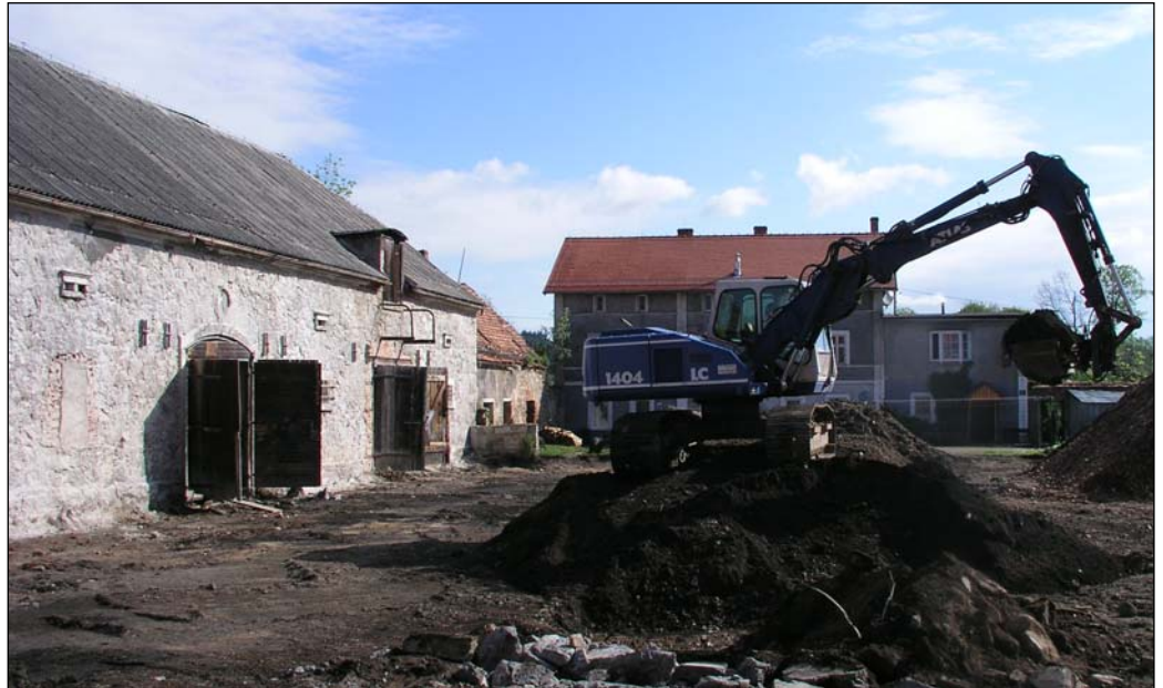
Räumungsarbeiten auf dem Hof
