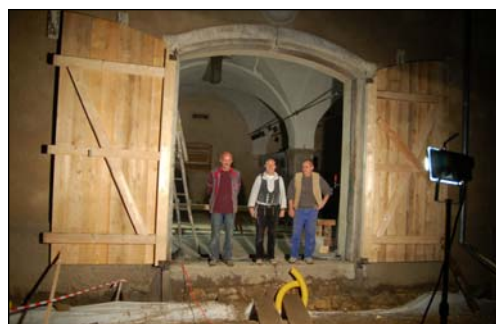
Das neue Haupttor wird eingebaut
