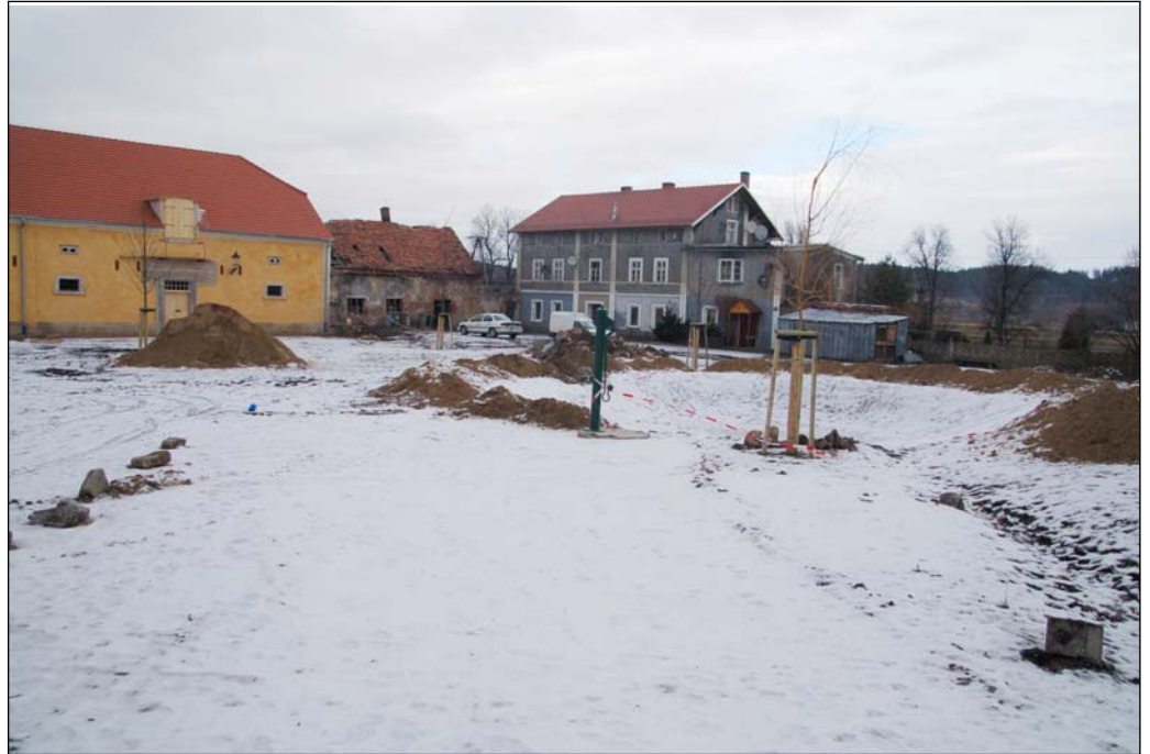
Der Hof mit dem vorbereiteten Teich und der neuen Pumpe
