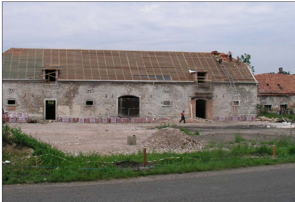
Das Dach wird gedeckt
