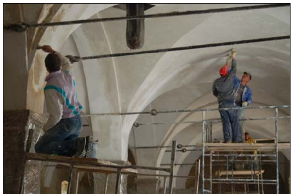
Putzarbeiten im Inneren
