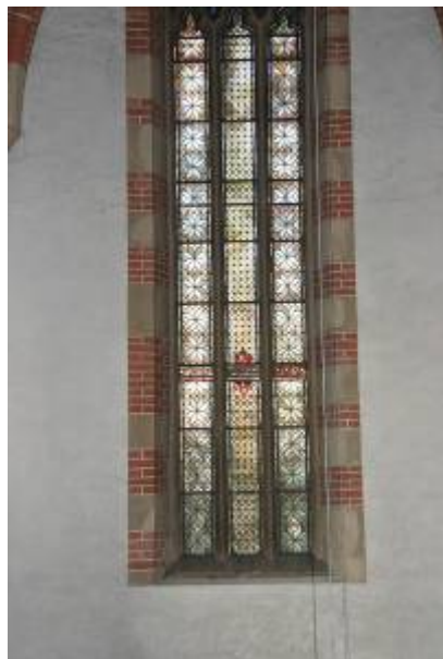
Abb. 81 Nordwand, Fenster im 3. Joch von Westen
