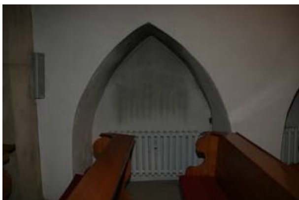
Abb. 20 Verschwärzung über Heizkörper
