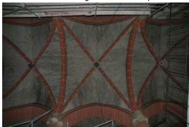
Abb. 29 Gewölbeverschmutzung
