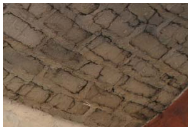
Abb. 41 Risse zwischen Fuge und Ziegel intensiv verschwärzt
