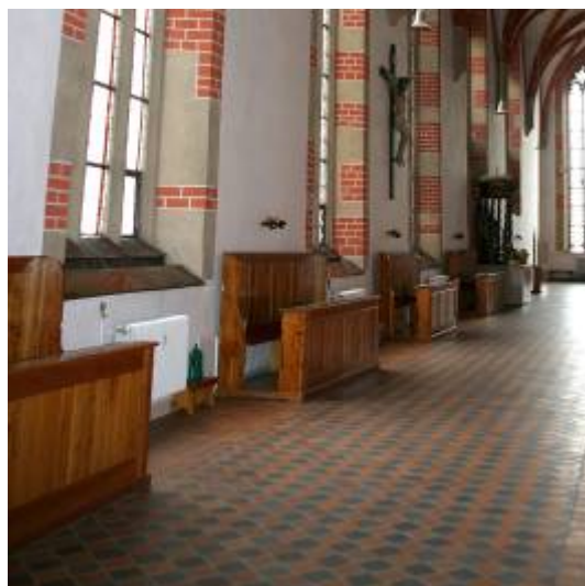
Abb. 53 Gussheizkörper im Kirchenschiff, Einbauort: 5x an der Südwand auf der Chorgasse, 2x an der Westwand auf der Chorgasse und der Nonnenempore, Nr. 7
