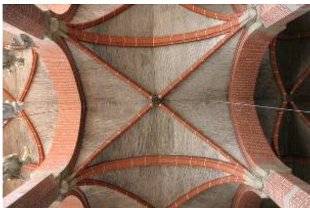
Abb. 28 Gewölbeverschmutzung
