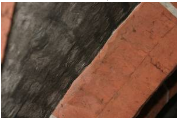
Abb. 30 Gewölbeverschmutzung
