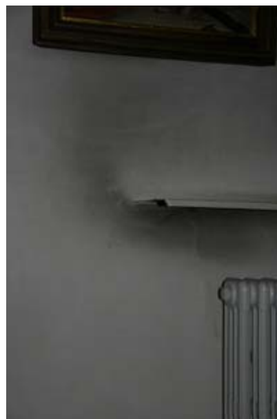
Abb. 23 Abdeckblech oberhalb eines Heizkörpers
