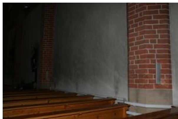
Abb. 21 Vergrauung über gesamte Wandfläche
