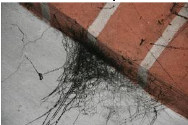
Abb. 32 Rußgeschwärztes Spinnweb im Gewölbe
