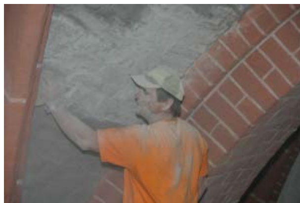
Abb. 43 Reinigung im Gewölbe
