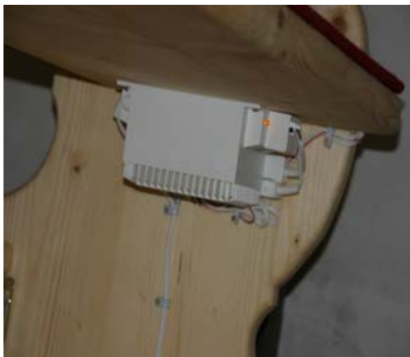
Abb. 138 Trafo unter der Musterbank
