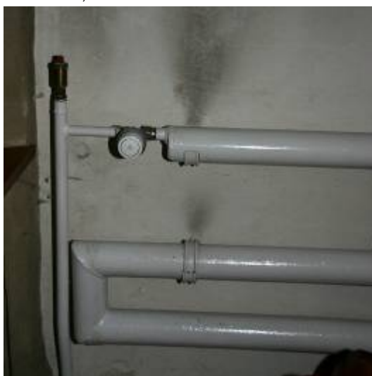
Abb. 51 meanderförmig verlegte Heiztrasse, Durch- messer 8 cm, Einbauort: an Südwand im 3. und 4. Joch, Nr. 5
