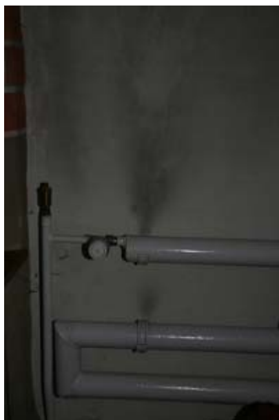
Abb. 22 Schwarzfärbung über Heizrohrbefestigung
