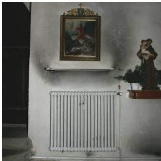
Abb. 47 Gussheizkörper im Kirchenschiff, Einbauort: 8x Nordwand, 1x hinter Altar, Nr. 1 in Abb. 45
