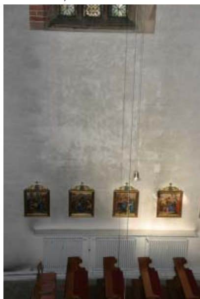
Abb. 83 Nordwand, Heizkörper im 3. Joch von Westen
