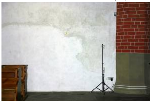
Abb. 91 Südwand, rechts vom Chorgestühl
