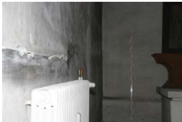
Abb. 27 Verschwärzung oberhalb Heizkörper
