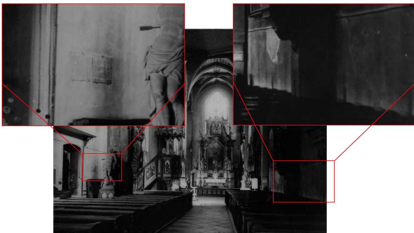
Abb. 18 Blick in die Klosterkirche, 1965, die Ausschnittvergrößerungen zeigen deutlich die Schmutzfahnen an den Wänden
