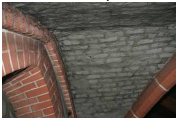
Abb. 33 Fugennachzeichnende Gewölbeverschmutzung
