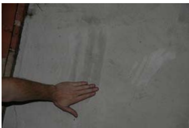
Abb. 38 Verschwärzung verschmiert auf der Oberfläche
