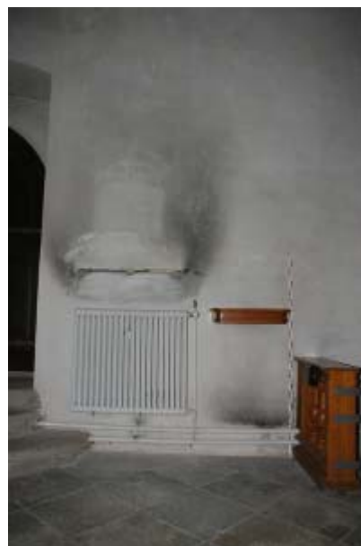
Abb. 25 nach Abbau des Bleches
