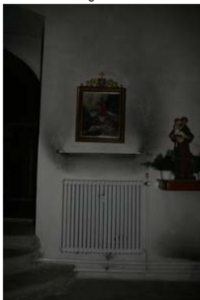
Abb. 24 Schwarzfärbung über Heizrohrbefestigung
