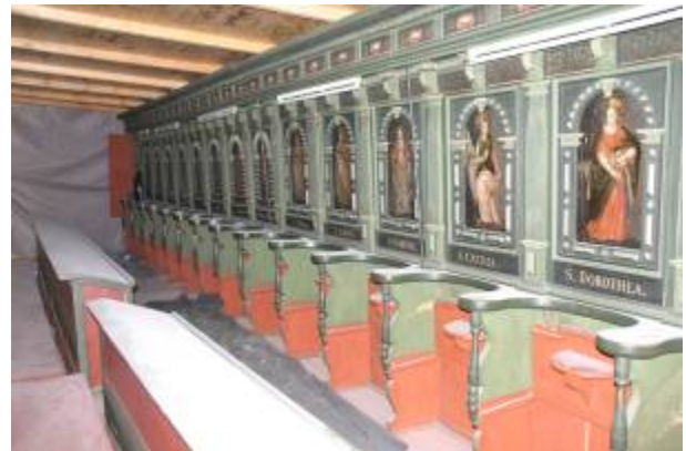
Abb. 124 Gestühl während der Baumaßnahme
