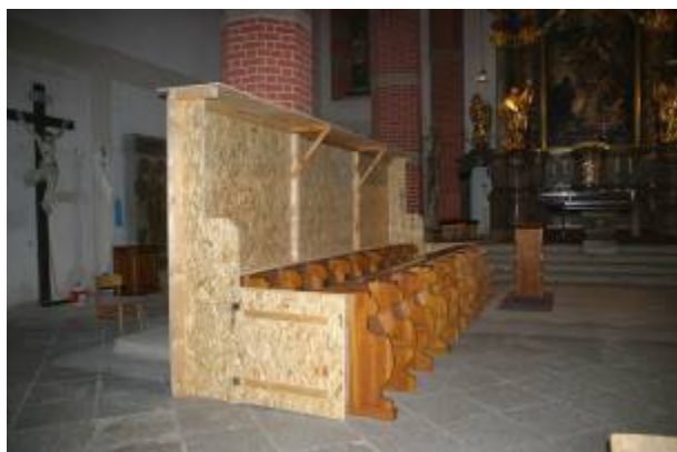
Abb. 127 Provisorischer Testumbau am Chorgestühl, Nordseite, mit Seitentür
