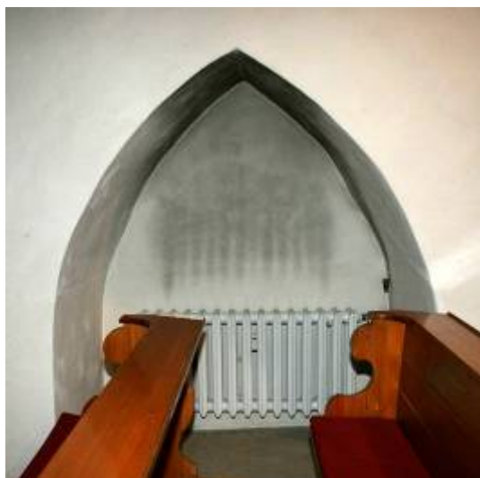
Abb. 52 Gussheizkörper im Kirchenschiff, Einbauort: 2x an der Südwand unter Empore in Wand- nischen, Nr. 6
