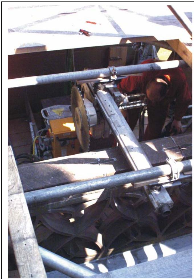
Einrichten und Befestigen der Schienentraverse mit einem gebauten Adapter.
