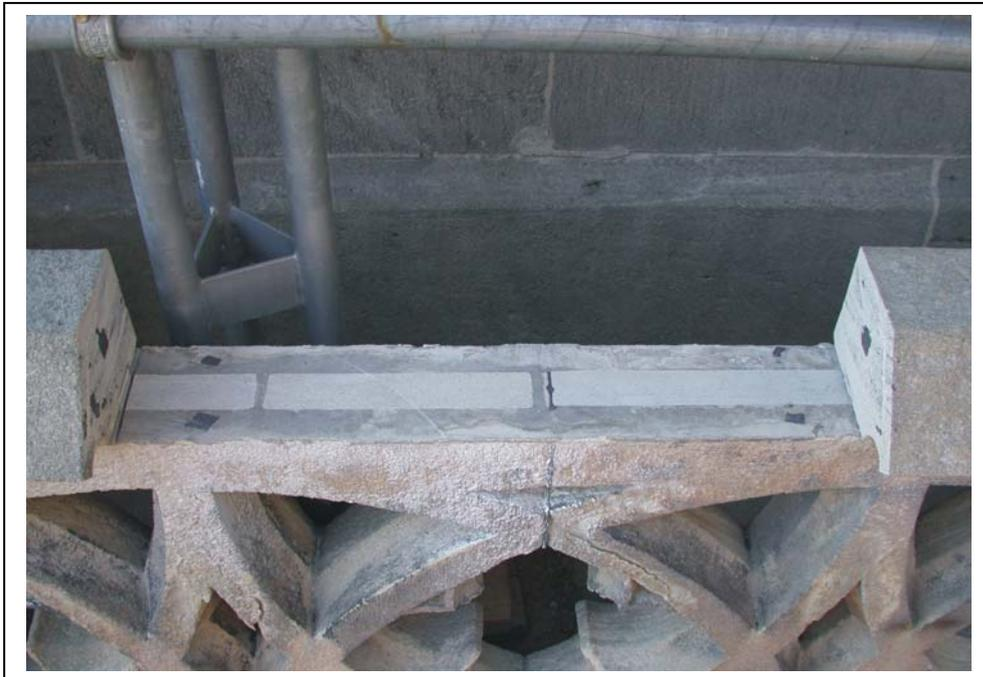
Zusätzlich wurden Testschnitte mit dem Elektrofuchsschwanz der Firma Elu MSS 810 E am südlichen Chorturm sowie im Hof der Münsterbauhütte Ulm durchgeführt.
