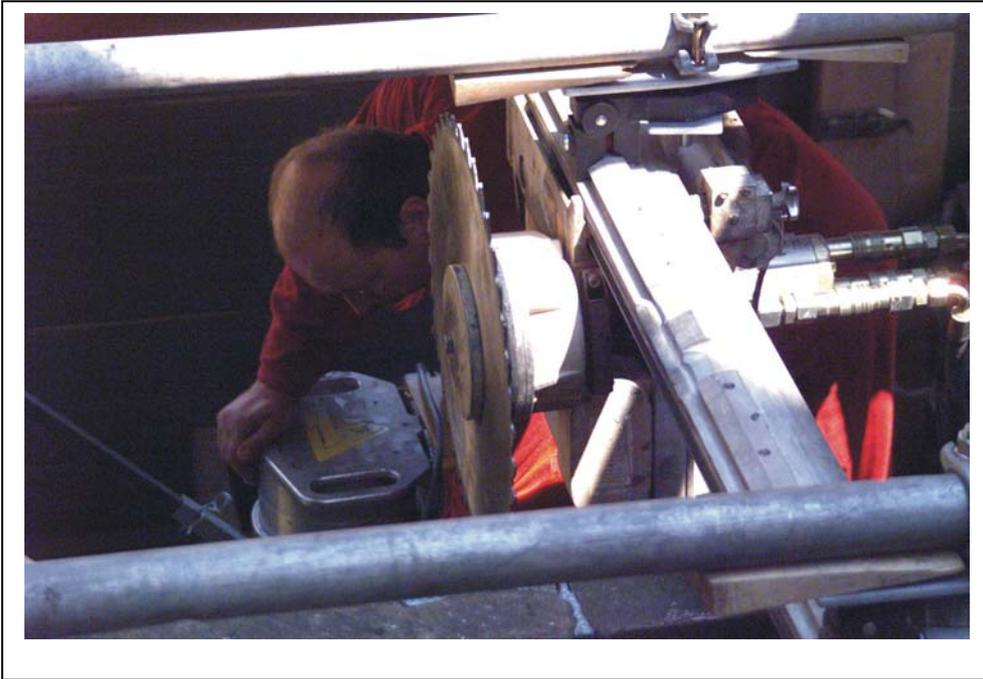
Zusammenbau der hydraulisch angetriebenen Wandsäge am Einsatzort.
