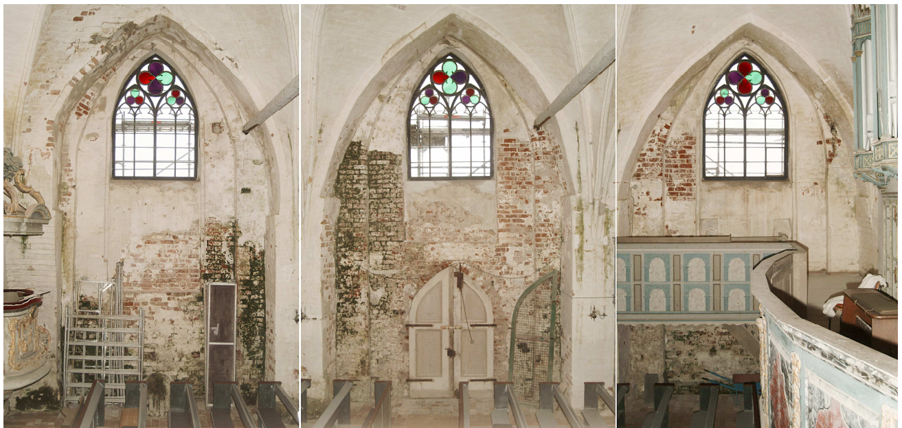
Abb. 1: Grünalgenbefall an der Südwand des Langhauses im Sommer 2007. In den Bereichen mit freiliegender Mauerwerksoberfläche wurde 1995 eine zementäre Putzschlamm entfernt.
