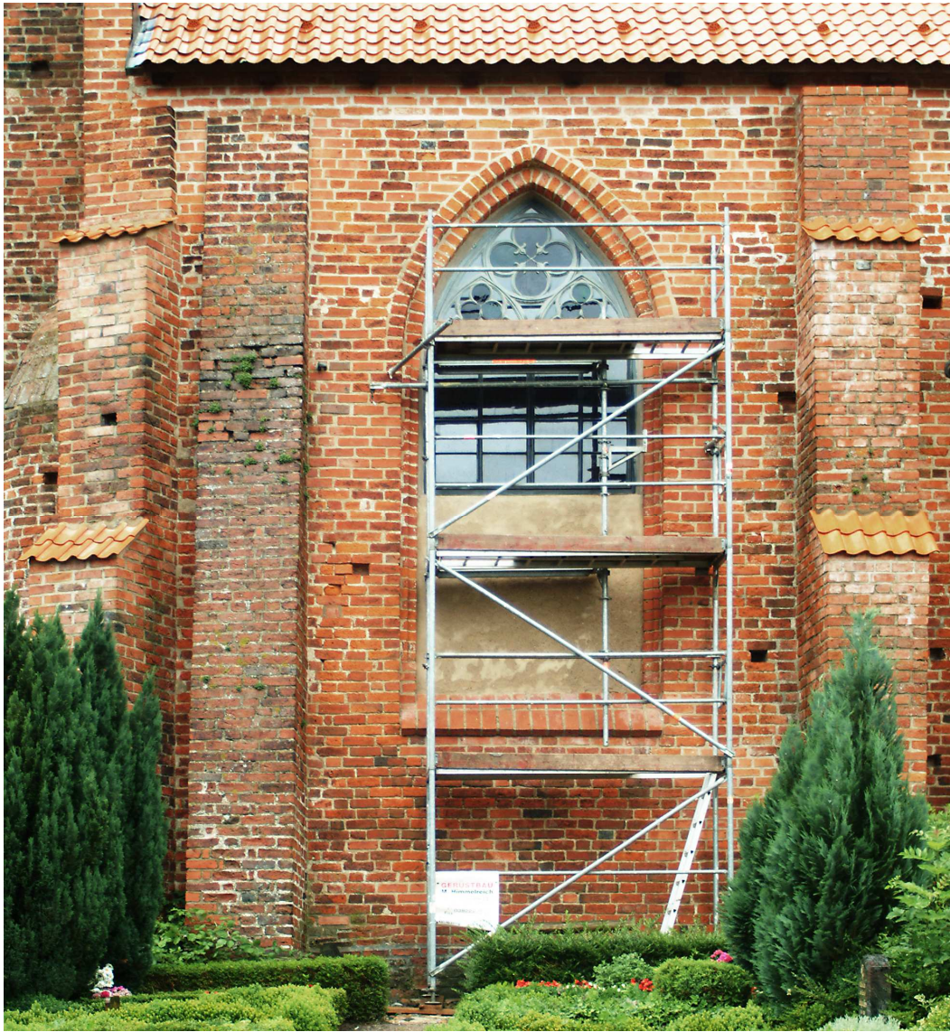
Abb. 2: Südwand des Langhauses, 1. Achse. Infolge des geringen Dachüberstandes und der fehlenden Dachentwässerung sind die Strebepfeiler vollständig dem Ablaufwasser des Daches ausgesetzt. Ein besonderes Problem stellen dabei die schrägen Flanken der vermutlich im 18. Jahrhundert ergänzten Pfeiler in der 1. und 2. Achse dar.
