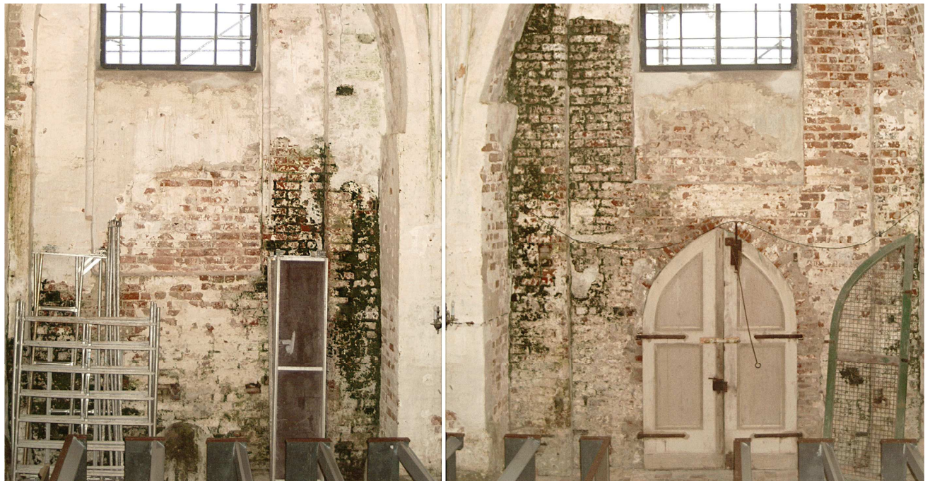
Abb. 10: Grünalgenbewuchs an Südwand im Bereich des Pfeilers zwischen dem 2. und 3. Langhausjoch. Ein Vergleich mit Abb. 9 zeigt keine durchgehende Korrelation zwischen Algenbewuchs und Materialfeuchte. Dies kann beispielsweise an abweichenden Materialfeuchten an der für den Algenbewuchs relevanten unmittelbaren Oberfläche liegen, da durch die Mikrowellensonde prinzipiell Materialfeuchten bis in 30cm Tiefe erfaßt werden. Insbesondere im Bereich der auf ca. 50cm ausgedünnten Wandbereiche der Fensterbrüstungen könnte gegenüber den mutmaßlich dauerfeuchten stärkeren Wandbereichen auch eine periodische Abtrocknung das Algenwachstum erschweren.
