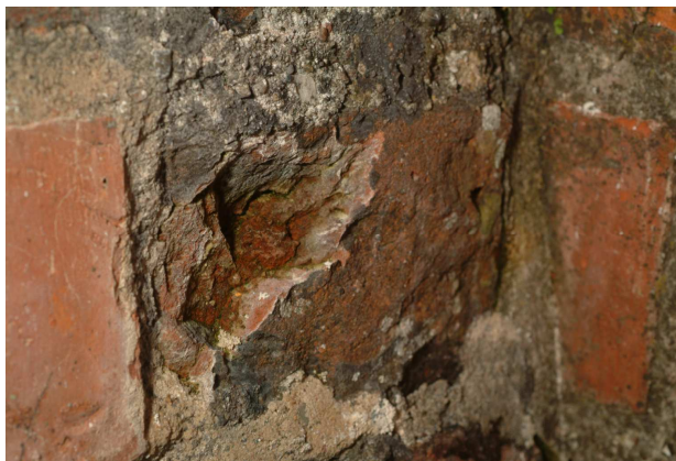
Abb. 3: Maueroberfläche an der schrägen Pfeilerflanke in der 2. Achse der Südwand des Langhauses im August 2007. Bereits 5mm unter der trocken erscheinenden Oberfläche ist mit bloßem Auge die Nässe im Mauerwerk erkennbar.
