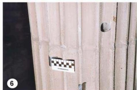
**Abb. 1:** Bohrkern IV, 1.Pfeiler von links, Bohrkerntiefe 94 mm, Ø 30 mm.
