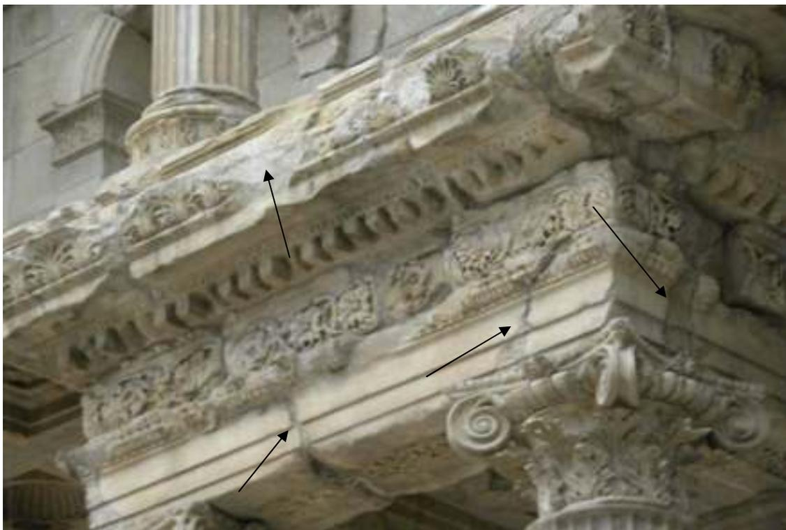
Bild 1: Durchlaufende Risse in Stahlbetonplatten und Marmorverkleidungen
