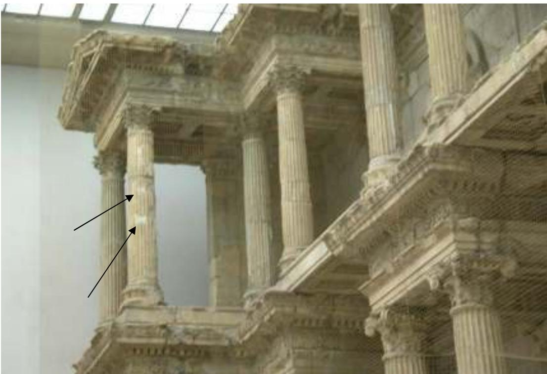
Bild 3: Druckinduzierte Abplatzungen (Pfeile) an den Marmorsäulen
