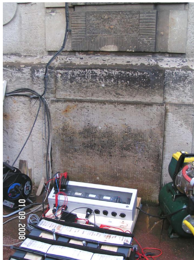
Abbildung 18: Aufbau der Pilotsalzminderung im Dresdner Zwinger
