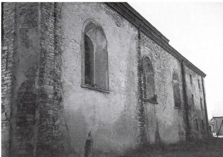
II.8. Elewacja północna (najbardziej zniszczona). Duże ubytki tynku, większe zawilgocenie ścian, małe nasłonecznienie
