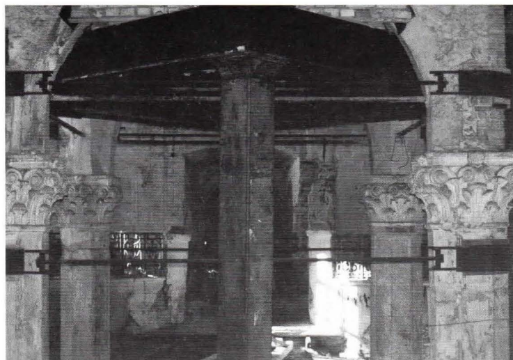
Il. 10. Stalowa konstrukcja wzmacniająca bime
