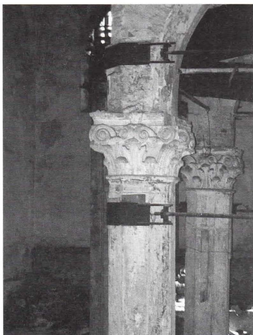
Il.11. Filar bimy i ściagi stalowe
