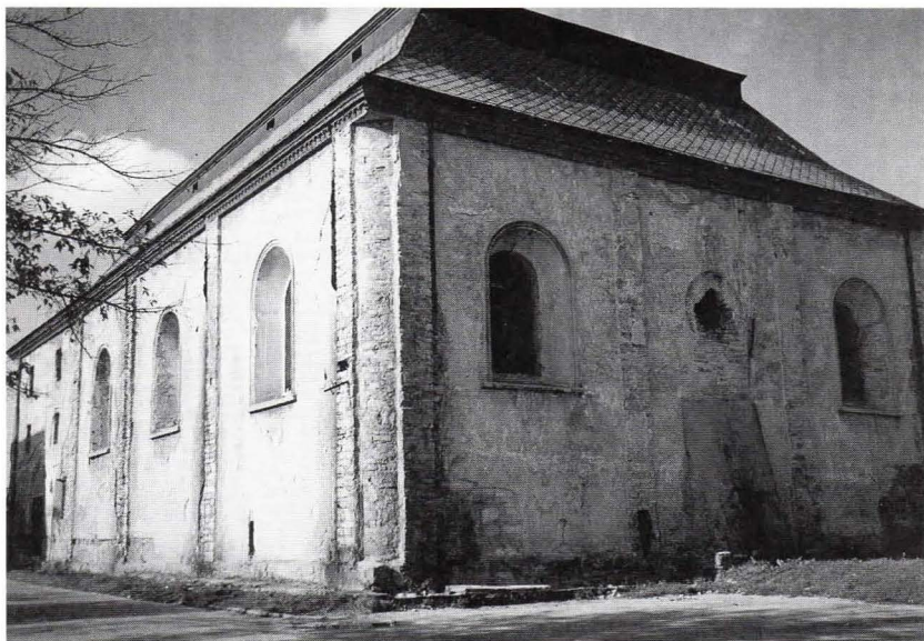
Il. 6. Widok na elewację południową i wschodnią
