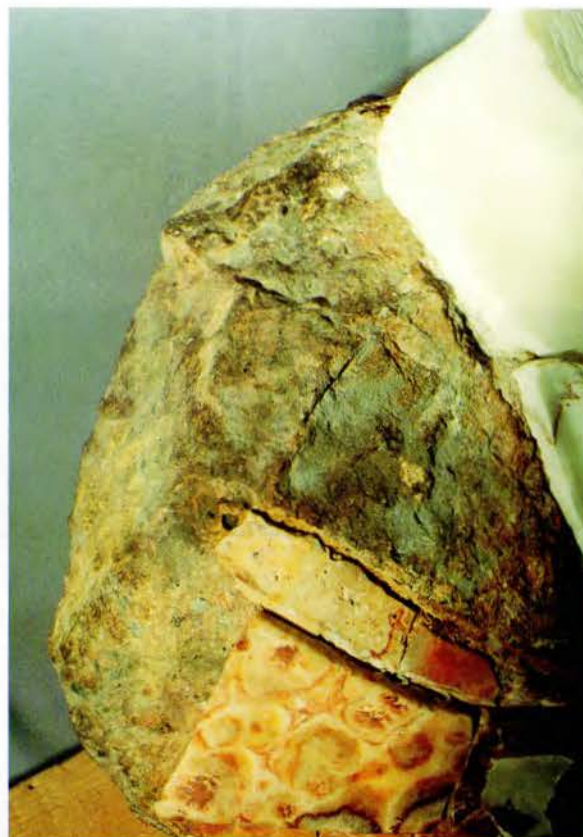
Il. 7. Zakres ubytków kamiennych okładzin z prawej strony biustu
