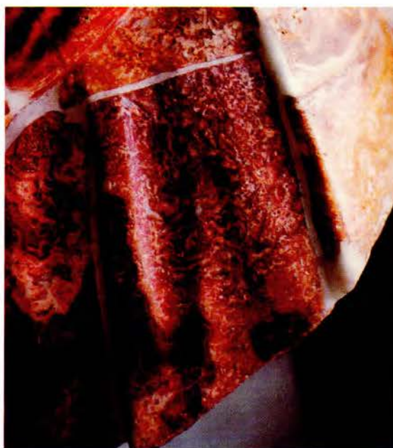
Il. 15. Okładziny kamienne. Stan po konserwacji
