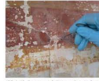
ICO 1419 - Percement à l'intersection de fissures pour préparer l'injection du coulis
